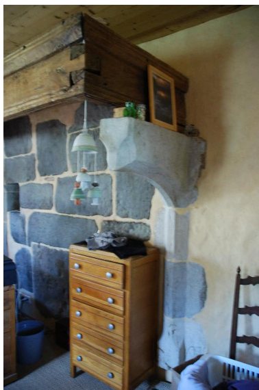
Vue intérieure du logis : Détail de la console de la cheminée Phot. Thierry Monnet IVR82_20167301920NUCA
