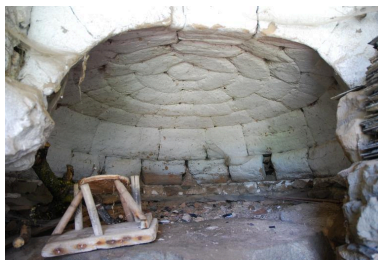
Vue intérieure du four à pain. Phot. Thierry Monnet IVR82_20167301922NUCA
