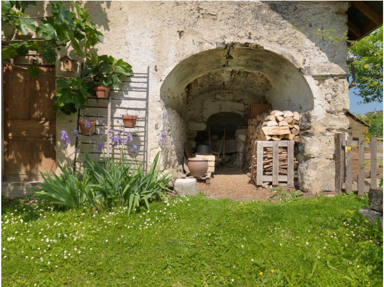
Vue partielle du four à pain de face.
