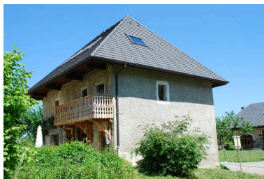
Vue d'ensemble de trois-quart avant-droit du logis. Phot. Thierry Monnet IVR82_20167301914NUCA
