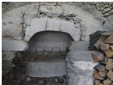
Vue d'ensemble de la bouche du four à pain. Phot. Eric Dessert IVR82_20137302033NUCA
