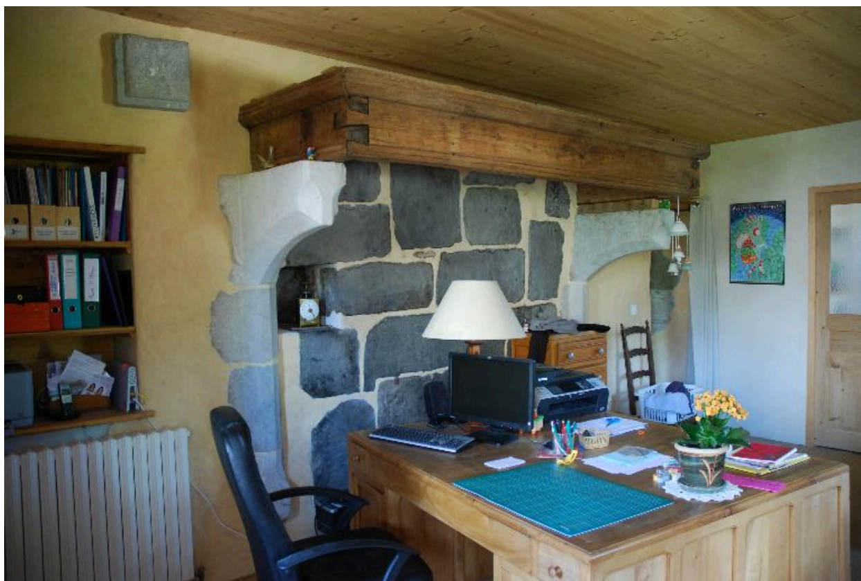
Vue intérieure du logis : cheminée avec piédroit et console.
