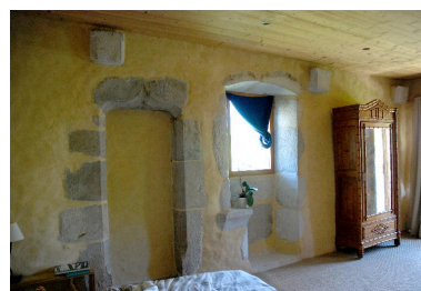
Vue intérieure du logis : porte ancienne et fenêtre à coussiège. Phot. Thierry Monnet IVR82_20167301918NUCA
