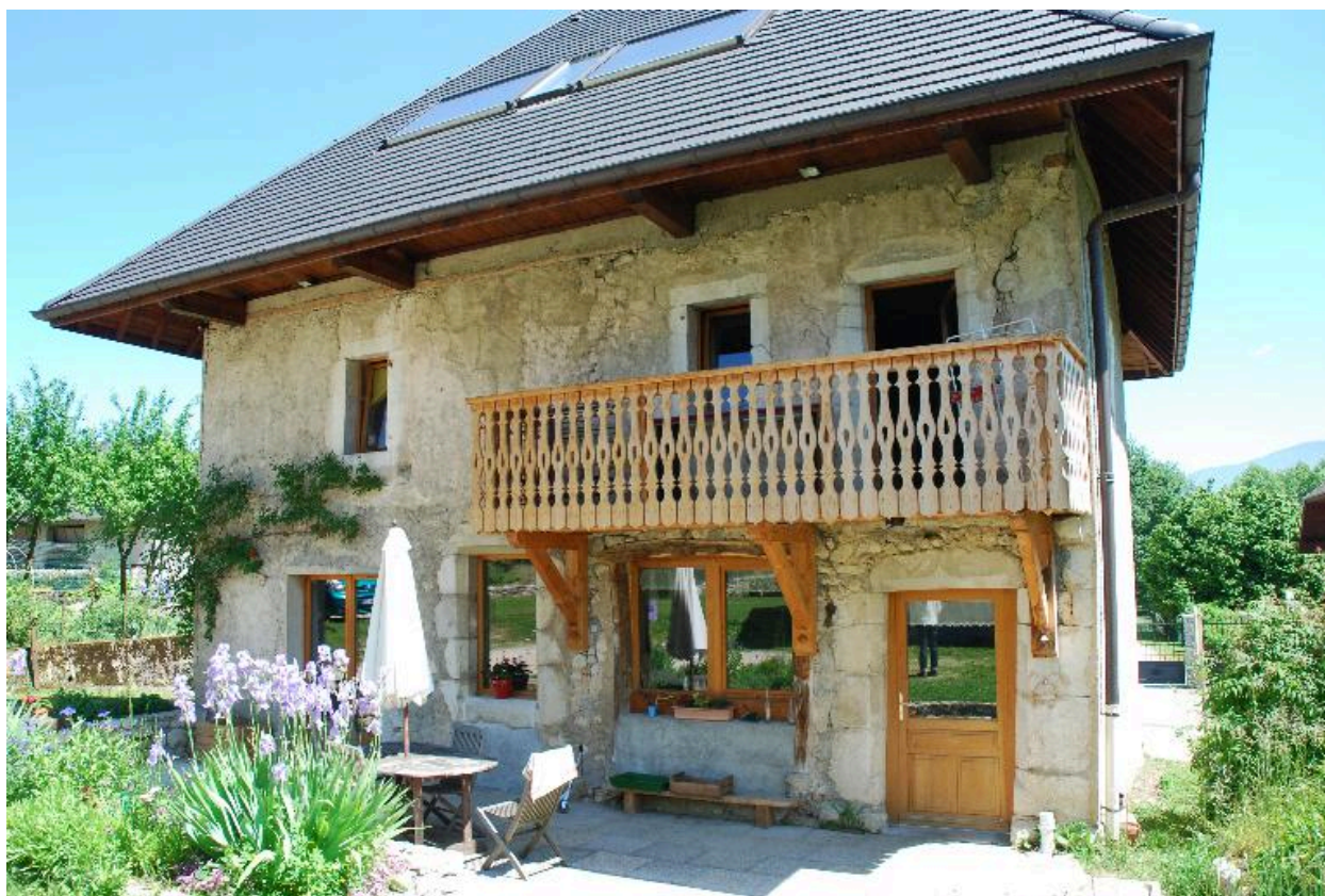
Vue d'ensemble de face du logis .
