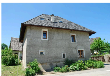
Vue d'ensemble arrière du logis Phot. Thierry Monnet IVR82_20167301917NUCA
