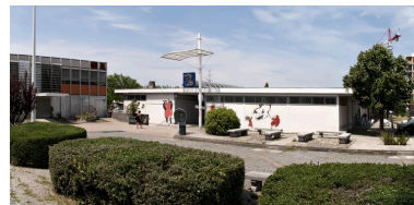
Façade sud Phot. Julien Defillon IVR82_20106901152NUCA
