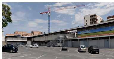
Façade arrière ouest Phot. Milène Jallais IVR82_20106901151NUCA
