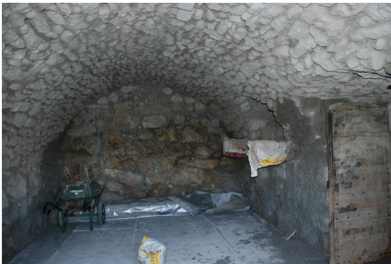
Vue intérieure de la partie voûtée.
