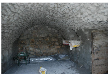
Vue intérieure de la partie voûtée. Phot. Thierry Monnet IVR84_20167304494NUCA
