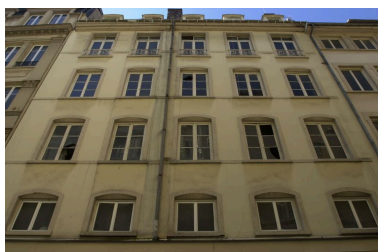
Façade sur rue, vue par-dessous à partir du niveau de l'entresol Phot. Bernard Ducouret IVR82_20046900879NUCA
