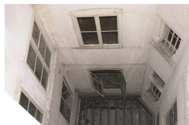
Cour orientale vue depuis le haut de l'escalier principal ; galeries au fond, pan coupé de l'escalier en vis à droite Phot. Bernard Ducouret IVR82_20046900880NUCA
