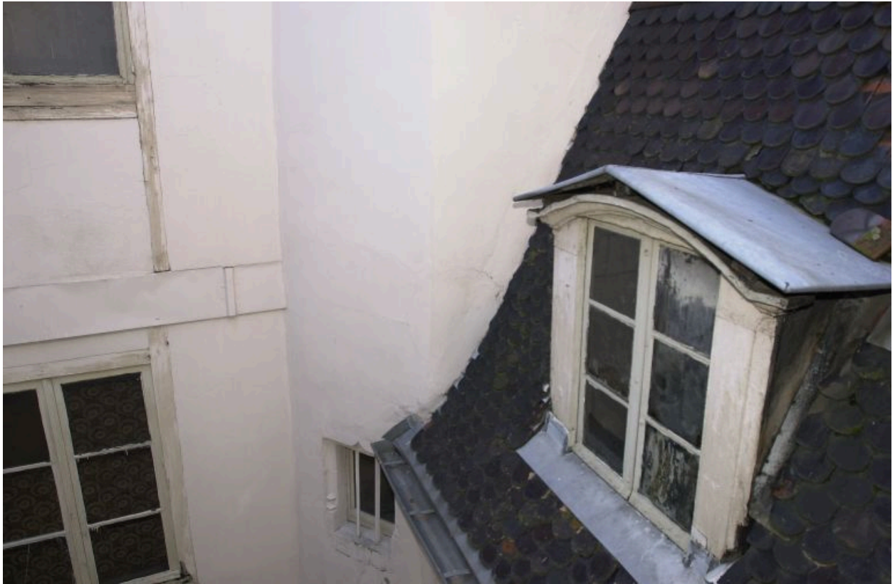
Cour orientale, lucarne du corps arrière et tour de l'escalier en vis
