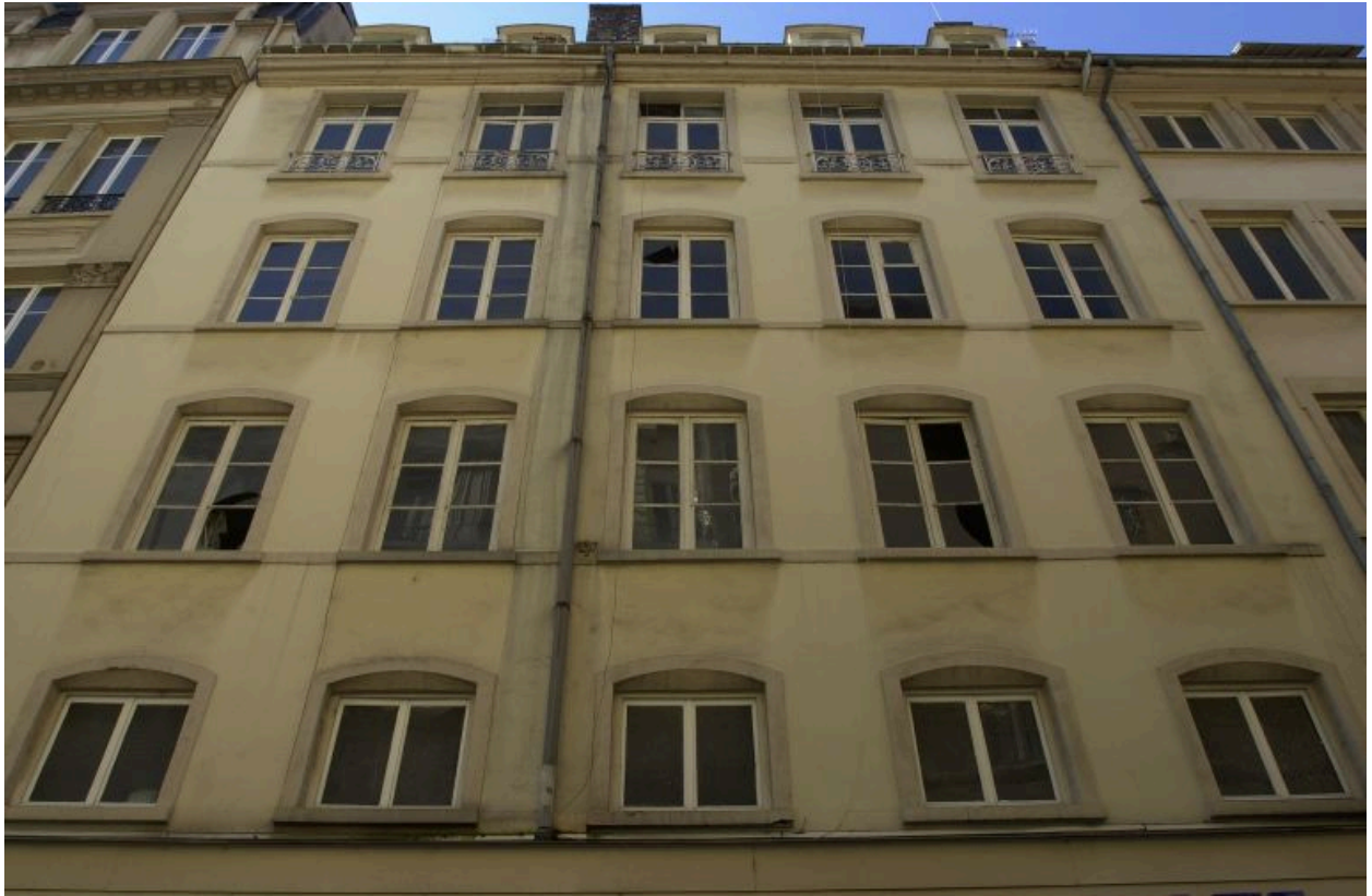
Façade sur rue, vue par-dessous à partir du niveau de l'entresol
