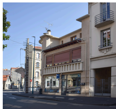
Façade sur l'avenue Marx-Dormoy Phot. Félicie Fougère IVR84_20246302187NUCA
