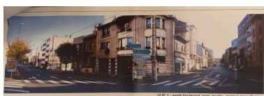
Façades sur l'angle du boulevard Jean-Jaurès et de l'avenue Marx-Dormoy Repro. Félicie Fougère , Autr. DHA Architectes - urbanistes IVR84_20256301519NUCA
