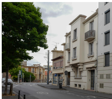
Débouché de l'avenue Marx-Dormoy sur le boulevard Jean-Jaurès Phot. François-Nicolas L'Hardy IVR84_20256301527NUCA
