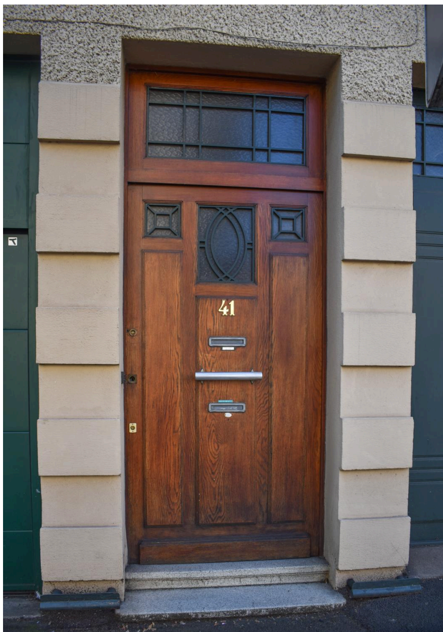
Porte d'entrée sur le boulevard
