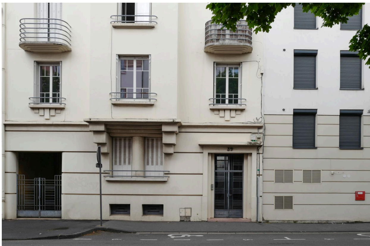
Détail d'architecture, façade, rez-de-chaussée et premier niveau
