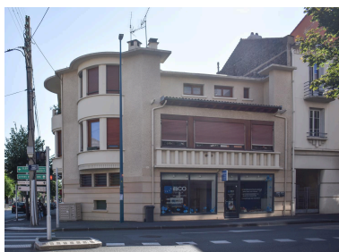
Façade sur l'avenue Marx-Dormoy Phot. Félicie Fougère IVR84_20246302185NUCA
