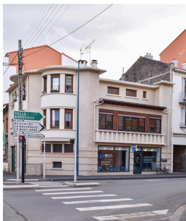
Façade sur l'avenue Marx-Dormoy Phot. Félicie Fougère IVR84_20246302184NUCA
