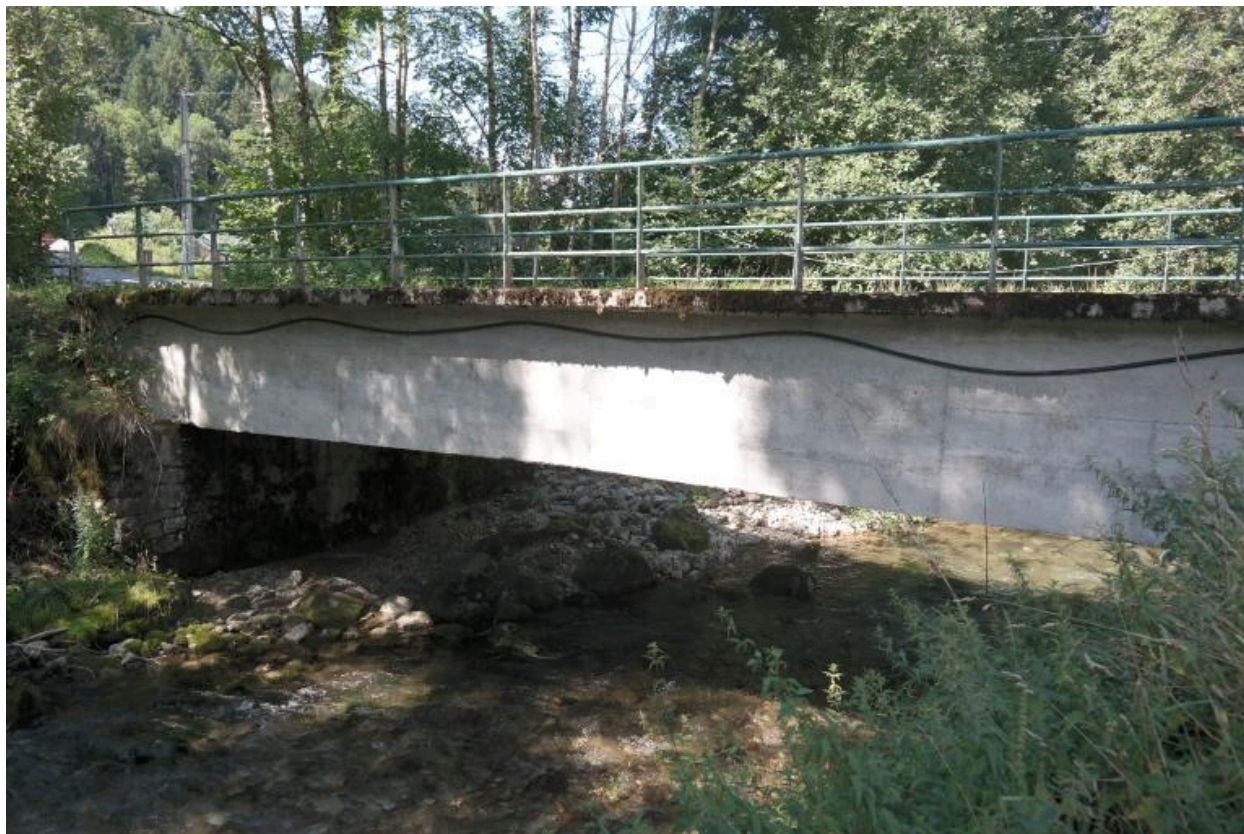
Pont de Passengué, face amont
