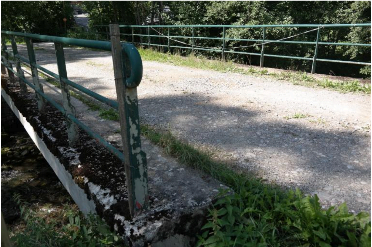
Pont de Passengué, détail de la rambarde et de la chaussée
