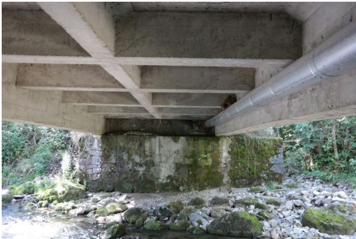
Pont de Passengué, vue de dessous
