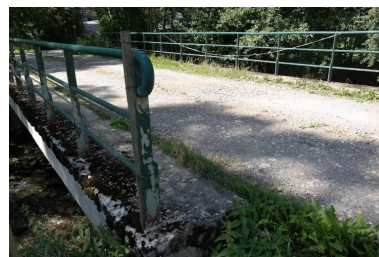
Pont de Passengué, détail de la rambarde et de la chaussée Phot. Pascale Renard IVR84_20207400939NUCA
