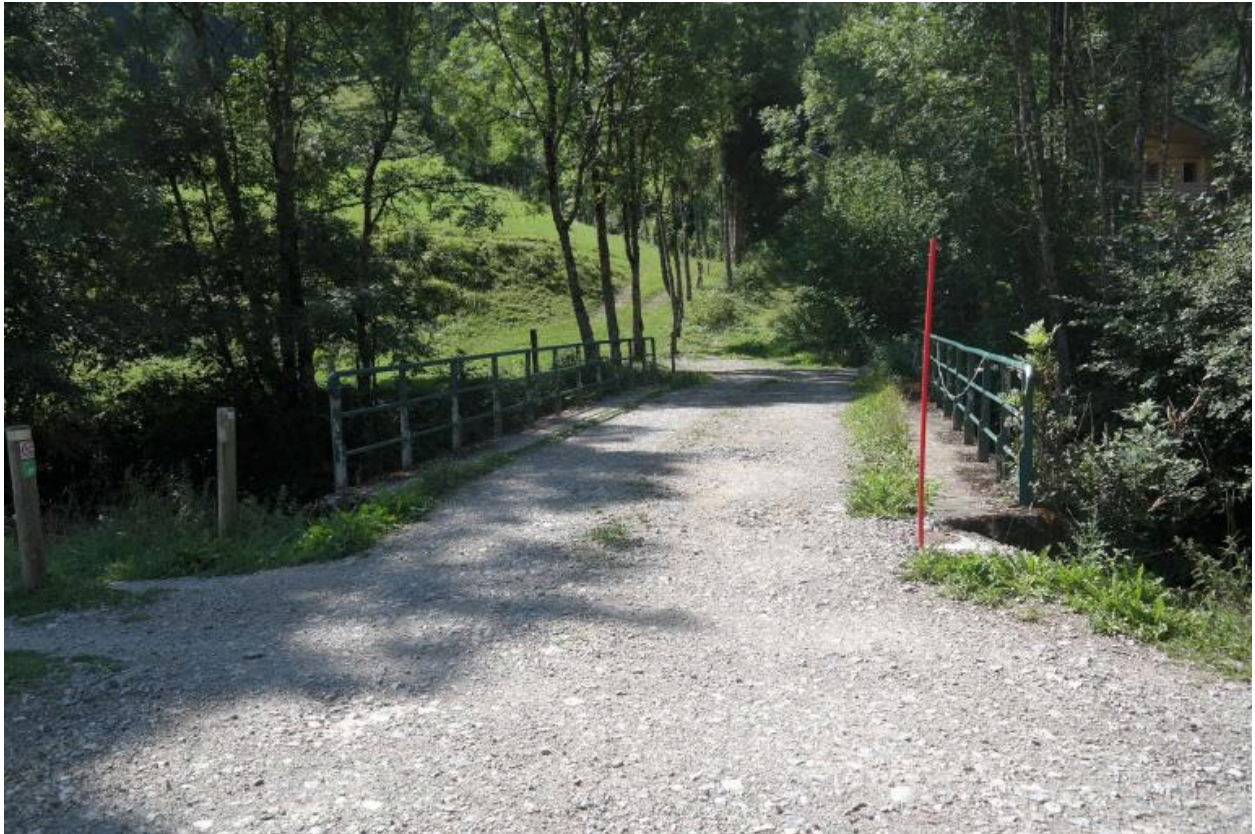
Pont de Passengué, chaussée et rambardes
