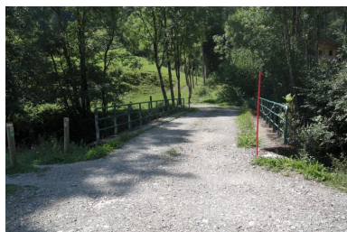
Pont de Passengué, chaussée et rambardes Phot. Pascale Renard IVR84_20207400937NUCA
