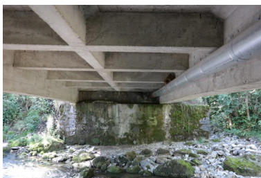
Pont de Passengué, vue de dessous Phot. Pascale Renard IVR84_20207400938NUCA
