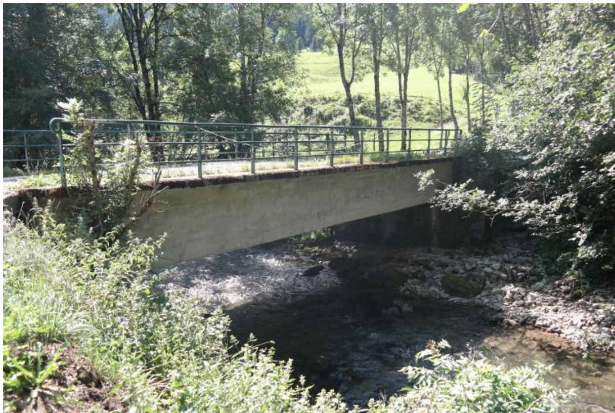
Vue générale du pont de Passengué, face aval
