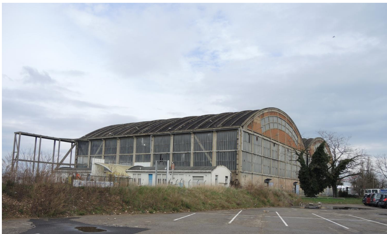
Hangar VI photo vue d'extérieur
