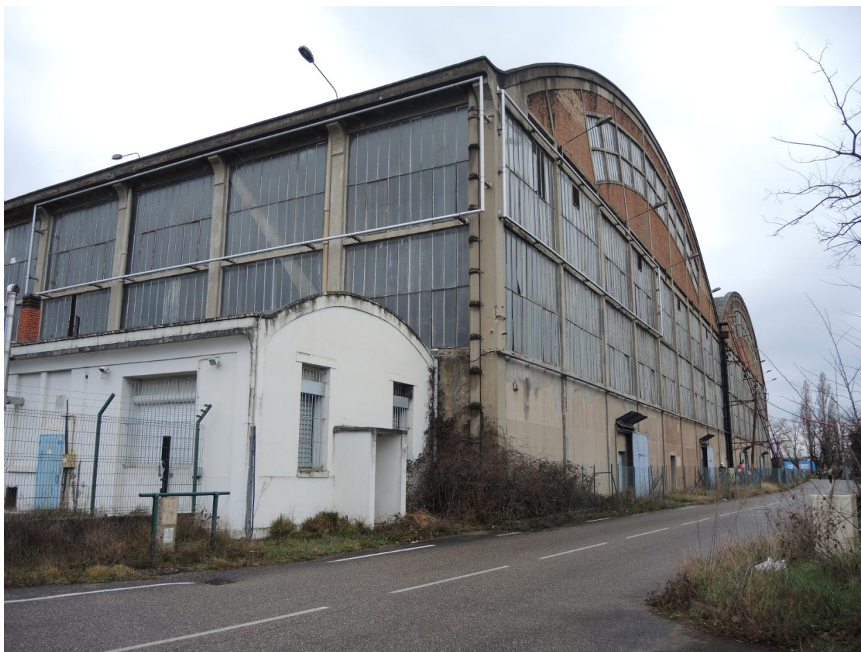
Hangar VI photo vue d'extérieur
