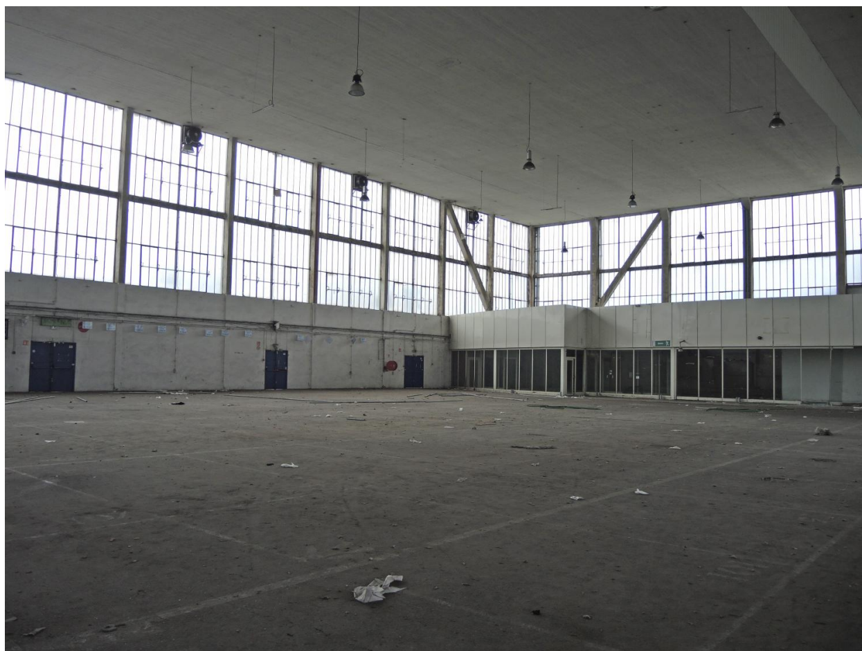
Hangar VI photo vue d'intérieur
