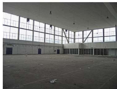
Hangar VI photo vue d'intérieur Phot. Nadine Halitim-Dubois IVR84_20256900127NUCA
