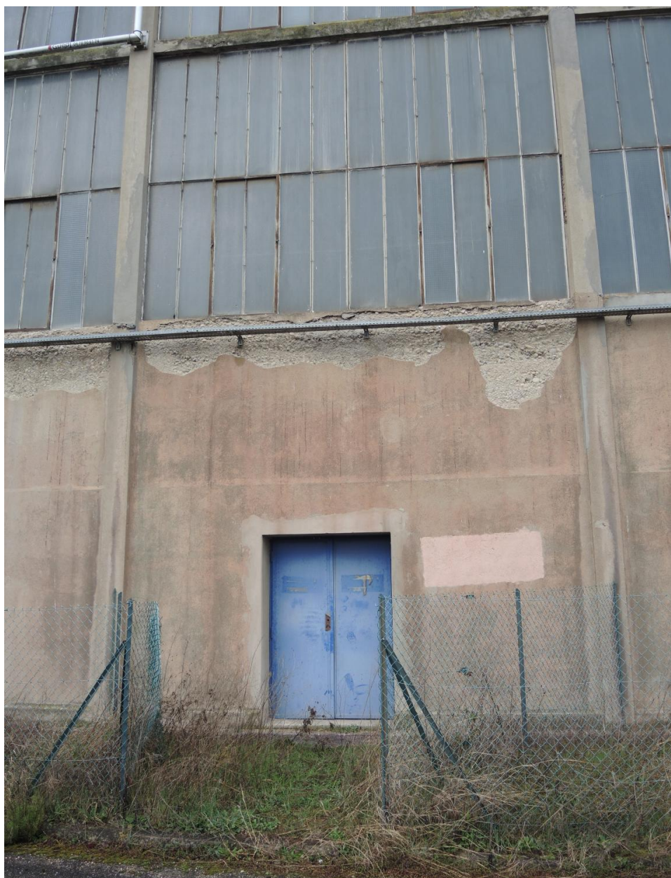
Hangar VI photo vue d'une façade d'extérieure
