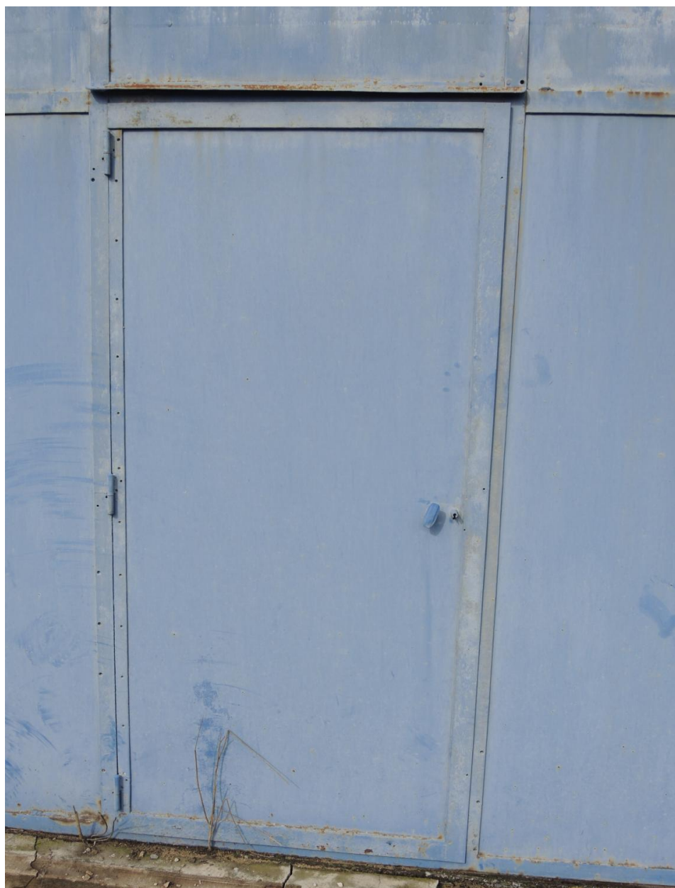
Hangar VI, porte extérieure avec poignée d'origine.
