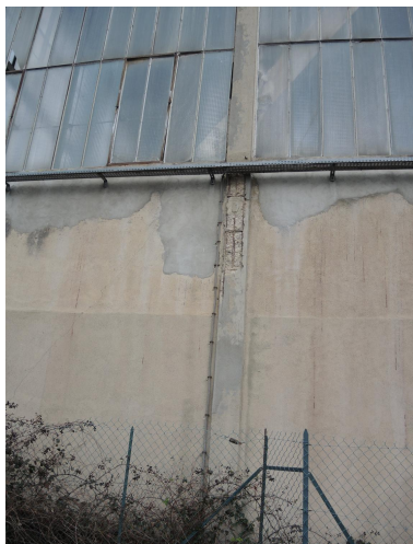
Hangar VI photo vue d'une façade extérieure Phot. Nadine Halitim-Dubois IVR84_20256900132NUCA
