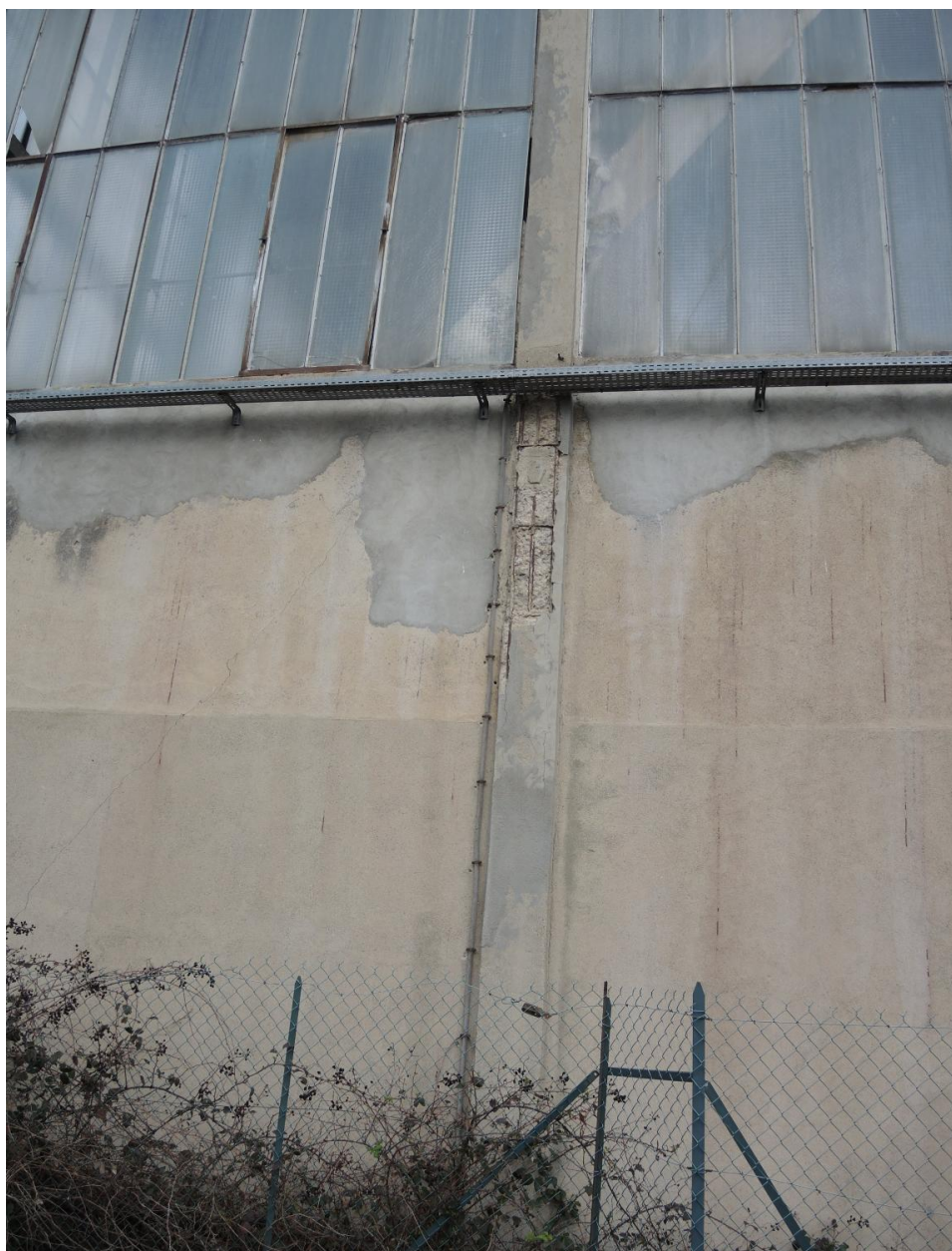
Hangar VI photo vue d'une façade extérieure
