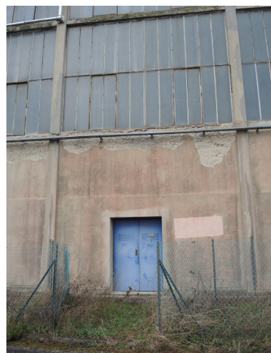
Hangar VI photo vue d'une façade d'extérieure Phot. Nadine Halitim-Dubois IVR84_20256900136NUCA
