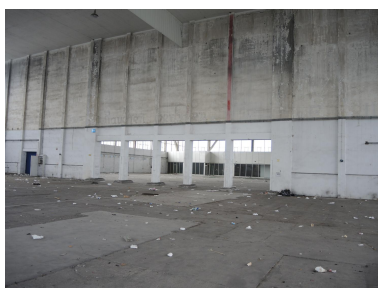
Hangar VI photo vue d'intérieur Phot. Nadine Halitim-Dubois IVR84_20256900123NUCA
