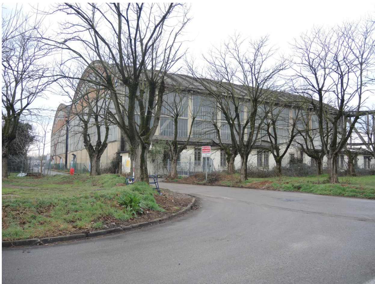
Hangar VI photo vue d'extérieur
