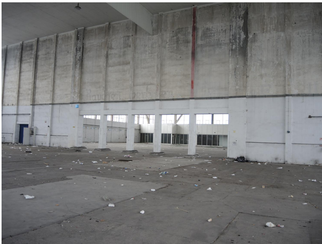
Hangar VI photo vue d'intérieur
