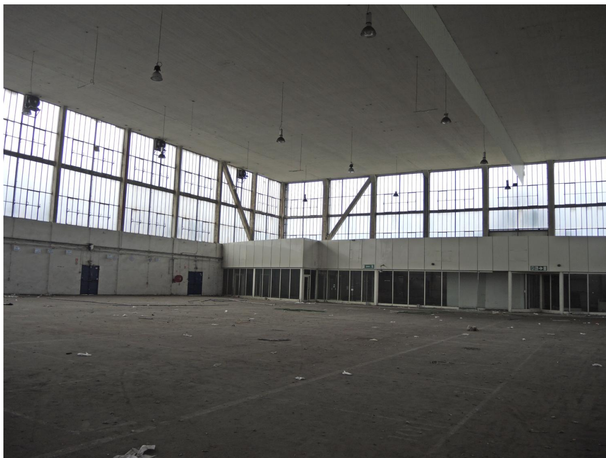
Hangar VI photo vue d'intérieur
