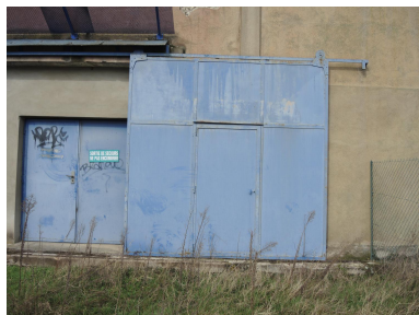
Hangar VI photo vue d'une façade d'extérieure (portes) Phot. Nadine Halitim-Dubois IVR84_20256900137NUCA
