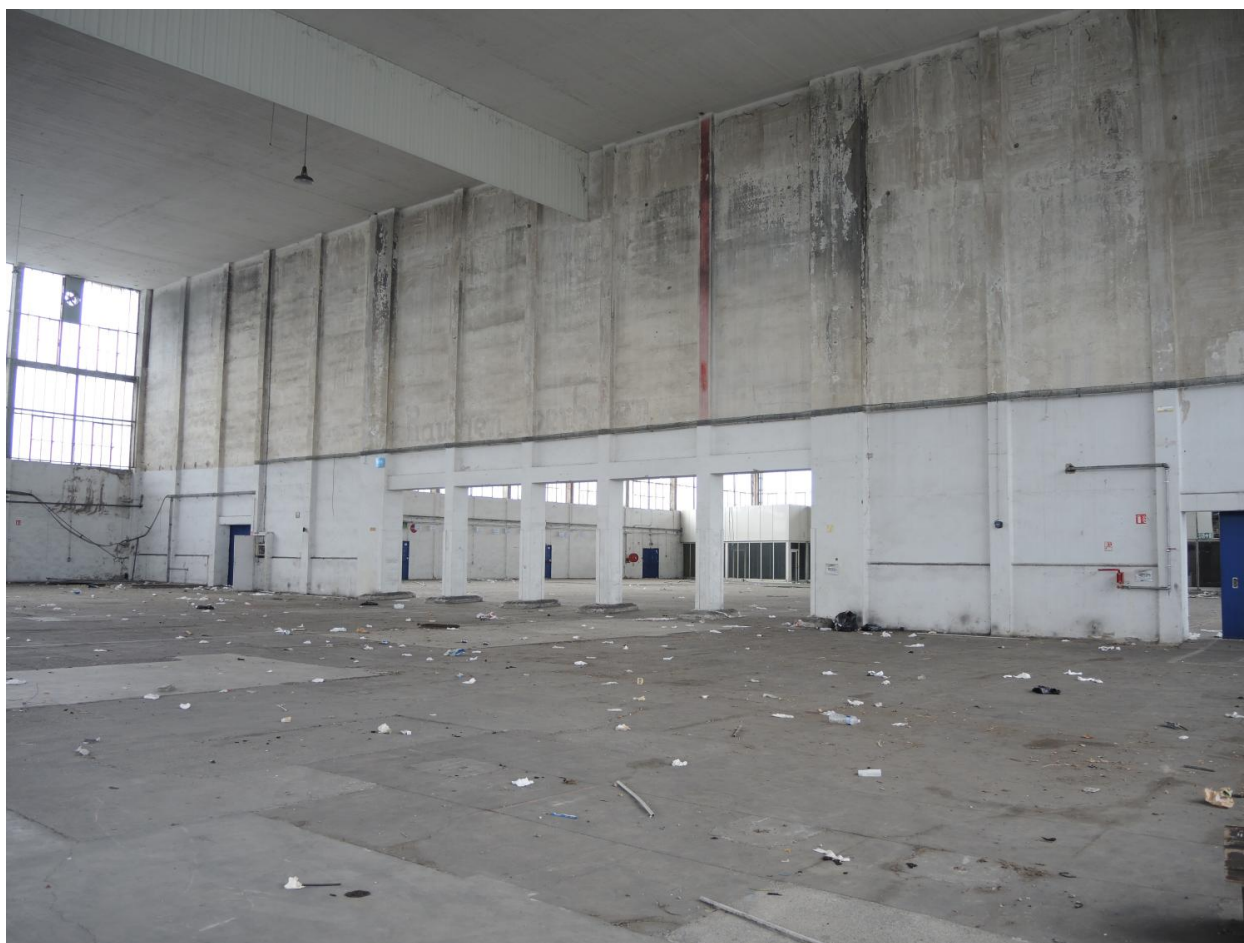
Hangar VI photo vue d'intérieur
