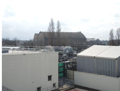
Hangar VI photo vue d'extérieur (photo prise du toit de Castorama) Phot. Nadine Halitim-Dubois IVR84_20256900149NUCA
