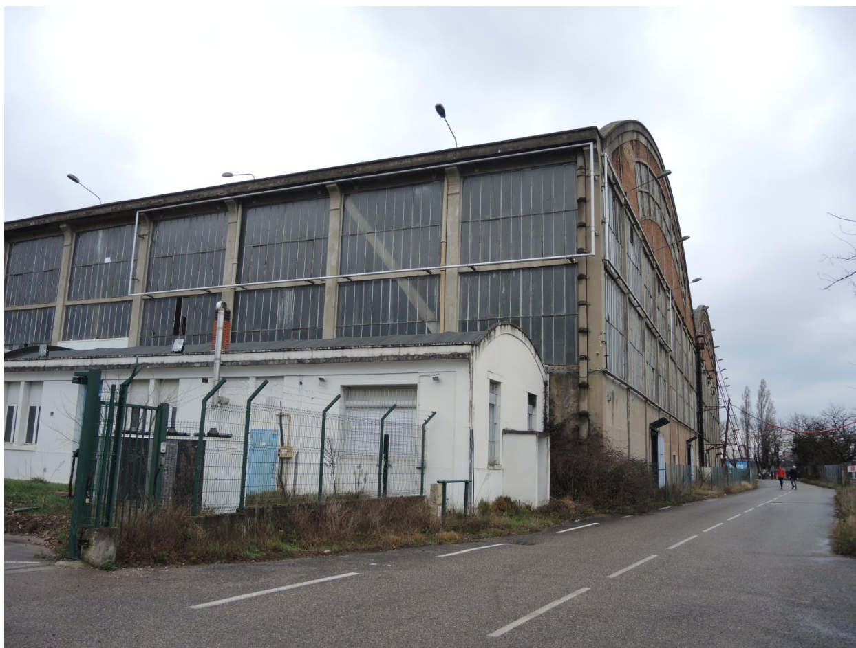
Hangar VI photo vue d'extérieur
