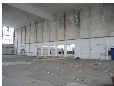
Hangar VI photo vue d'intérieur Phot. Nadine Halitim-Dubois IVR84_20256900122NUCA
