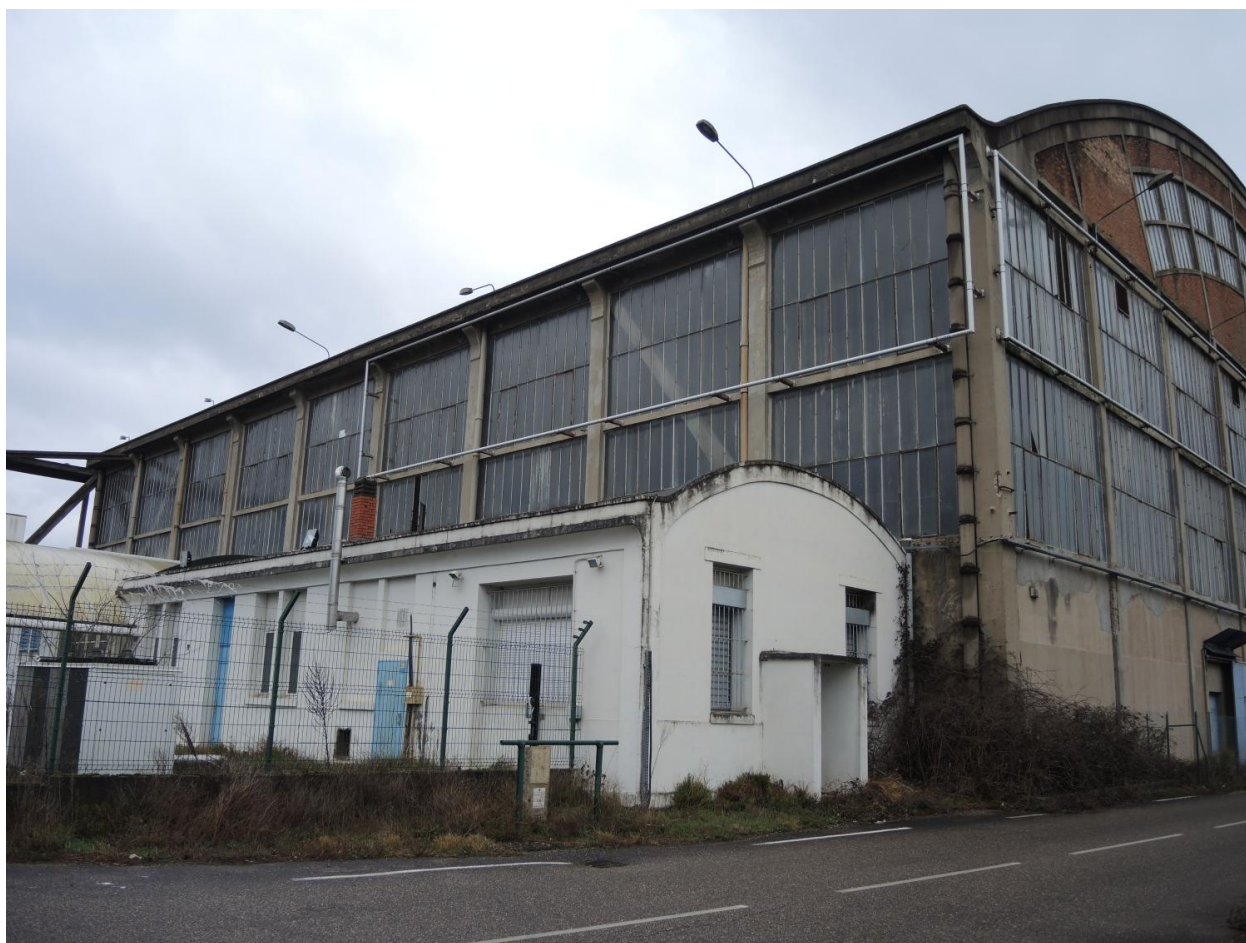
Hangar VI photo vue d'extérieur
