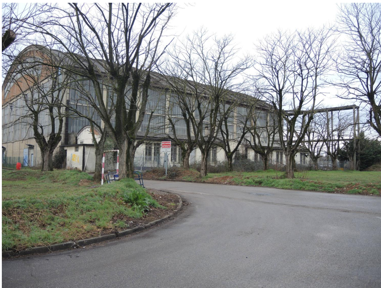
Hangar VI photo vue d'extérieur
