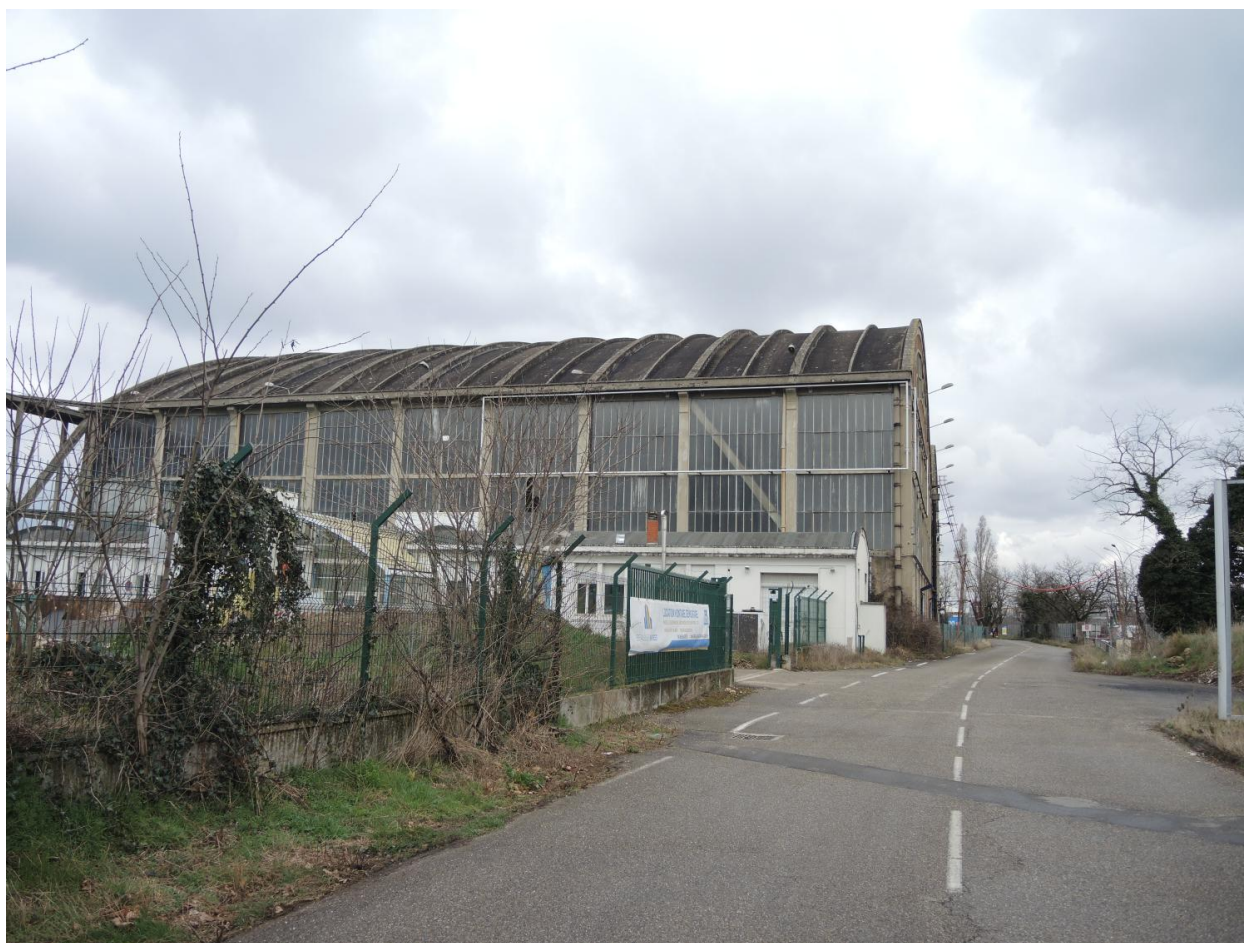
Hangar VI photo vue d'extérieur
