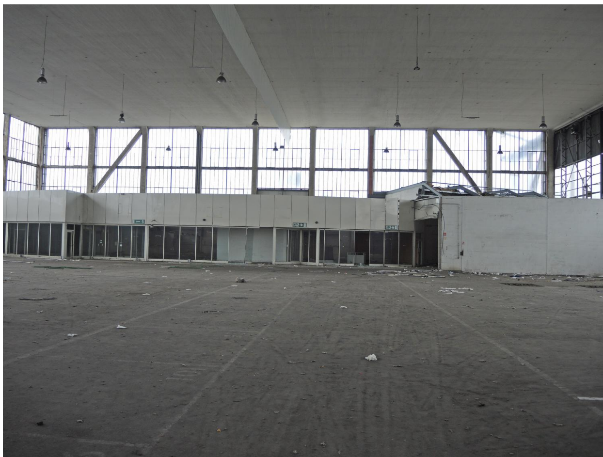
Hangar VI photo vue d'intérieur
