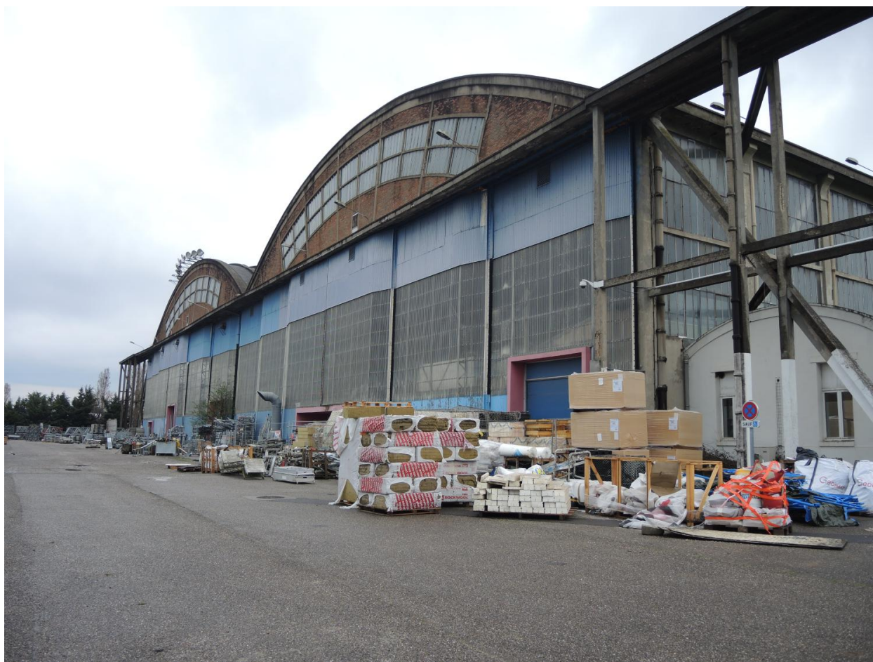
Hangar VI photo vue d'extérieur
