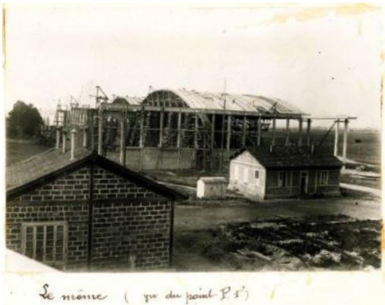
Hangar VI photo chantier ETs. Boussiron 1925 (ADR : 4535W47)
