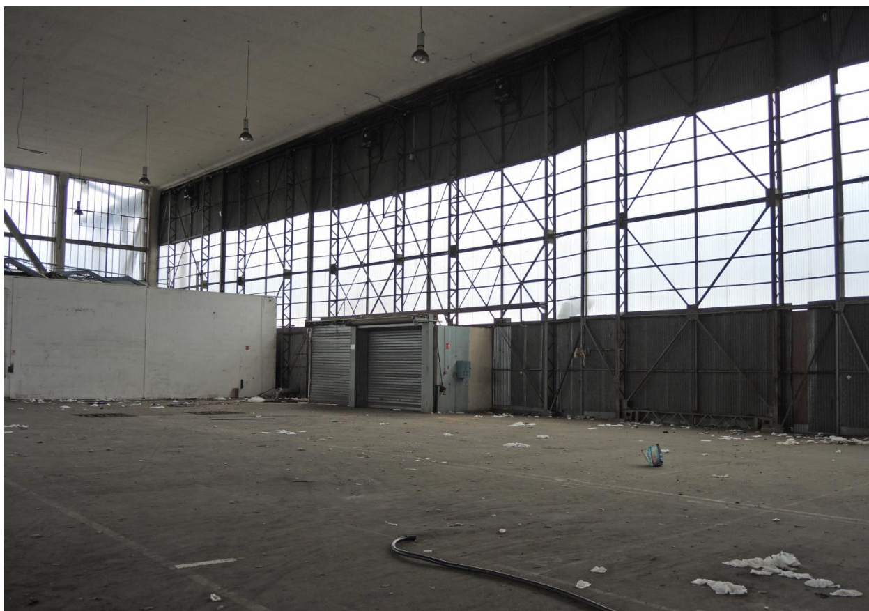
Hangar VI photo vue d'intérieur
