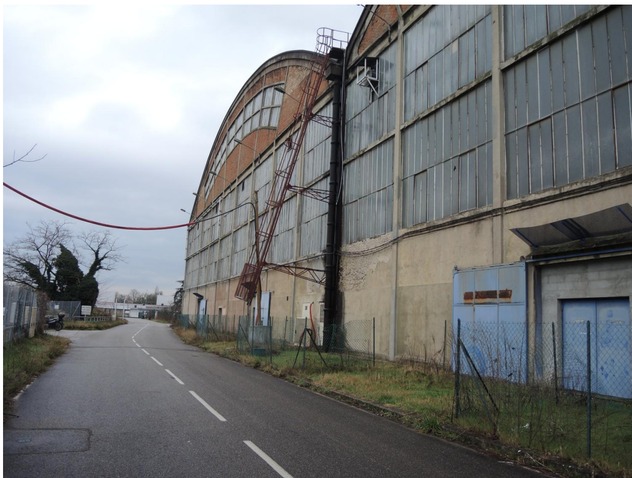
Hangar VI photo vue d'extérieur
