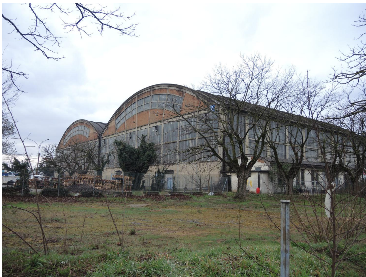
Hangar VI photo vue d'extérieur
