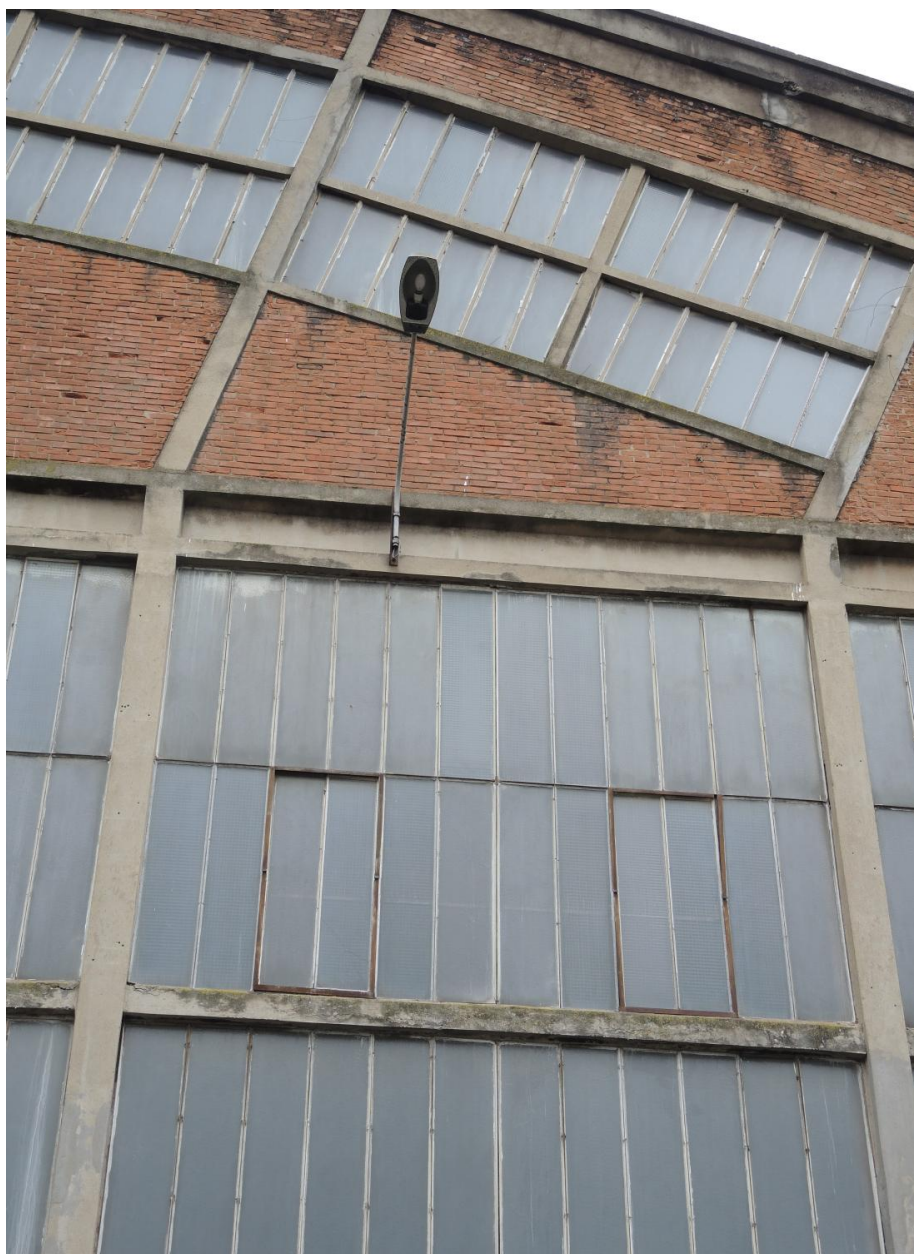
Hangar VI photo vue d'extérieur
