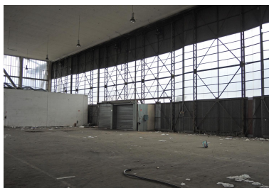
Hangar VI photo vue d'intérieur Phot. Nadine Halitim-Dubois IVR84_20256900126NUCA
