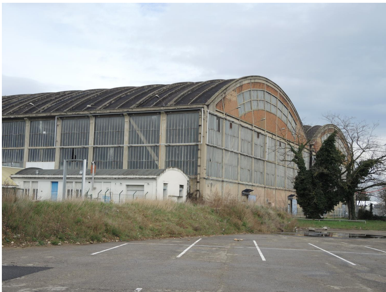
Hangar VI photo vue d'extérieur
