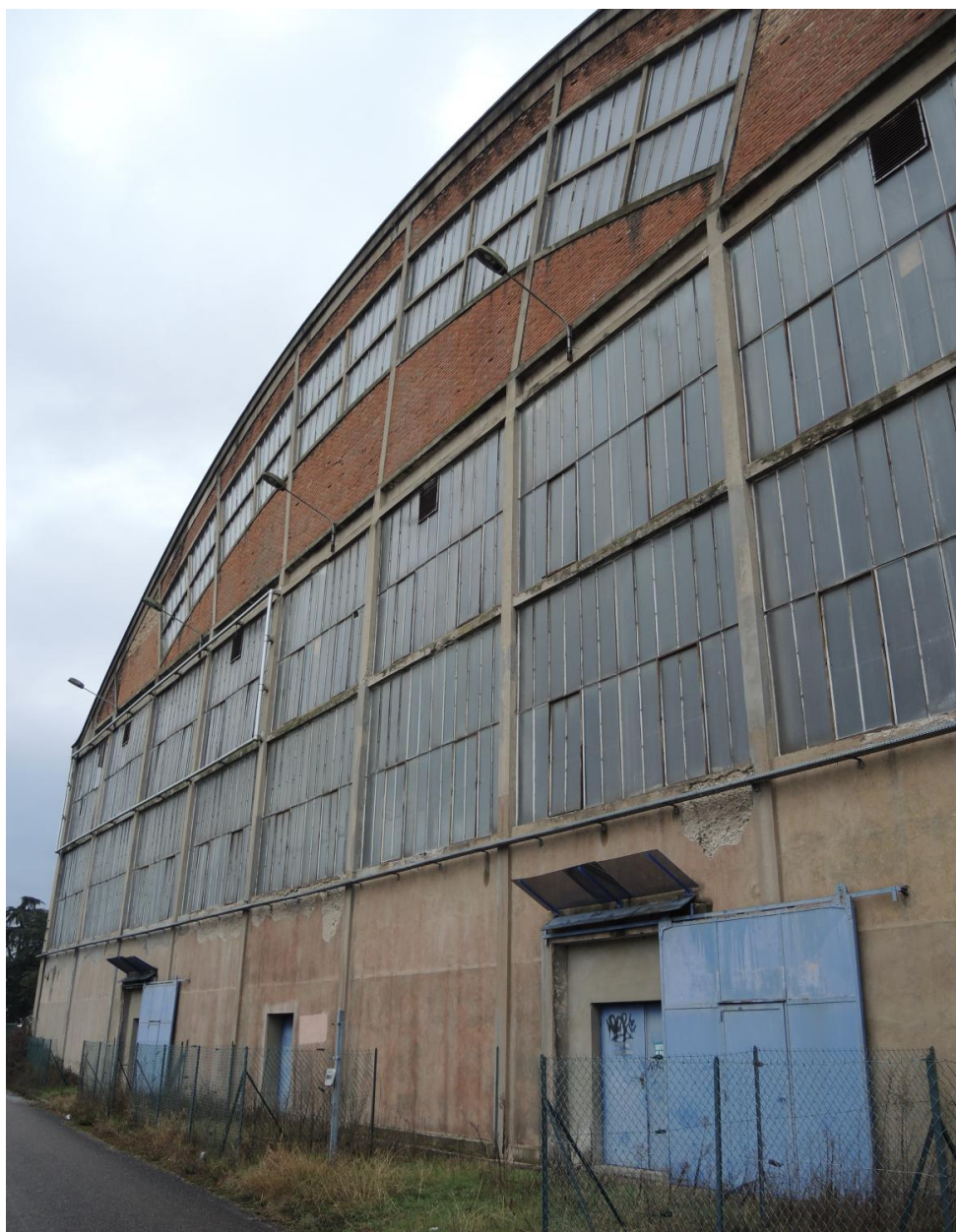
Hangar VI photo vue d'extérieur
