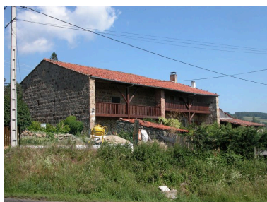
Vue générale Phot. Thierry Monnet IVR82_20124200573NUCA
