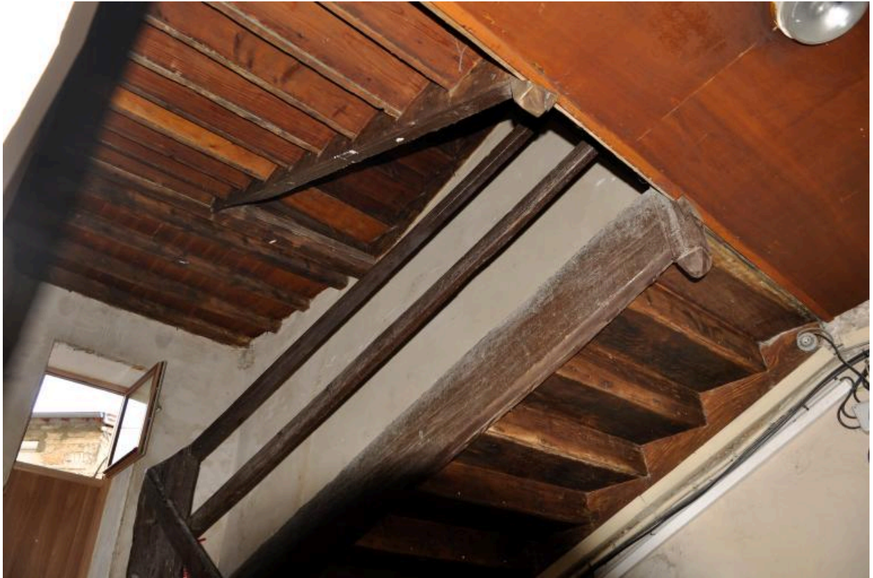
4 rue de Marché : escalier en bois
