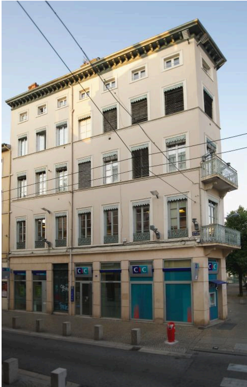
Immeuble reconstruit, 2 grande rue de Vaise
