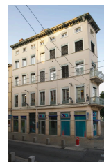
Immeuble reconstruit, 2 grande rue de Vaise
