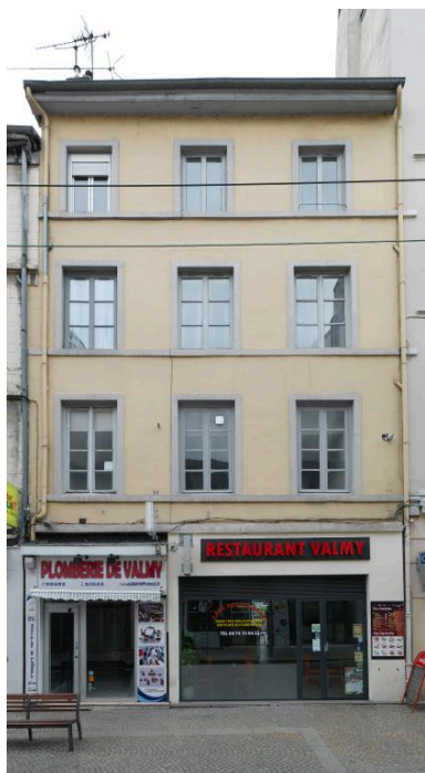
Ancienne maison Cointeraux remplacée par un immeuble à logements au 19e siècle (4 grande rue de Vaise)
