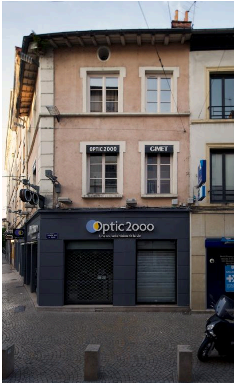
Elévation nord de la maison d'angle, 2 rue du Marché
