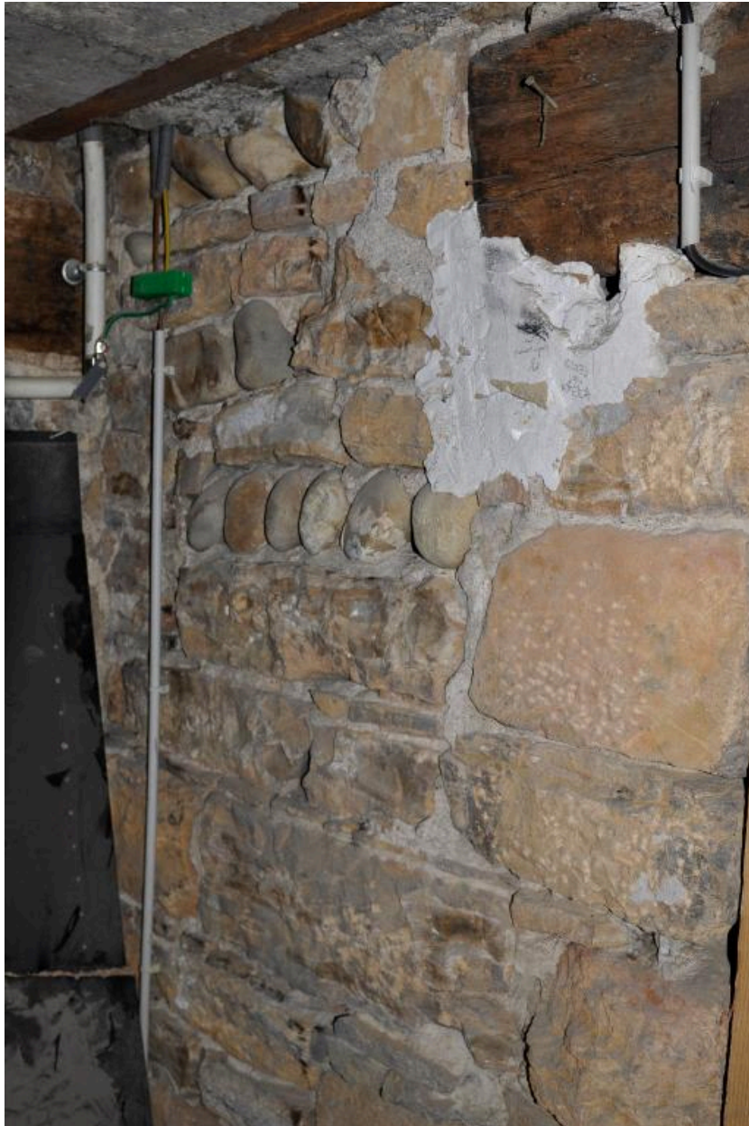
12 grande rue de Vaise : mur du sous-sol en moellon calcaire et galets fluviaux
