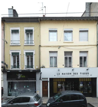
Ensemble de deux maisons jumelées, actuellement n° 8 et 10 grande rue de Vaise Phot. Franck Trabouillet IVR84_20196900386NUCA
