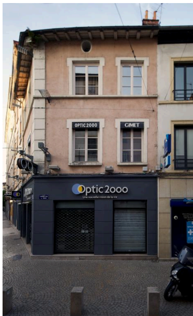
Elévation nord de la maison d'angle, 2 rue du Marché Phot. Franck Trabouillet IVR84_20196900419NUCA
