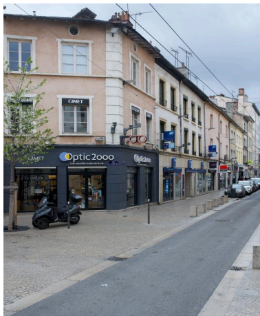
Vue d'ensemble des maisons Cointeraux en alignement sur la rue de Vaise, depuis le sud Phot. Franck Trabouillet IVR84_20196900381NUCAQ
