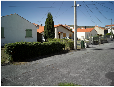
Anciennes maisons Michelin de type AA (début des années 1950), plus ou moins transformées, dans l'impasse Auguste-Comte. Phot. Christian Parisey IVR84_20196300266NUC4A
