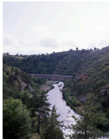
Le viaduc de Chapeauroux vu depuis les limites de la Haute-Loire, en direction de la Lozère.
