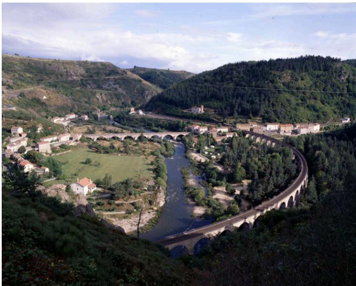
Le viaduc enjambant le cours du Chapeauroux au point de confluence avec l'Allier, vu depuis les limites du département de la Haute-Loire, en direction de la Lozère.
