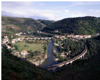
Le viaduc enjambant le cours du Chapeauroux au point de confluence avec l'Allier, vu depuis les limites du département de la Haute-Loire, en direction de la Lozère.
