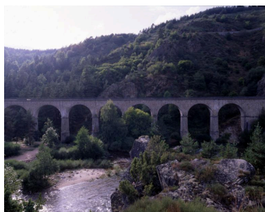
Détail du viaduc courbe de Chapeauroux.
