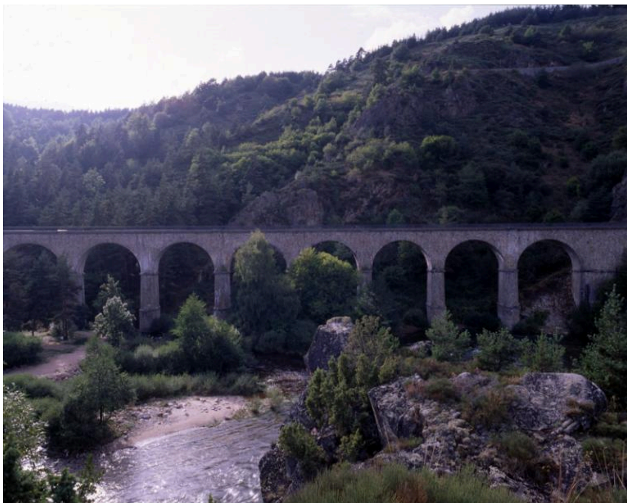
Détail du viaduc courbe de Chapeauroux.
