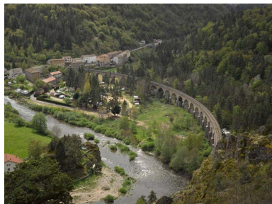
Le viaduc courbe de Chapeauroux vu depuis la Haute-Loire, en direction de la gare et du village de Chapeauroux, en Lozère.
