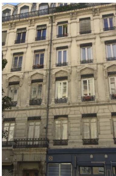
Façade principale sur la rue Mercière, détail Phot. Bernard Ducouret IVR82_20046900989NUCA
