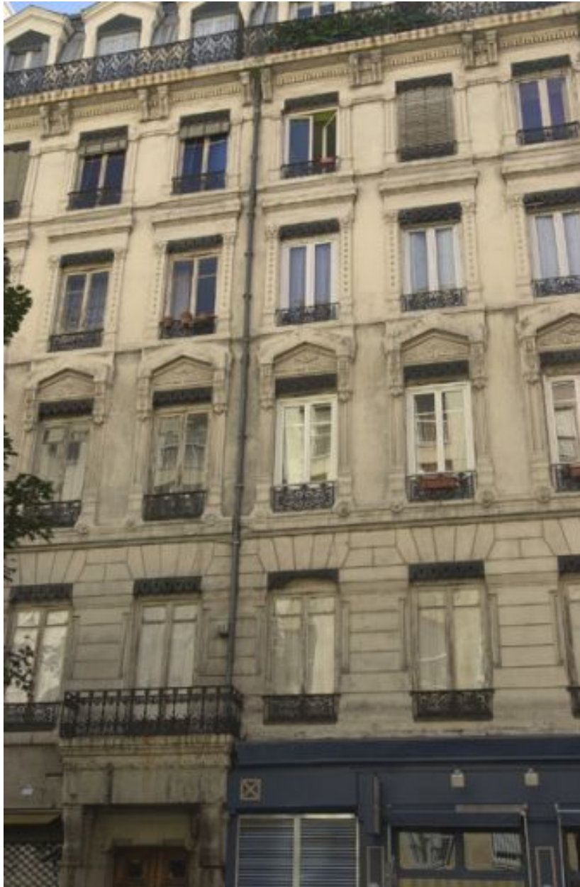
Façade principale sur la rue Mercière, détail
