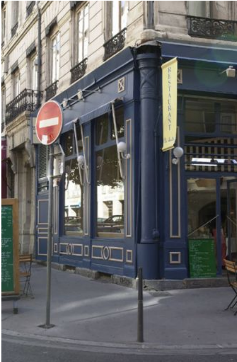
Détail d'un élément de devanture d'origine à l'angle des 2 rues
