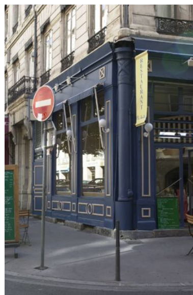
Détail d'un élément de devanture d'origine à l'angle des 2 rues Phot. Bernard Ducouret IVR82_20046900991NUCA
