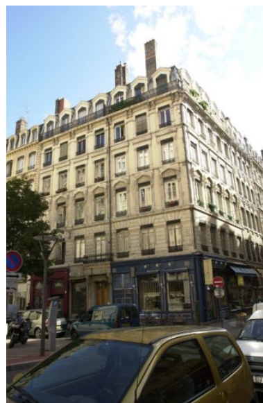
Vue générale des façades sur rue Phot. Bernard Ducouret IVR82_20046900988NUCA
