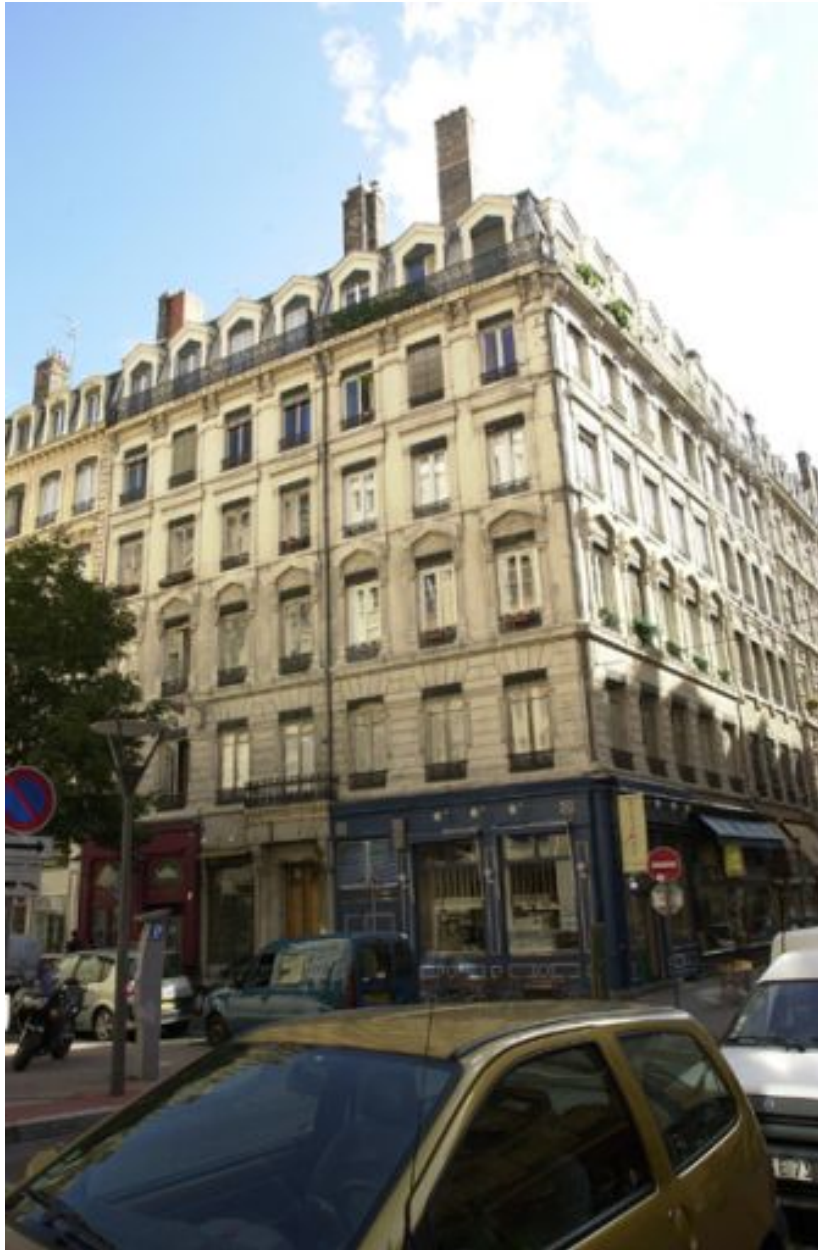
Vue générale des façades sur rue
