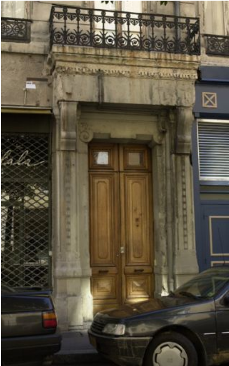
Façade principale, porte et balcon
