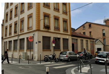
Vue rapprochée du rez- de-chaussée de l'immeuble, avec atelier en continuité Phot. Catherine Guégan IVR84_20166900713NUCA
