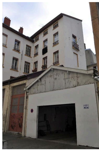
Vue partielle : atelier sud et retour de l'immeuble en L Phot. Catherine Guégan IVR84_20166900711NUCA
