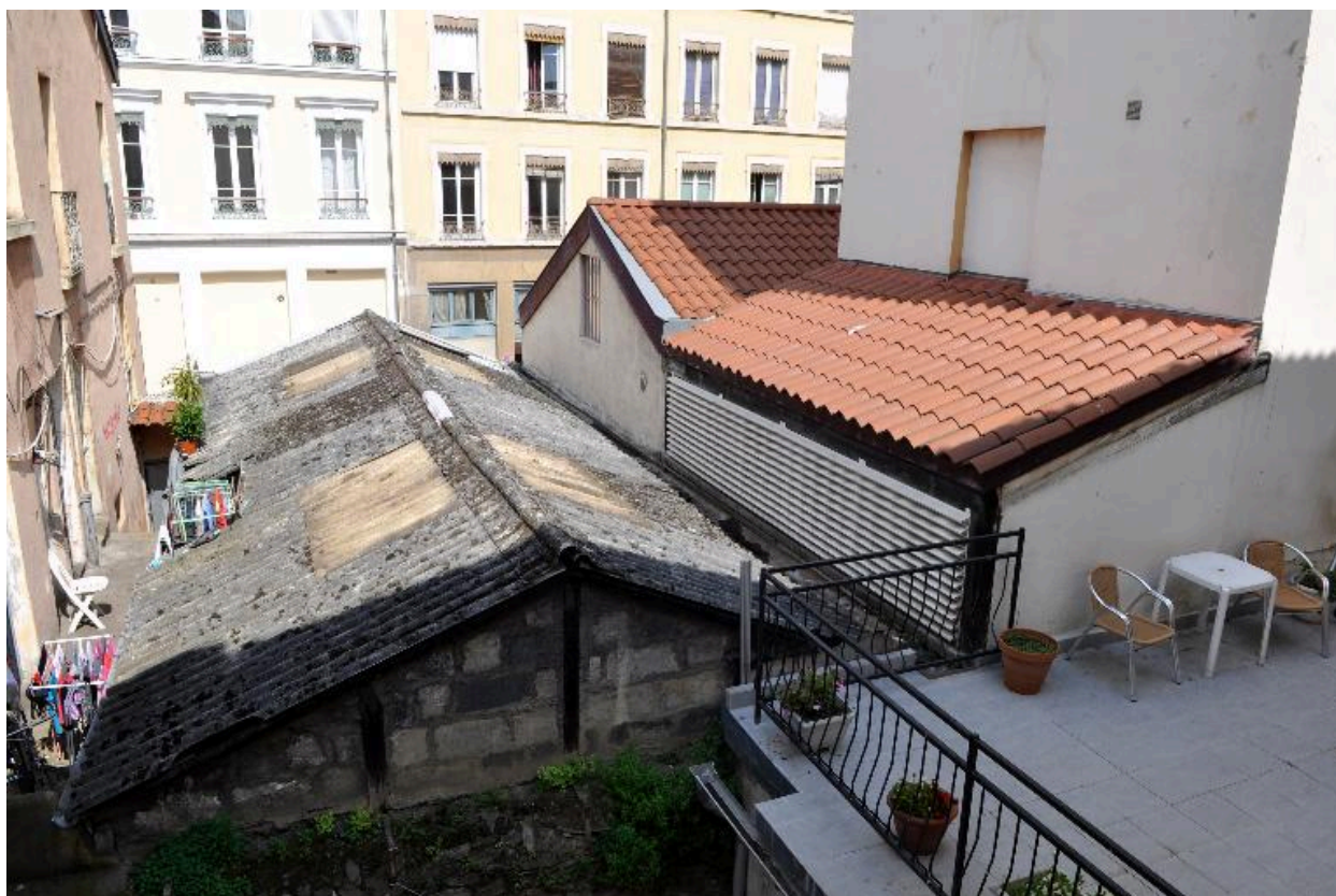
Vue des toitures des ateliers, au sud de la parcelle
