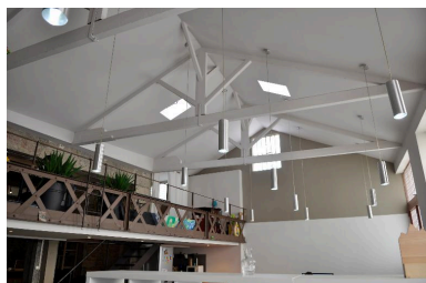
Vue intérieure de l'atelier implanté dans le creux du L Phot. Catherine Guégan IVR84_20166900715NUCA
