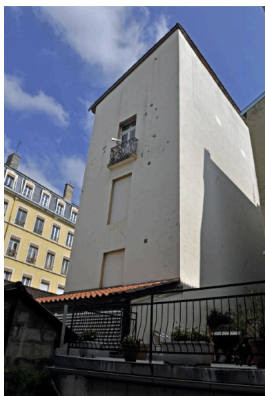
Elévations latérale et postérieure du retour du L, couvert à un pan Phot. Catherine Guégan IVR84_20166900712NUCA
