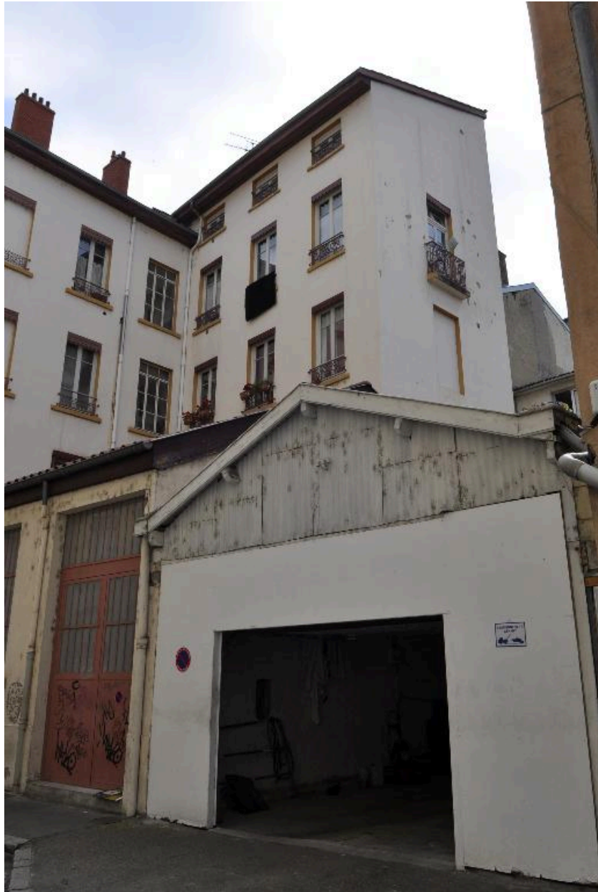
Vue partielle : atelier sud et retour de l'immeuble en L
