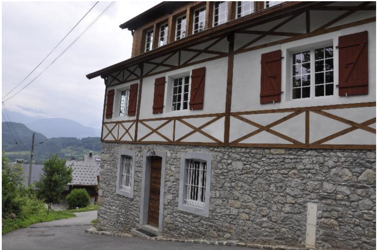
Détail de la façade antérieure est du bâtiment de la diamanterie
