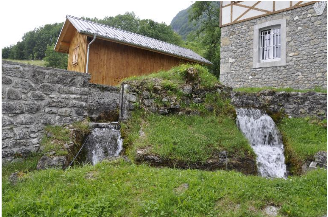
Trop plein du canal
