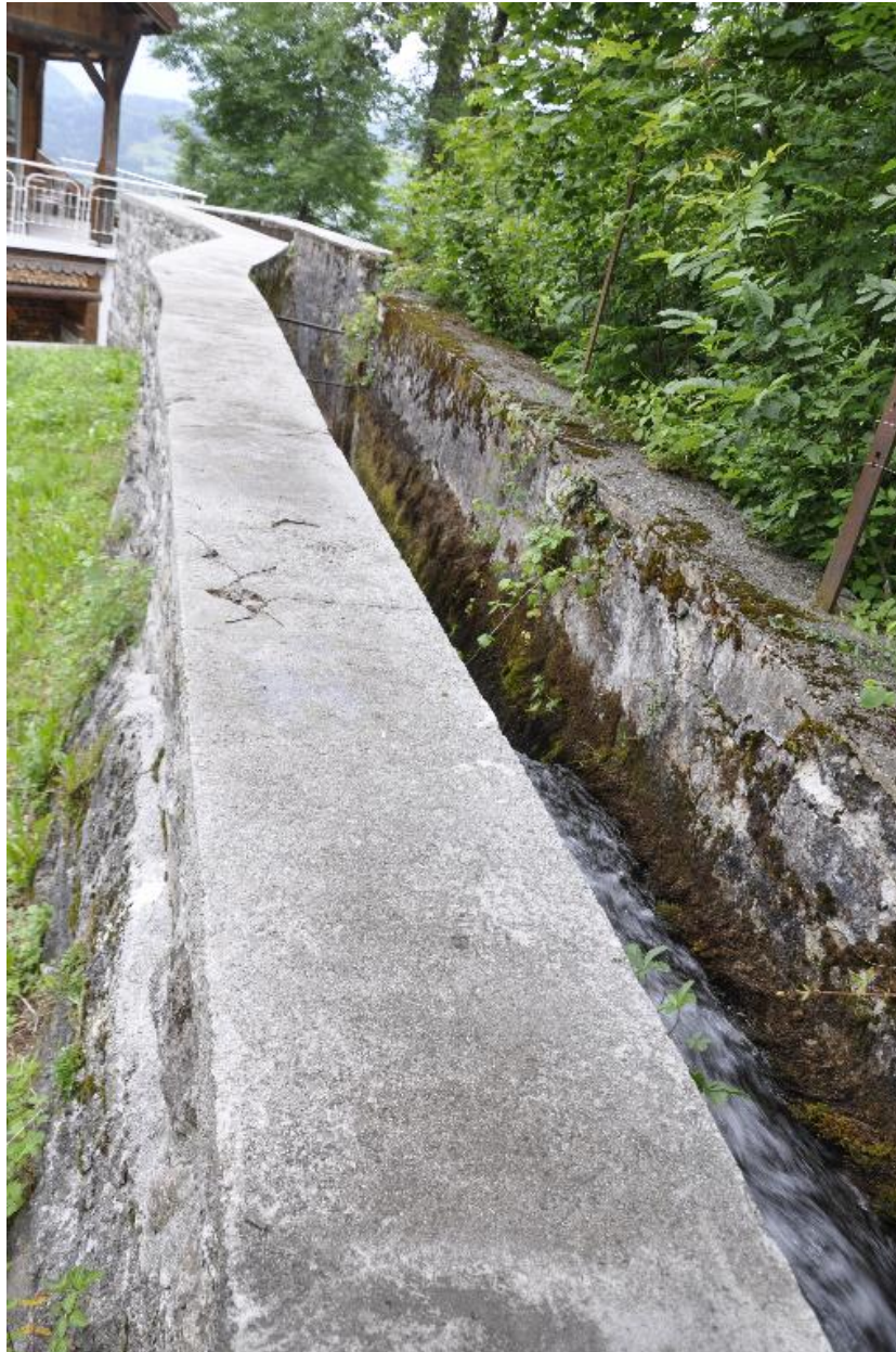
Canal de dérivation pratiqué dans le torrent de Hauteville
