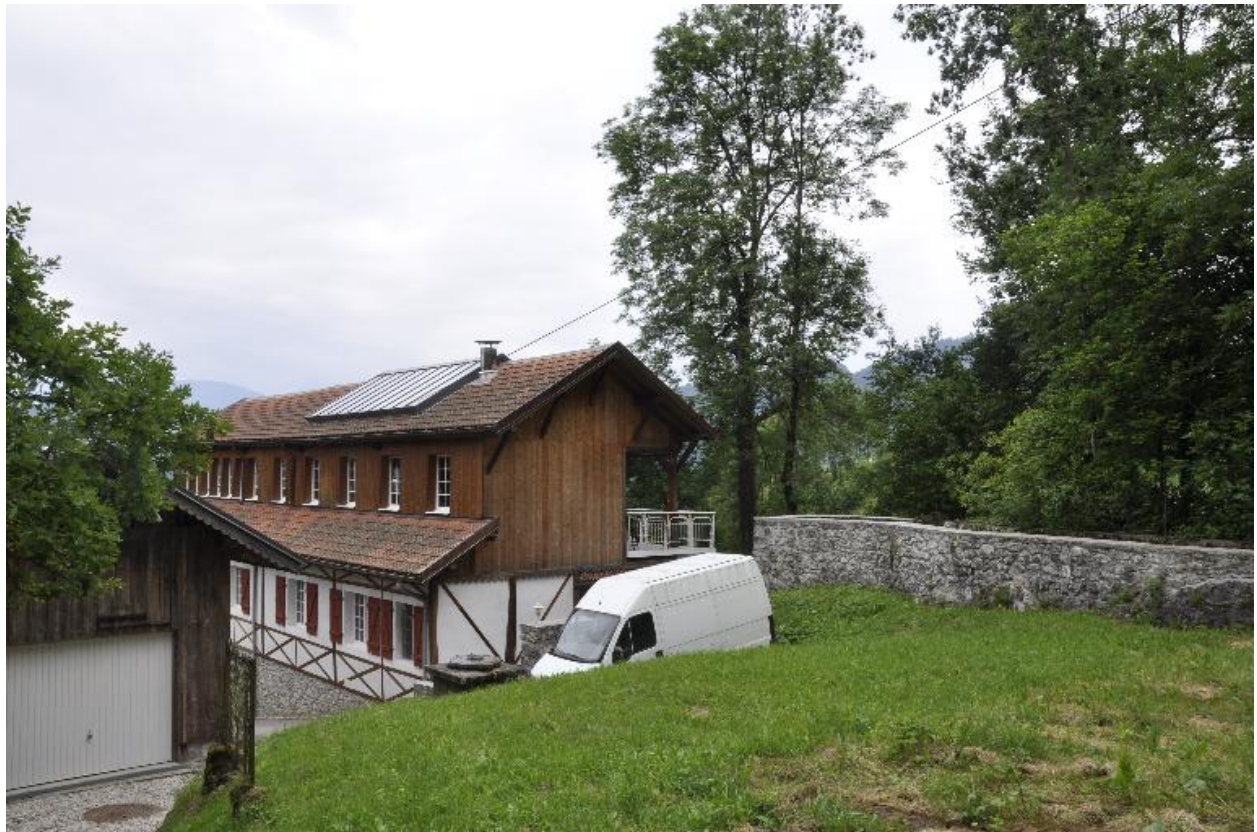
Vue de l'ancien bâtiment de la diamanterie prise depuis la plateforme nord
