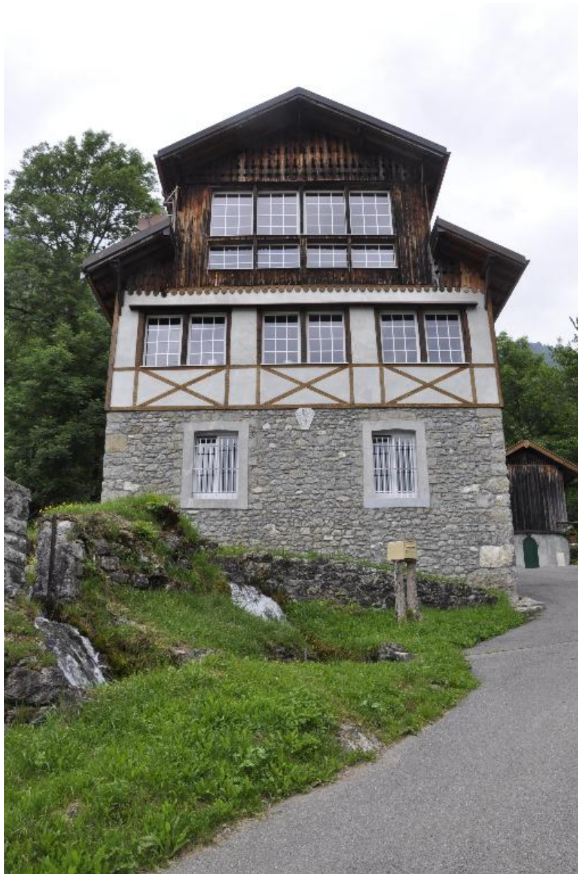
Mur pignon de la diamanterie donnant sur la voie communale d'hauteville aux Montants
