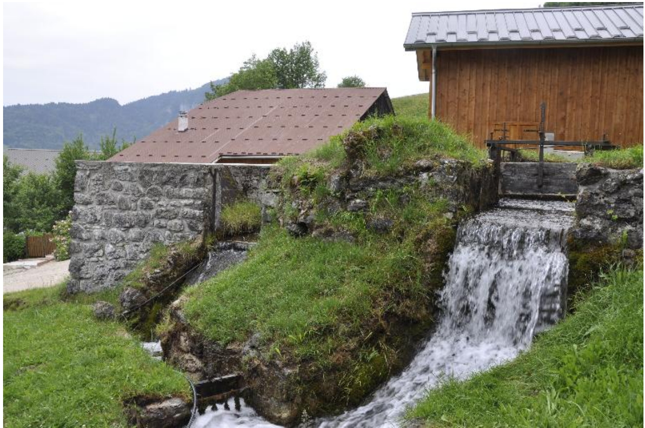
Vue du trop plein et de l'acqueduc en pierre qui acheminait l'eau vers les moulins Mogenier
