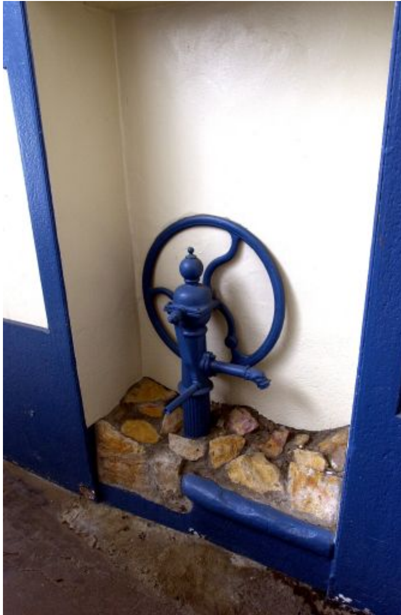
Vue de la pompe à eau en bas de l'escalier
