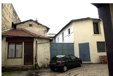
Vue des ateliers construits en fond de cour Phot. Maryannick Chalabi IVR82_20016902120NUCA
