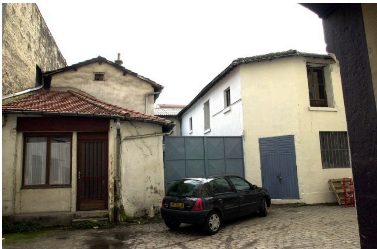
Vue des ateliers construits en fond de cour
