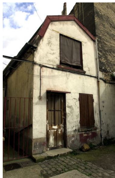
Vue de la loge de concierge Phot. Maryannick Chalabi IVR82_20016902118NUCA
