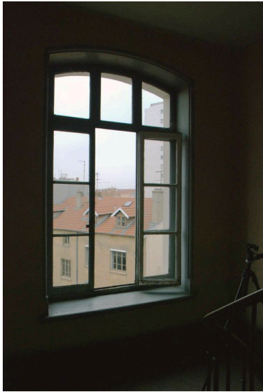
Une baie de la cage d'escalier Phot. Maryannick Chalabi IVR82_20086900743NUCA
