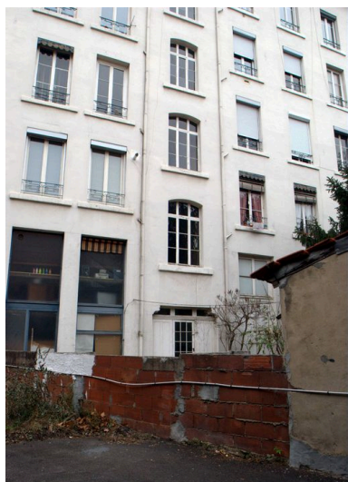
Elévation postérieure Phot. Maryannick Chalabi IVR82_20086900741NUCA
