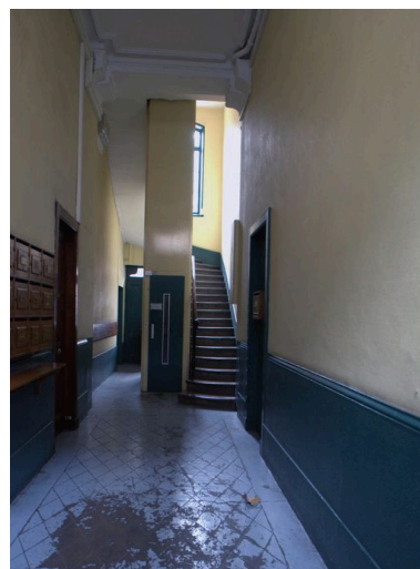
Le vestibule depuis l'entrée Phot. Maryannick Chalabi IVR82_20086900742NUCA
