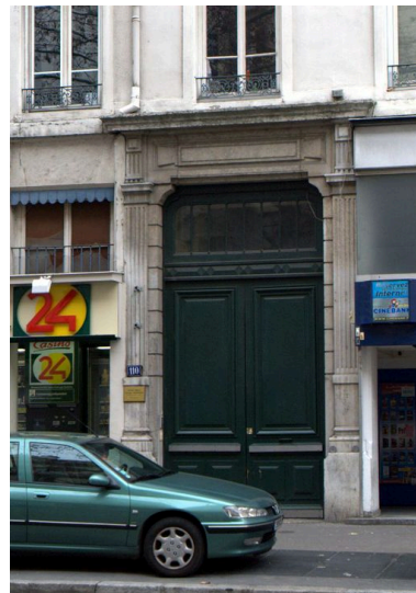
Détail du portail d'entrée Phot. Maryannick Chalabi IVR82_20086900740NUCA
