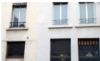
Détail des baies de l'élévation postérieure Phot. Maryannick Chalabi IVR82_20086900736NUCA
