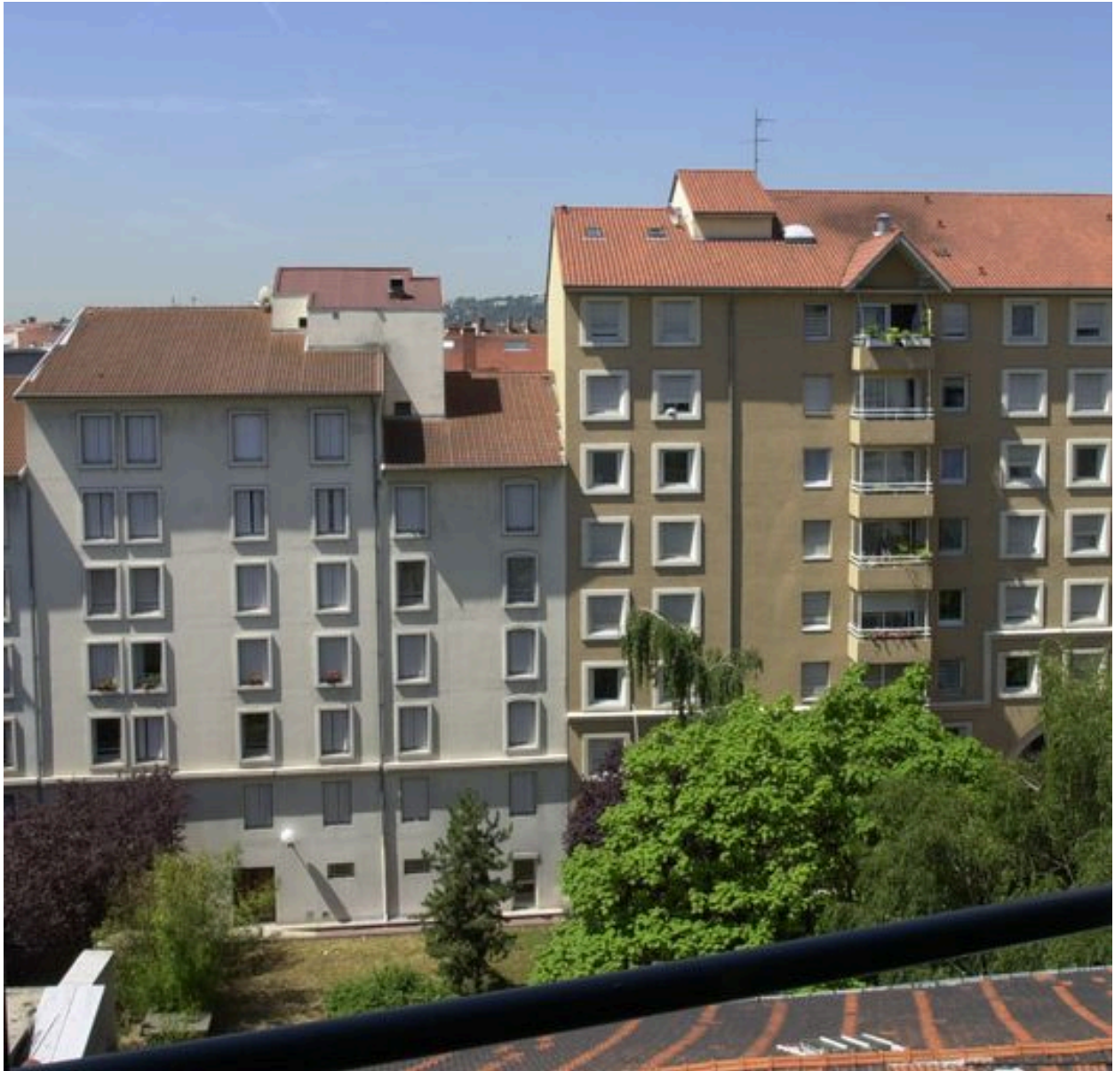
Elévation postérieure du corps de bâtiment grande rue de la Guillotière
