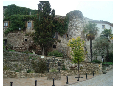
Fortification du village, montée des Artistes : tour sud-ouest (dite Tour Saint-Martin ?)
