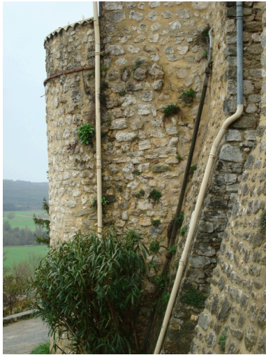
Rue de la Chèvre d'or, vestige de tour de l'enceinte du village. Phot. Geneviève Jourdan IVR82_20112600029NUCA
