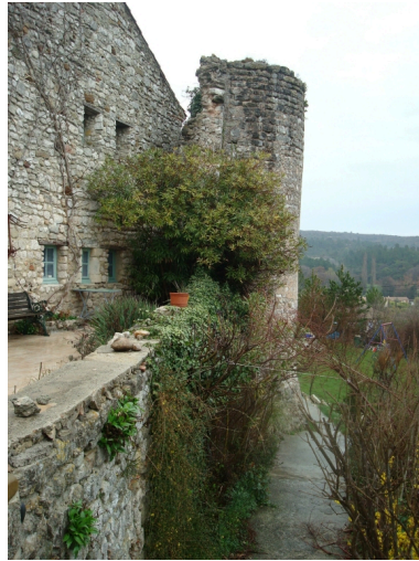
Tour à l'angle est de l'enceinte du village, chemin des Deux Tours. Phot. Geneviève Jourdan IVR82_20112600030NUCA
