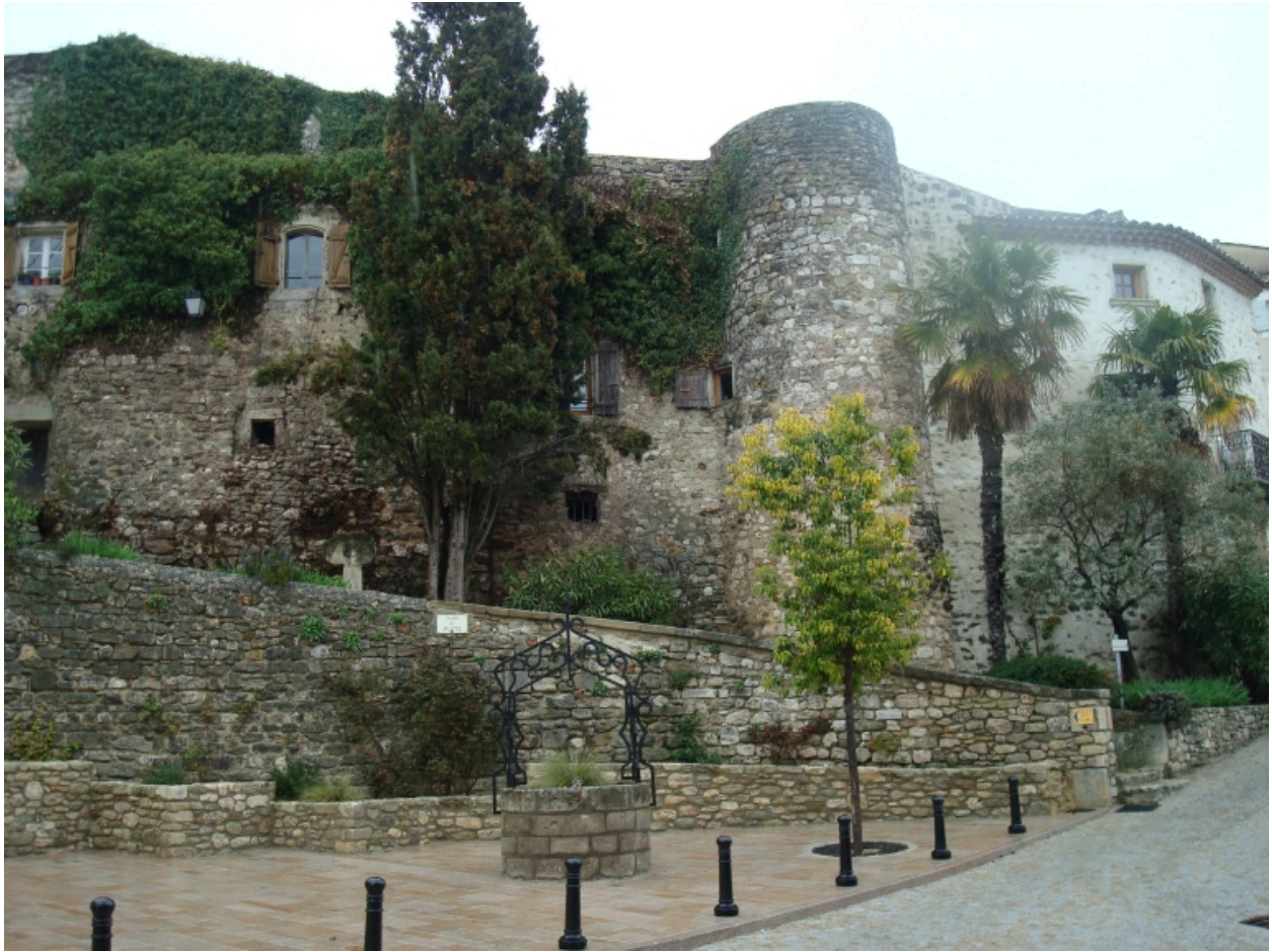
Fortification du village, montée des Artistes : tour sud-ouest (dite Tour Saint-Martin ?)
