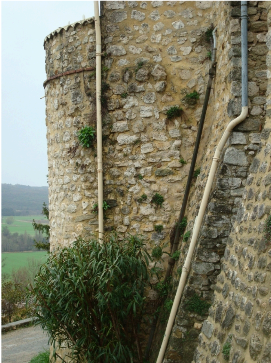
Rue de la Chèvre d'or, vestige de tour de l'enceinte du village.
