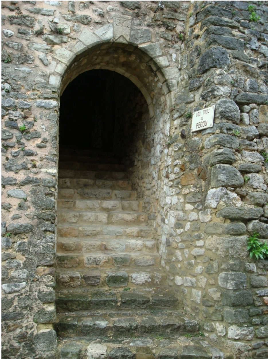
Rue de la Chèvre d'Or, porte (ou poterne) appelée lou Trou du Pégou, percée dans la courtine (encadrement refait), avec un escalier rejoignant la ruelle des Ferronniers.
