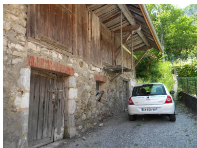
Détail des la partie agricole en façade nord Phot. Jérôme Daviet IVR82_20147400324NUCA
