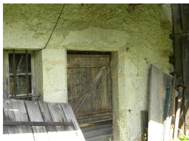
vue de la porte en accolade du logis. Phot. Jérôme Daviet IVR82_20147400327NUCA
