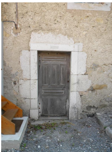
Vue d'une porte XIXe siècle en façade nord. Phot. Jérôme Daviet IVR82_20147400325NUCA
