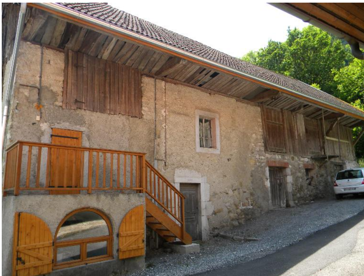
Vue d'ensemble de la façade nord
