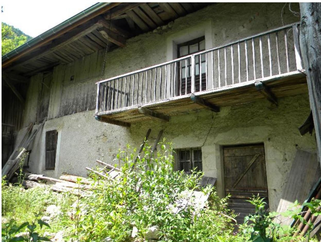
Vue de la façade sud.
