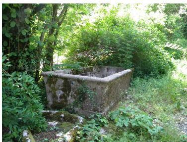
Vue du bassin abandonné. Phot. Jérôme Daviet IVR82_20147400328NUCA
