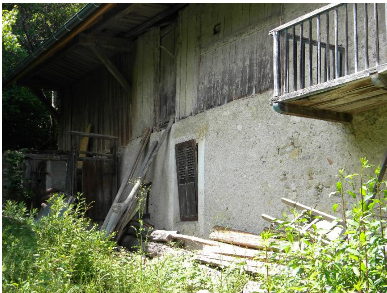
Vue des parties agricoles en façade sud.
