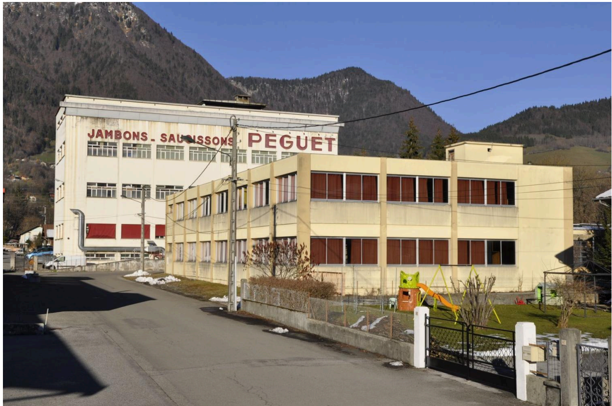
Vue d'ensemble sud de l'usine Peguet à Talingues
