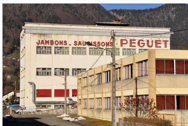
Vue de la façade principale Phot. Nadine Halitim-Dubois IVR82_20157402824NUCA
