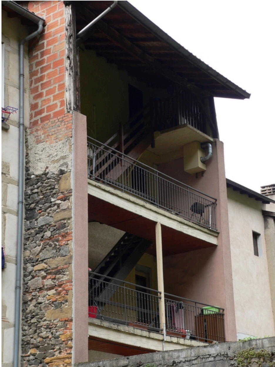
Escalier sur façade arrière
