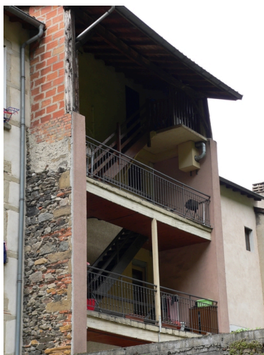
Escalier sur façade arrière Phot. Isabelle Dupuis IVR82_20093800502NUCA
