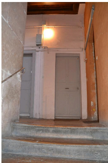
Palier Phot. Noémie Caillat IVR82_20156900176NUCA
