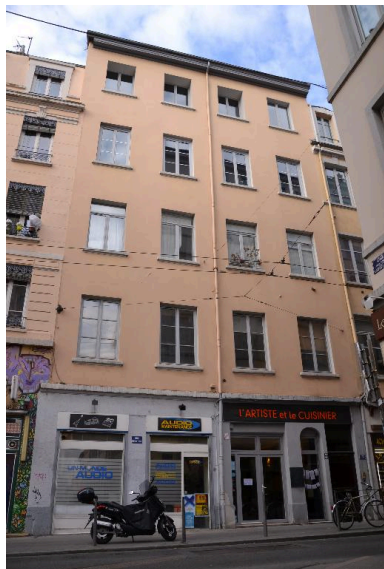
Vue d'ensemble Façade est Phot. Noémie Caillat IVR82_20156900171NUCA
