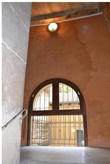
Baie escalier Phot. Noémie Caillat IVR82_20156900175NUCA
