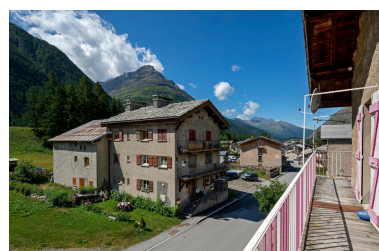
Maison d'Etat n° 6 Phot. Michel Pérès IVR84_20227301229NUCA
