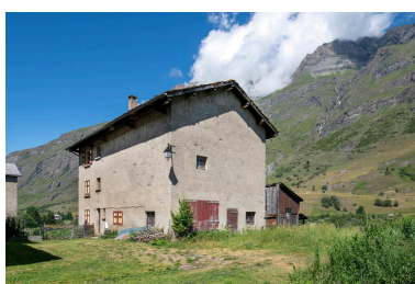
Maison d'Etat n° 10 Phot. Michel Pérès IVR84_20227301230NUCA
