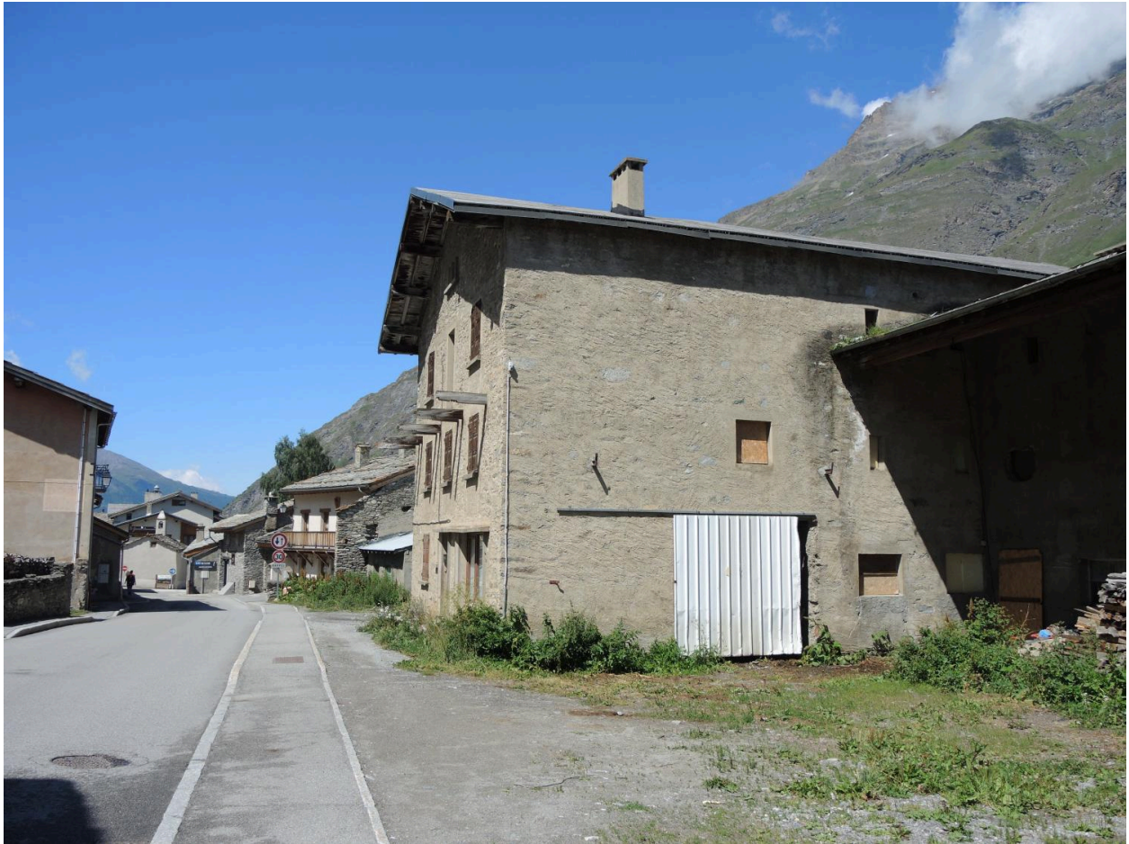
Détail façade est maison n° 14
