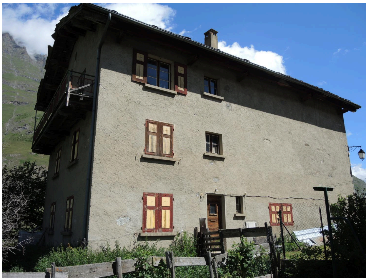
Maison n° 10 façade est : localisée derrière la maison de Gilbert Tracq
