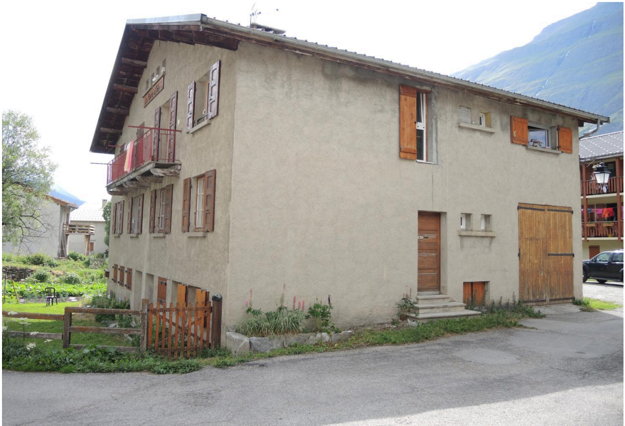
Pignon est maison n° 22 "la pierre d'Joly", 1957 date portée.
