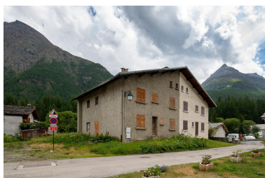
Maison d'Etat n° 2 Phot. Michel Pérès IVR84_20227301204NUCA
