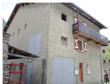
Détail façade est maison n° 17 : porte d'étable Phot. Nadine Halitim-Dubois IVR84_20227302991NUCA
