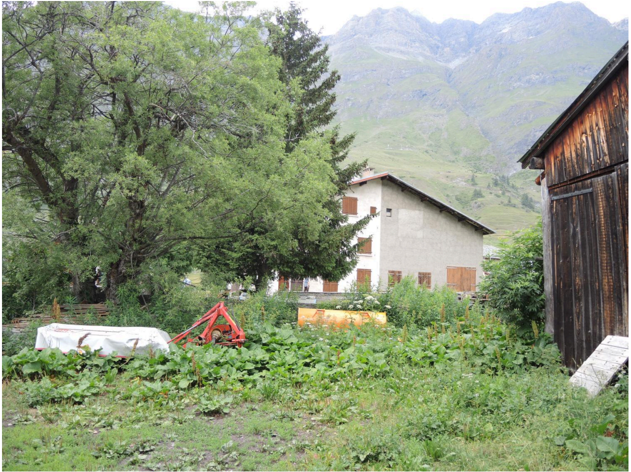
Façade arrière maisons de la reconstruction n° 2
