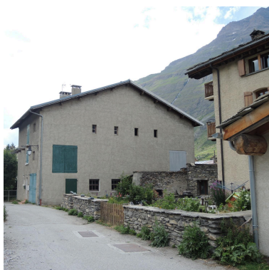
maison de la reconstruction n° 21 pignon est Phot. Nadine Halitim-Dubois IVR84_20227303064NUCA
