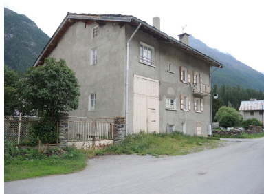
Vue ouest maison n° 3 Phot. Nadine Halitim-Dubois IVR84_20227303073NUCA
