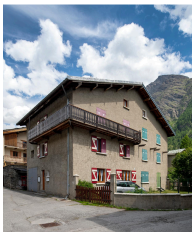
Maison d'Etat n° 7 Phot. Michel Pérès IVR84_20227301197NUCA
