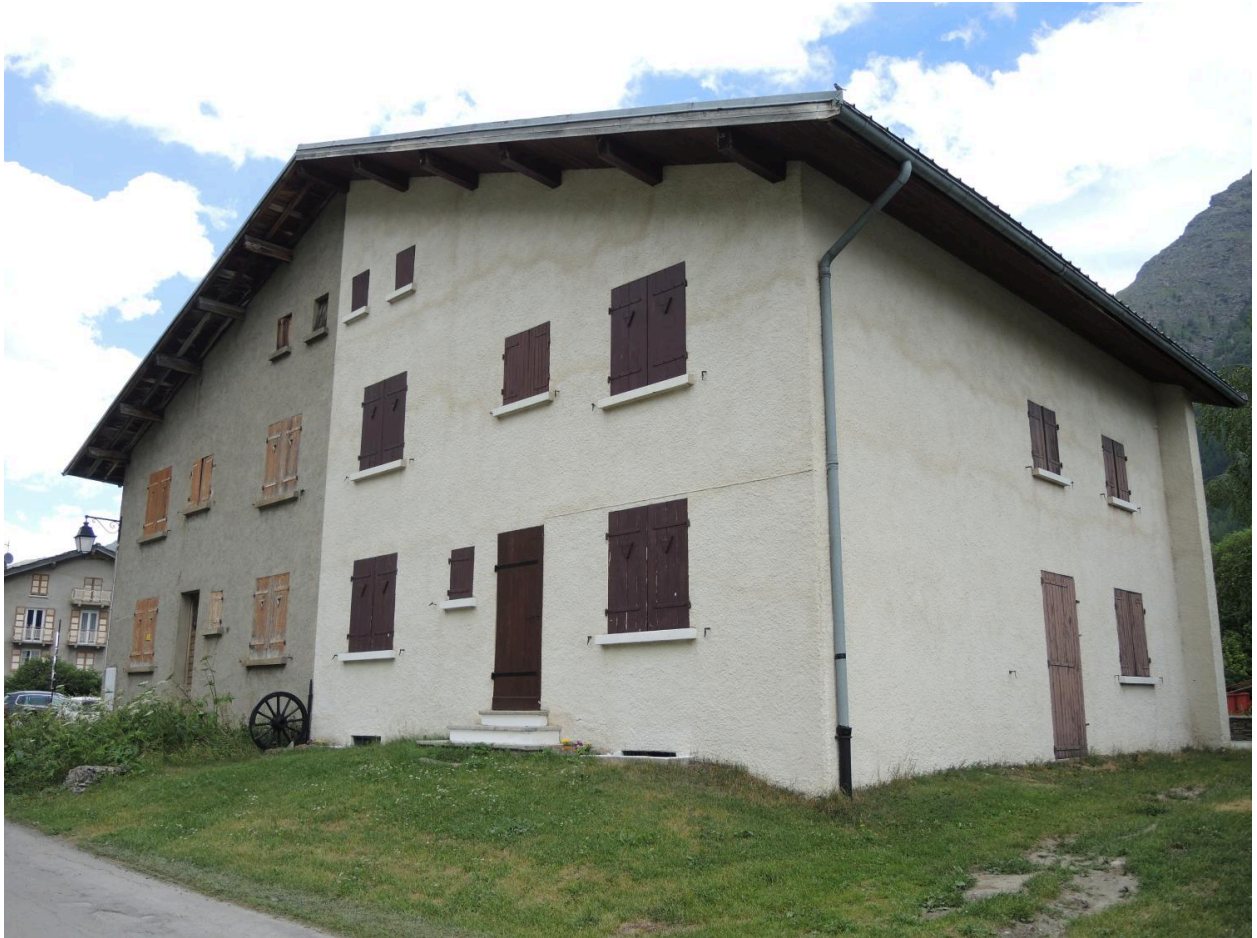
Vue d'ensemble de la maison double n° 2
