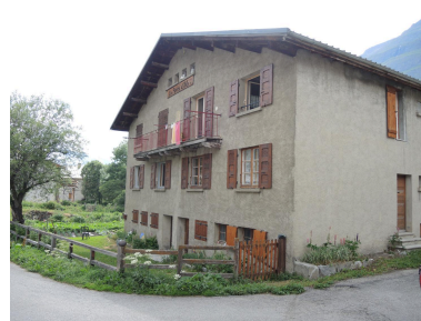
Maison de la reconstruction n° 22 "la pierre d'Joly" P.P 1957 date portée Phot. Nadine Halitim-Dubois IVR84_20227303077NUCA
