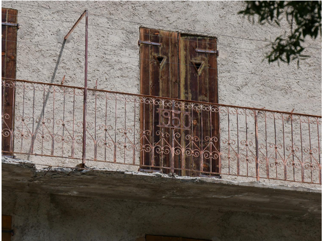
Détail date portée 1950 maison n° 15
