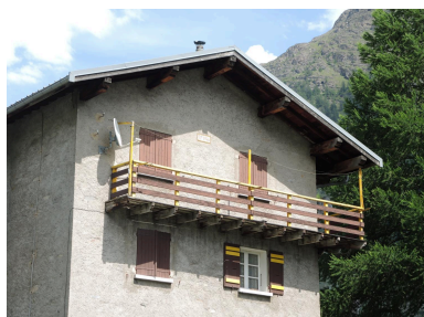
Détail maison n° 1 (Catherine Tracq) et date portée 1946 Phot. Nadine Halitim-Dubois IVR84_20227302996NUCA
