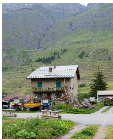
Maison d'Etat n° 4 Phot. Michel Pérès IVR84_20227301206NUCA
