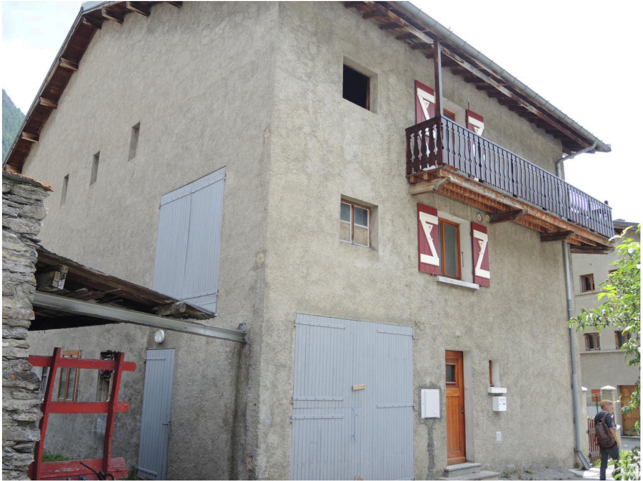
Détail façade est maison n° 17 : porte d'étable
