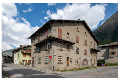
Maison d'Etat n° 5 Phot. Michel Pérès IVR84_20227301210NUCA
