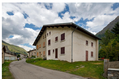
Maison d'Etat n° 2 (maison double) Phot. Michel Pérès IVR84_20227301203NUCA
