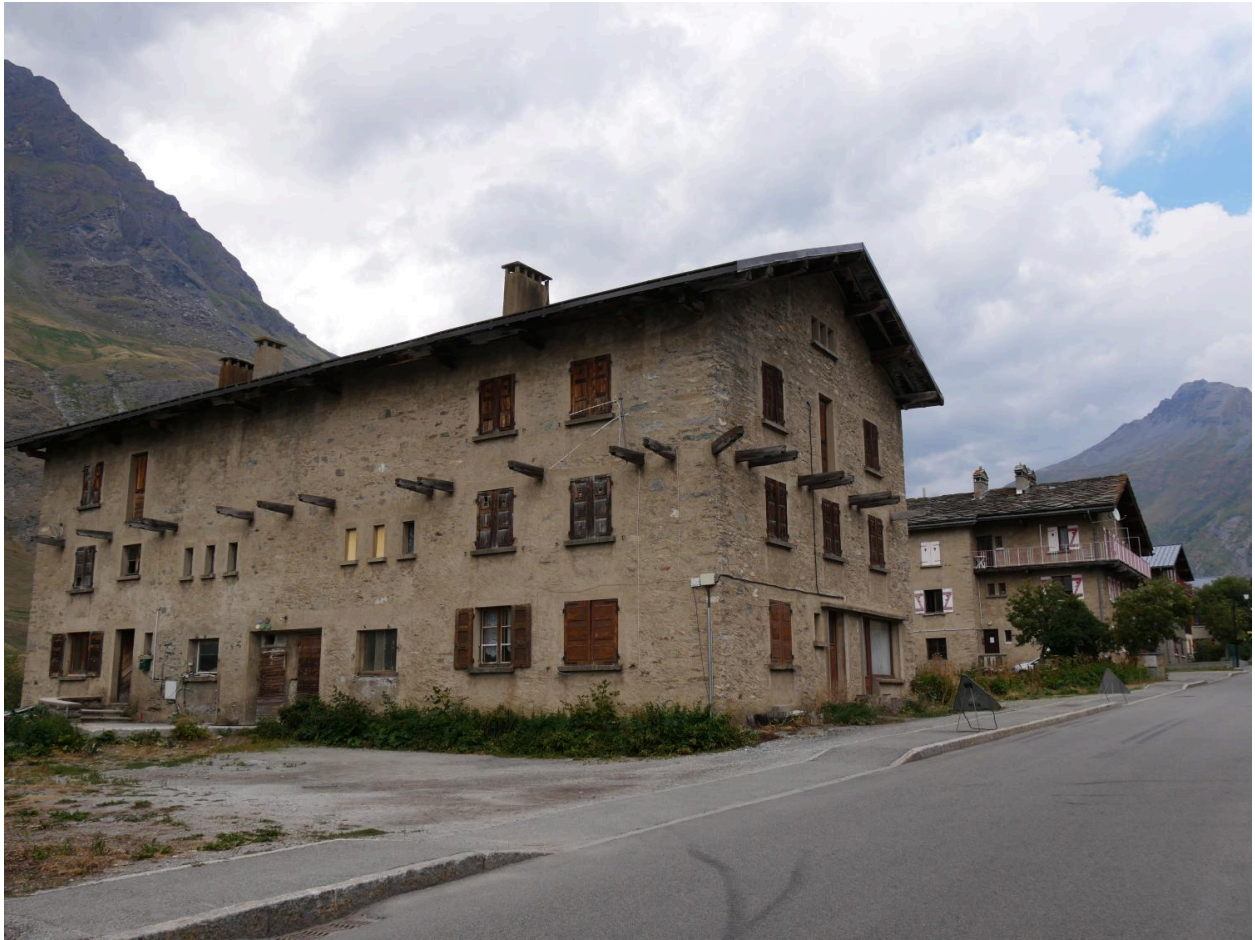
Maison n° 14 maçonnerie de pierres enduites
