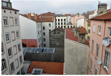
Vue de la toiture en coeur d'îlot Phot. Magali Delavenne IVR82_20156902585NUCA
