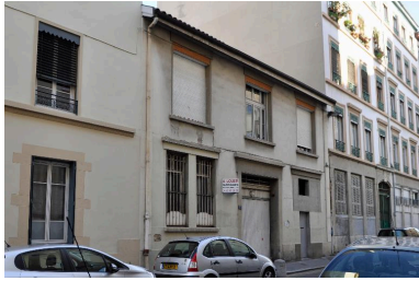
Façade sur rue Phot. Magali Delavenne IVR82_20156902554NUCA
