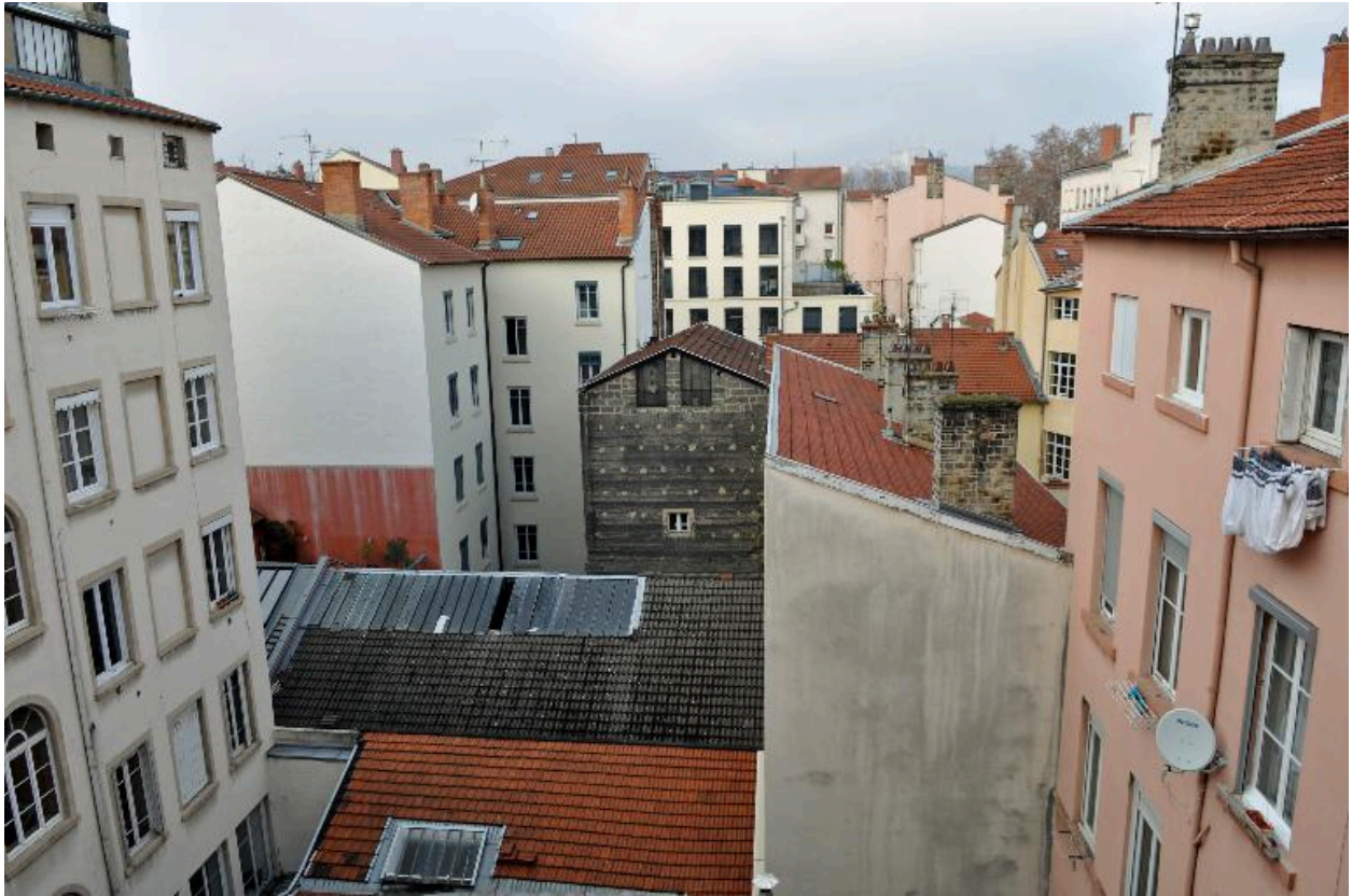
Vue de la toiture en coeur d'ilot
