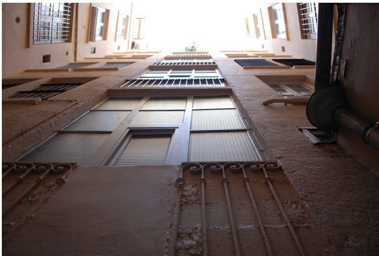
La cour en contre-plongée
