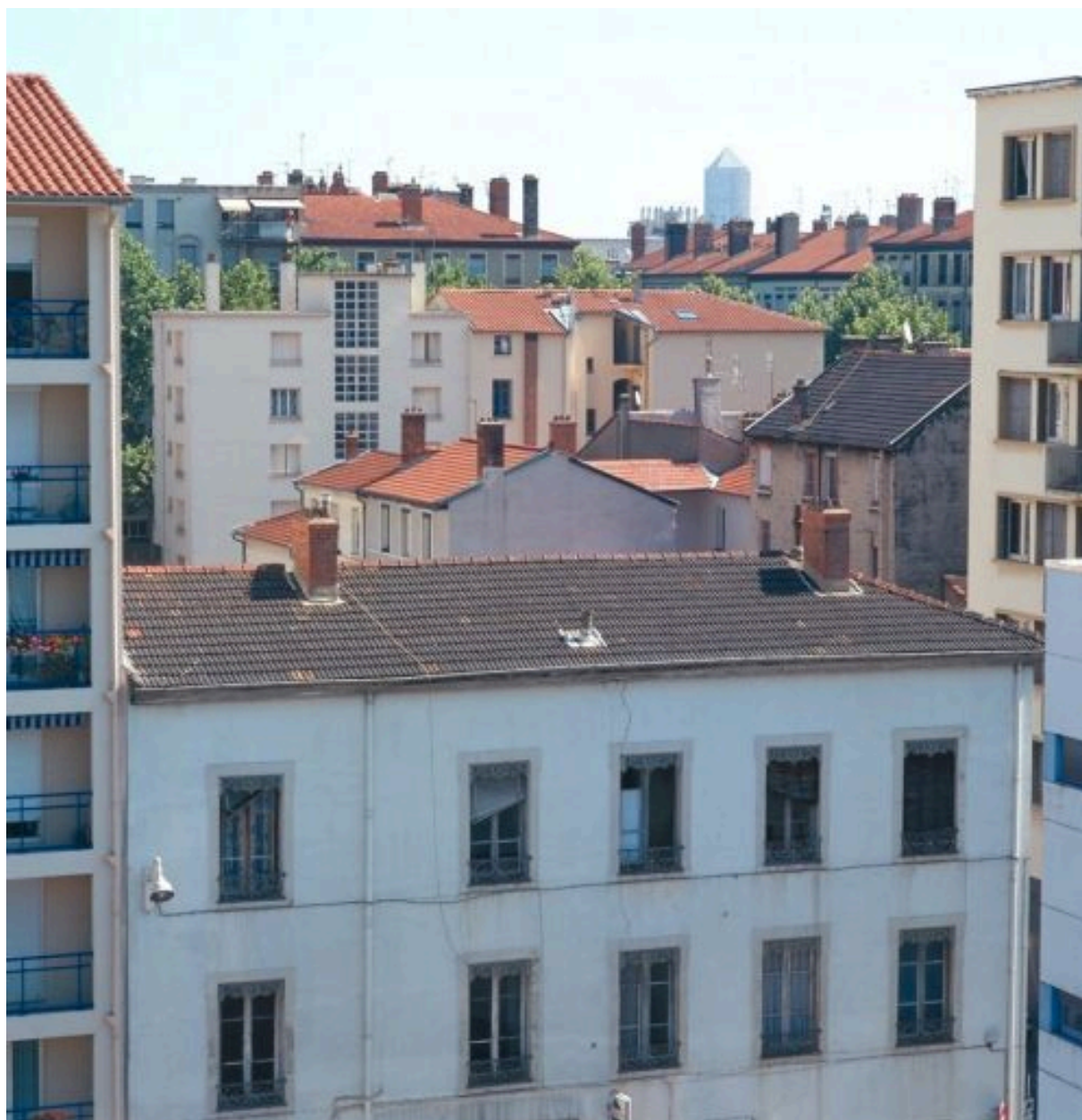
Elévation postérieure depuis le toit du collège Jean-Monnet
