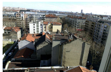
Elévation postérieure de l'immeuble sur rue depuis l'escalier du 35 rue Bichat Phot. Maryannick Chalabi IVR82_20016901789NUCA
