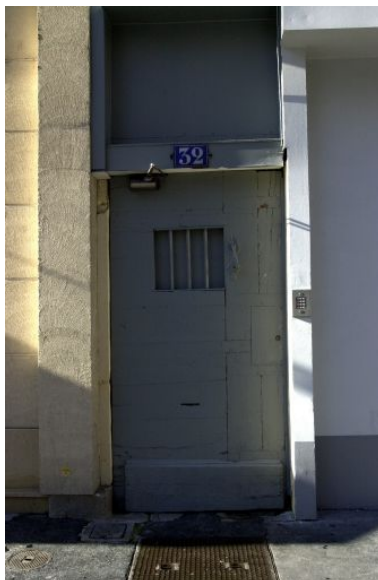
Détail de la porte d'entrée, 32 cours Suchet Phot. Maryannick Chalabi IVR82_20016901788NUCA
