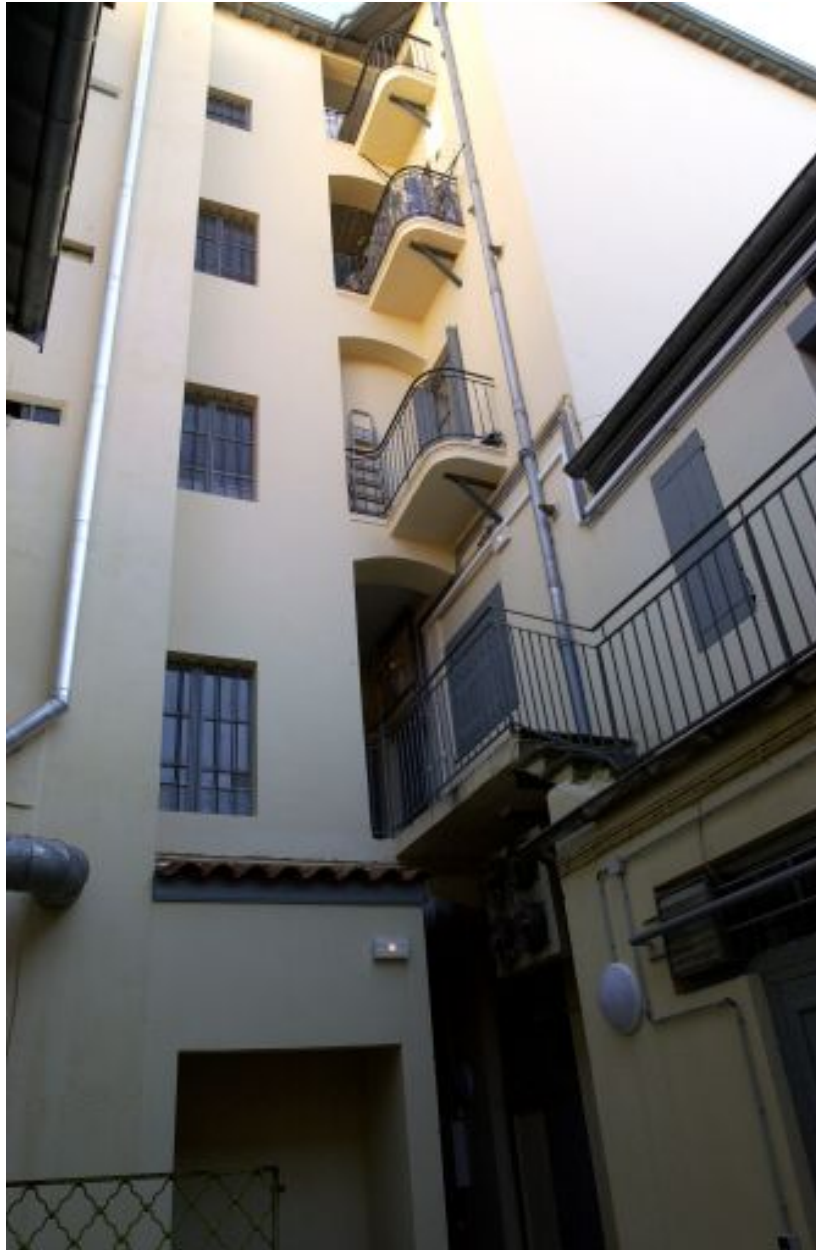
Vue de la cage ouverte de la montée d'escalier
