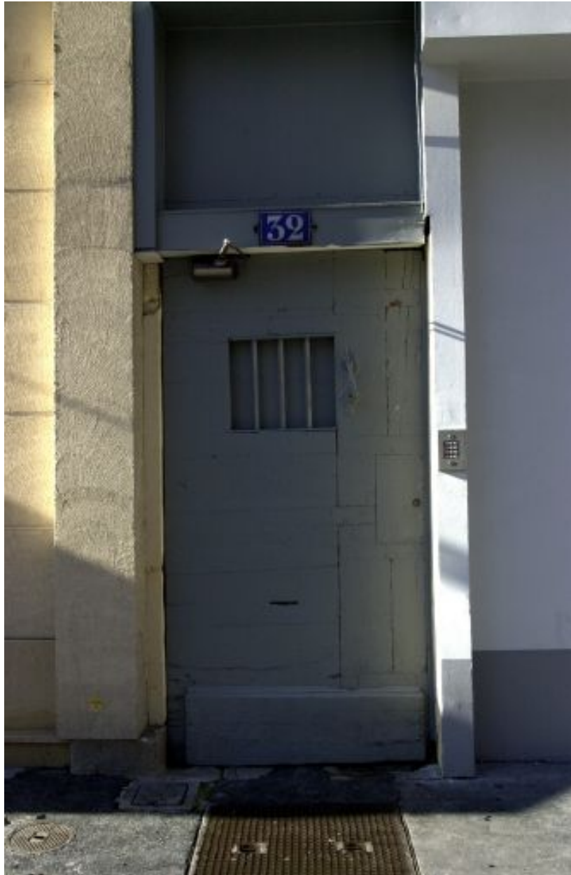
Détail de la porte d'entrée, 32 cours Suchet
