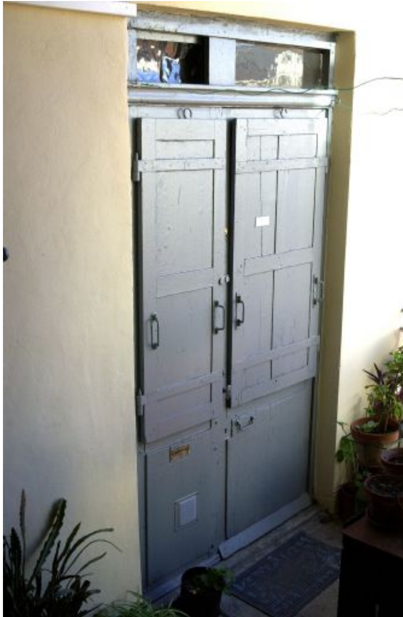
Vue d'une porte d'appartement
