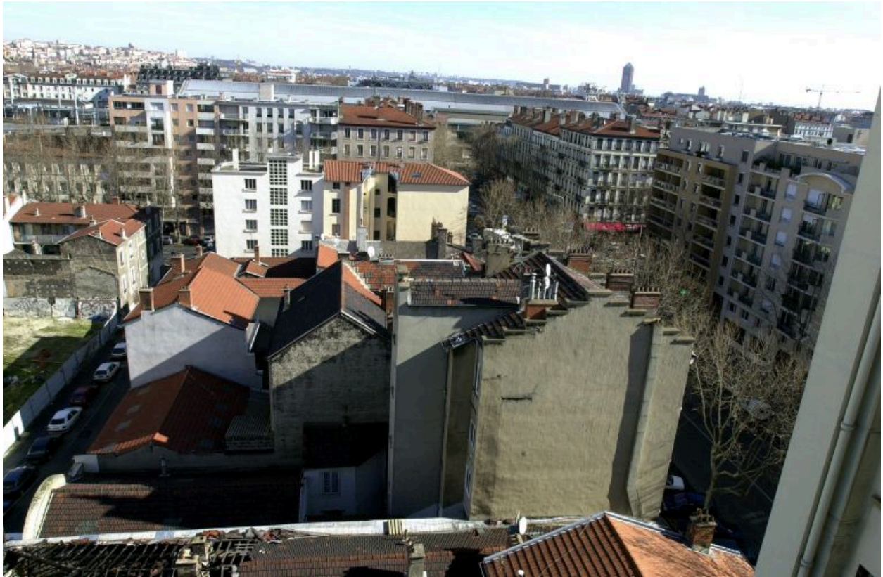
Elévation postérieure de l'immeuble sur rue depuis l'escalier du 35 rue Bichat
