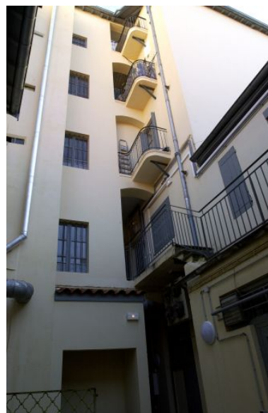
Vue de la cage ouverte de la montée d'escalier Phot. Maryannick Chalabi IVR82_20016901791NUCA
