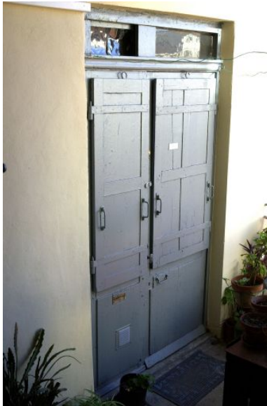
Vue d'une porte d'appartement Phot. Maryannick Chalabi IVR82_20016901792NUCA
