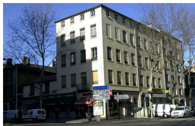
Vue d'ensemble depuis le nord-est Phot. Maryannick Chalabi IVR82_20016901787NUCA
