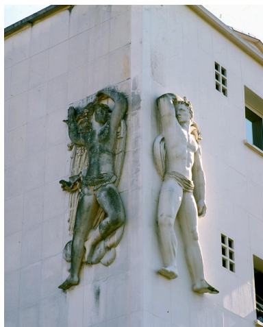
Vue d'ensemble en 2007 Phot. Jean-Michel Périn IVR83_20070300039XA
