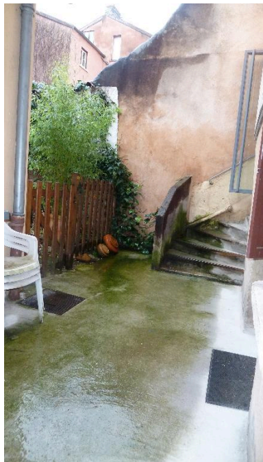
Vue de la cour Phot. Nadine Halitim-Dubois IVR82_20146900291NUCA
