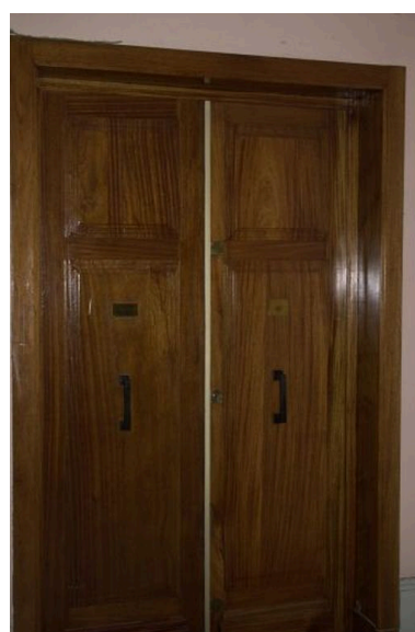
Porte palière Phot. Anaïs Beccaria IVR82_20046903188NUCA
