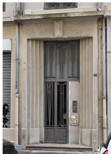
Vue rapprochée de la porte d'entrée, remaniée au milieu 20e siècle Phot. Thierry Leroy IVR84_20196900240NUCAQ
