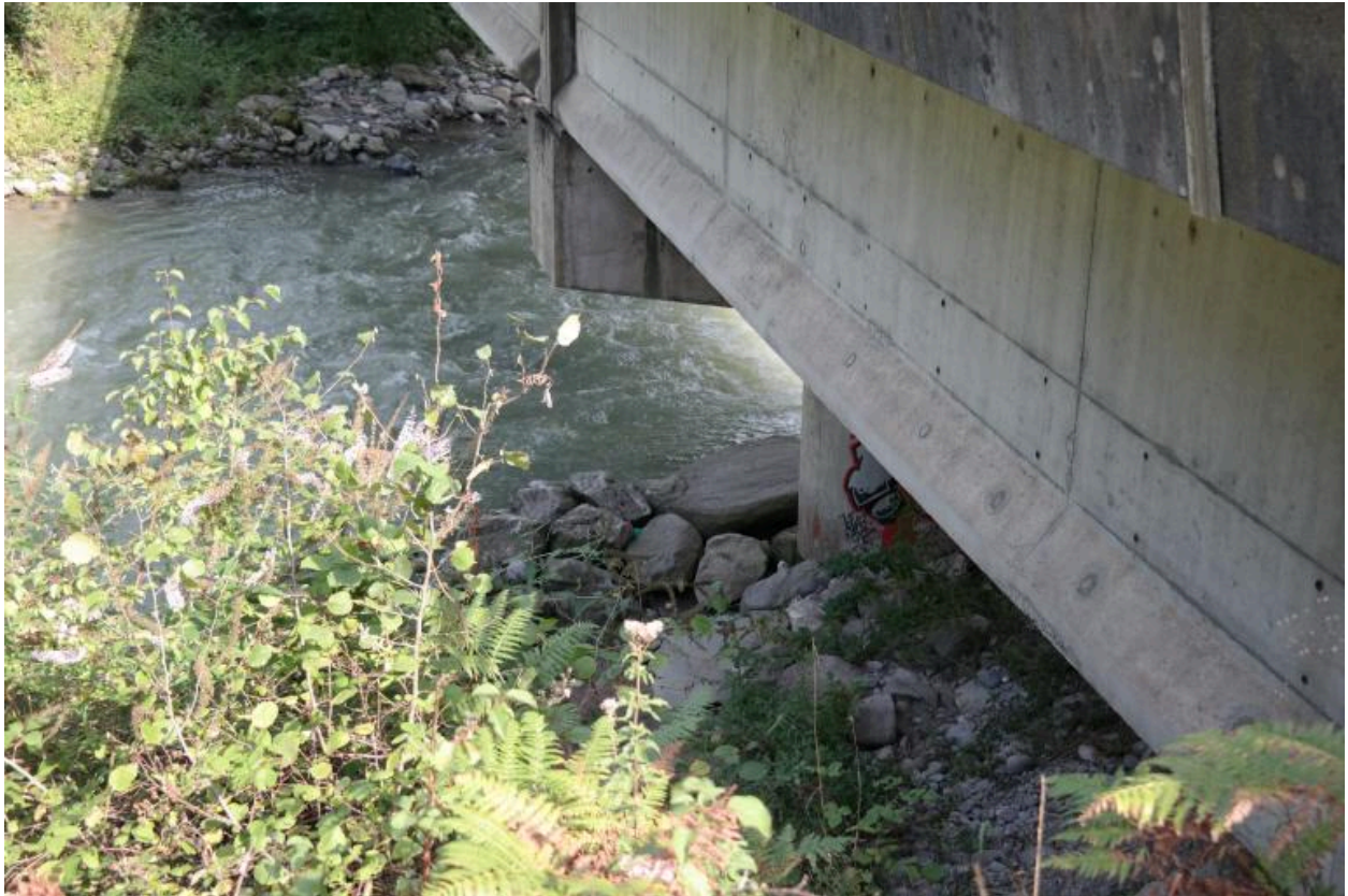
Pont de la Douceur, détail structure
