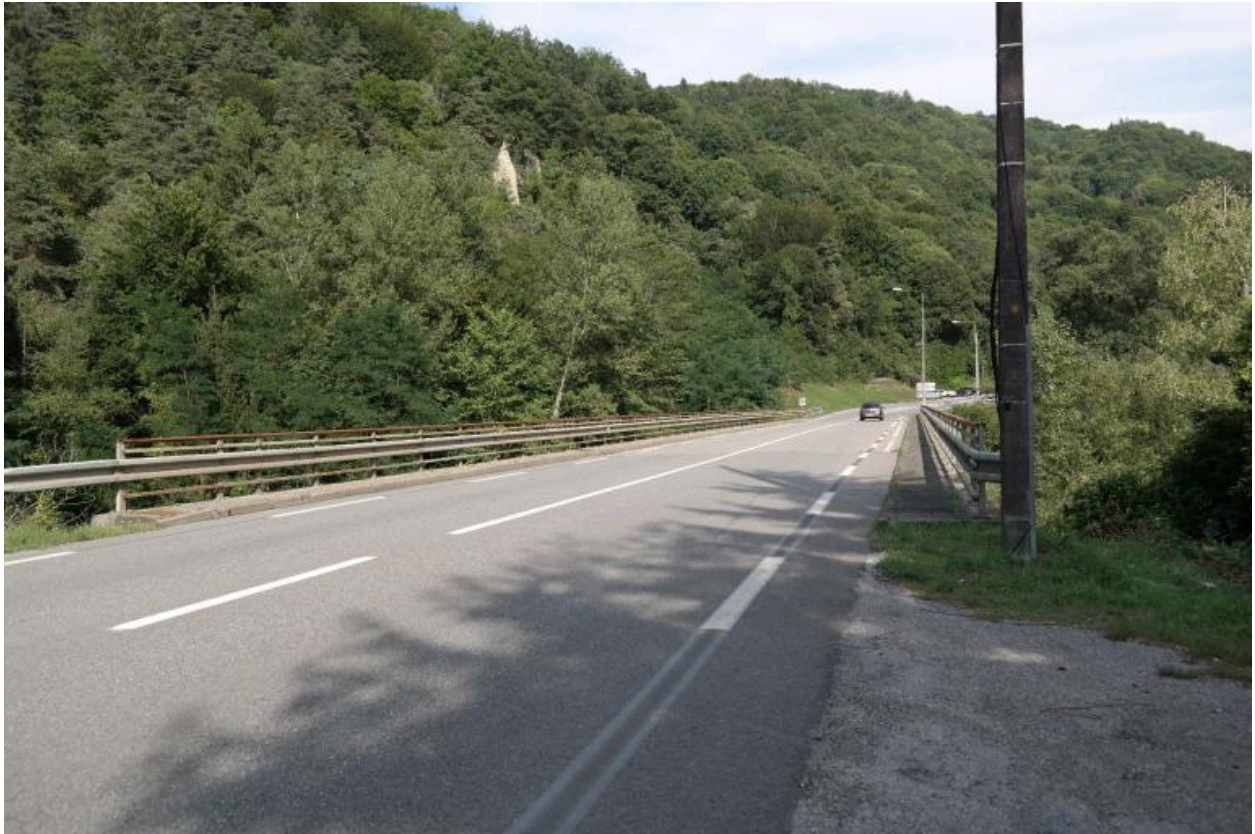
Pont de la Douceur, chaussée et garde-corps. Cheminées de fées en rive droite
