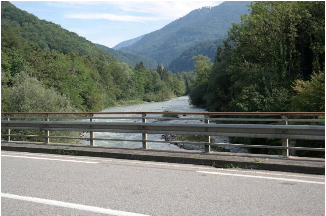
Pont de la Douceur, détail chaussée et garde-corps
