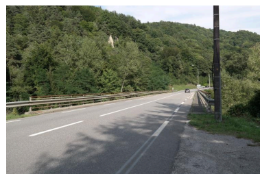
Pont de la Douceur, chaussée et garde-corps. Cheminées de fées en rive droite Phot. Pascale Renard IVR84_20207401621NUCA
