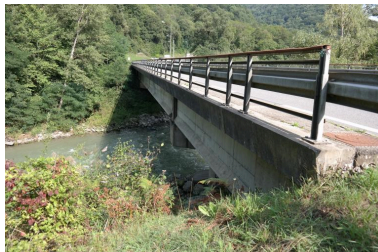
Pont de la Douceur, vue de la face amont Phot. Pascale Renard IVR84_20197401225NUCA
