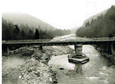
Ancien pont de la Douceur IVR84_20207401620NUCA
