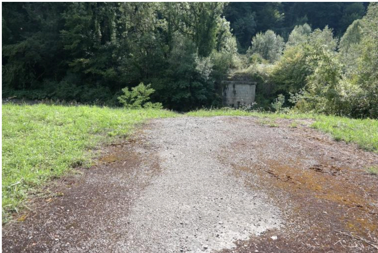
Ancien pont de la Douceur, vue de l'ancienne chaussée en rive droite et de la culée en rive gauche
