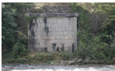
Ancien pont de la Douceur, culée rive gauche Phot. Pascale Renard IVR84_20207401618NUCA
