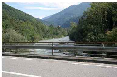
Pont de la Douceur, détail chaussée et garde-corps Phot. Pascale Renard IVR84_20207401617NUCA
