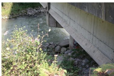
Pont de la Douceur, détail structure Phot. Pascale Renard IVR84_20207401619NUCA
