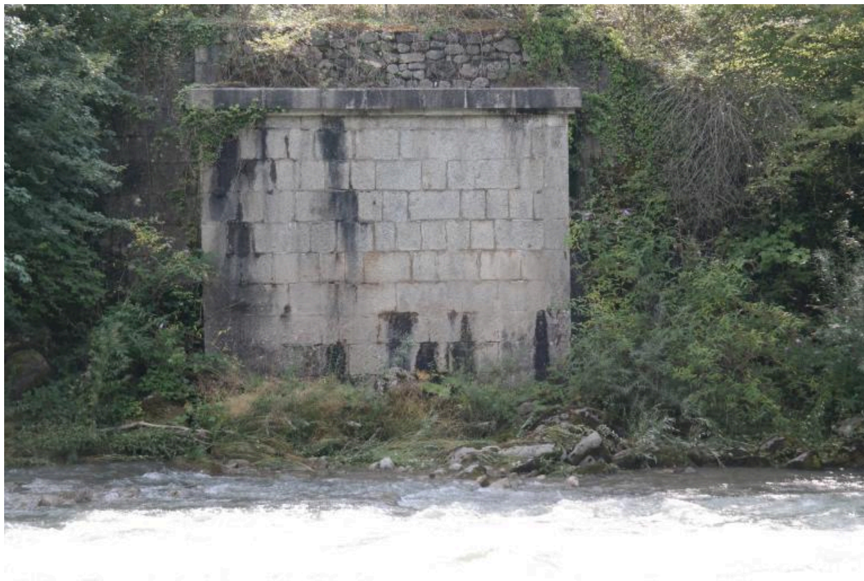
Ancien pont de la Douceur, culée rive gauche
