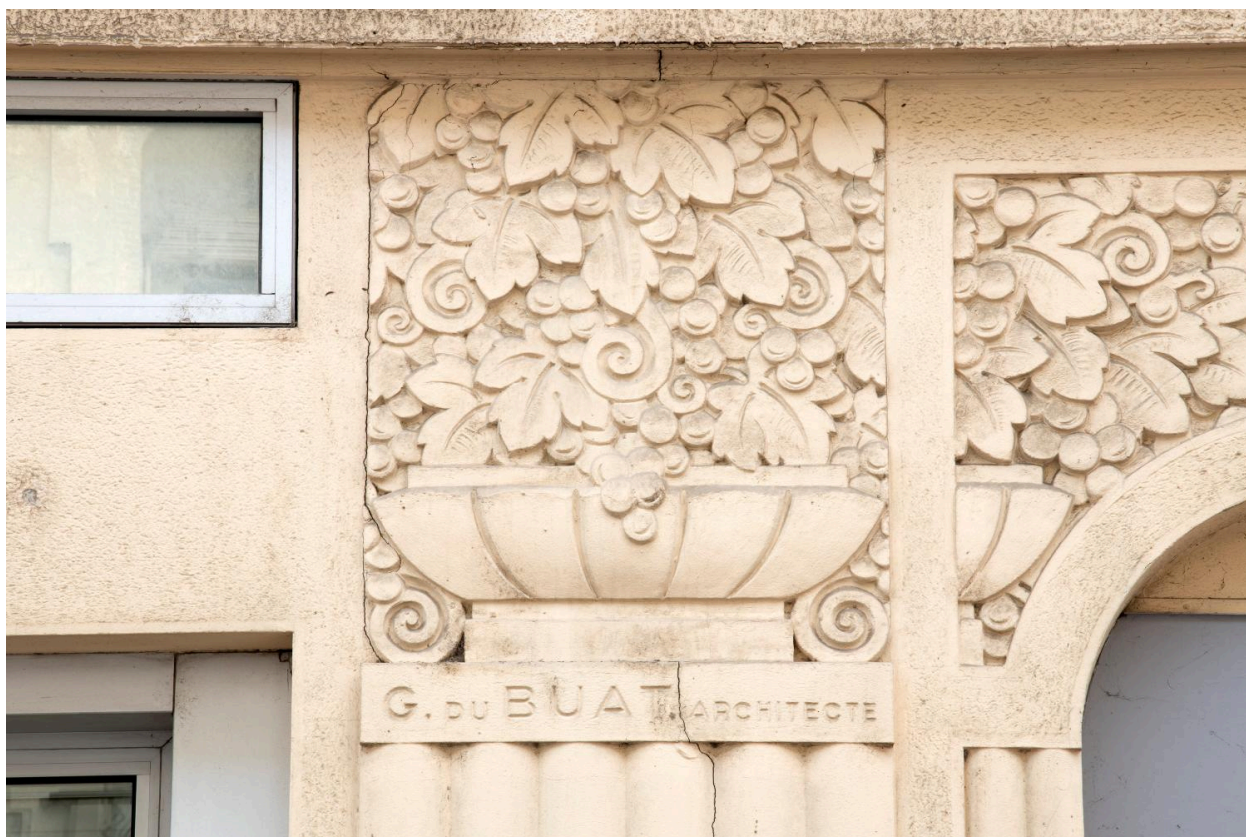
Corbeille de pampres située à droite du n° 110 (motif rectangulaire) avec la signature de l'architecte
