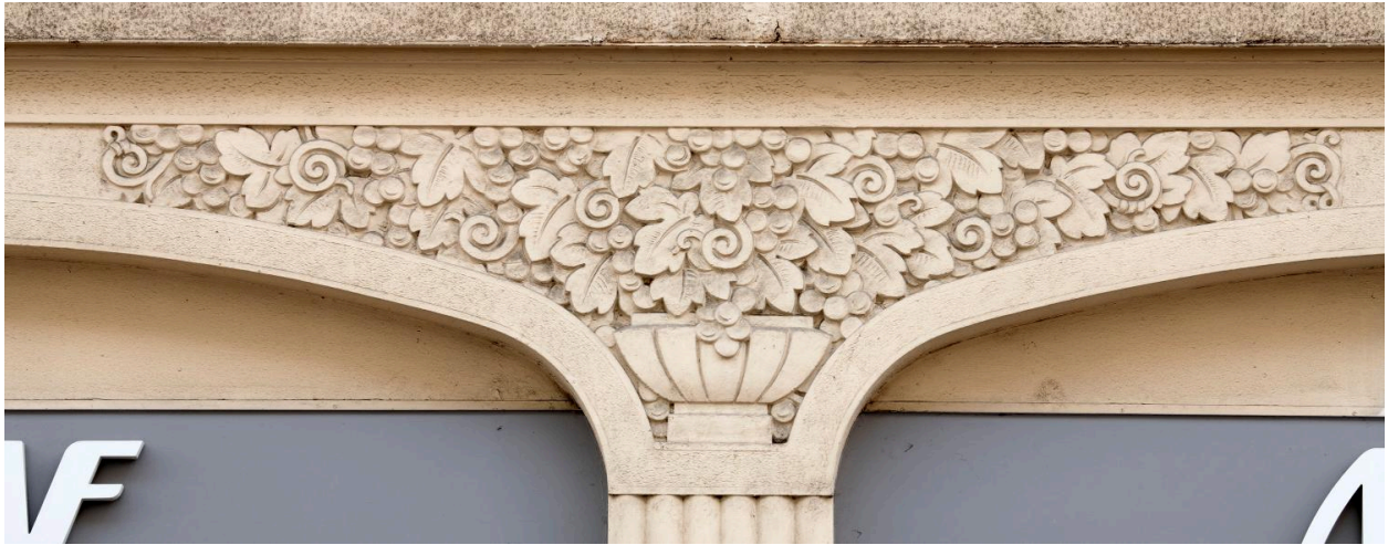
Détail de l'un des motifs en écoinçon situés entre les fenêtres couvertes d'un arc surbaissé
