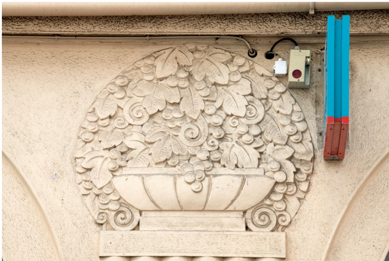
Corbeille de pampres située à droite de la porte cochère sise n° 118 de la rue (motif circulaire)
