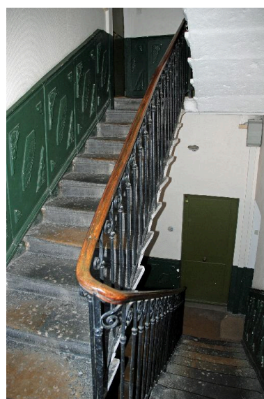
Vue intérieure : la cage d'escalier Phot. Magali Delavenne IVR82_20146902976NUCA
