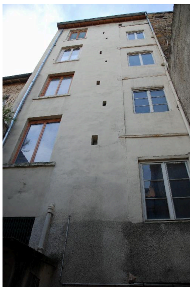
Vue partielle de l'élévation sur cour Phot. Magali Delavenne IVR82_20146902973NUCA
