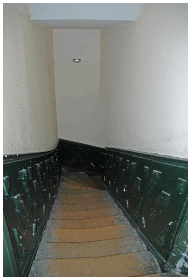
Vue intérieure : la première volée de l'escalier Phot. Magali Delavenne IVR82_20146902977NUCA
