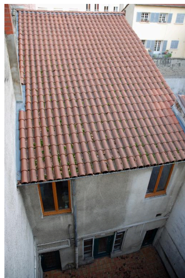
Bâtiment sur cour, vue plongeante Phot. Magali Delavenne IVR82_20146902978NUCA
