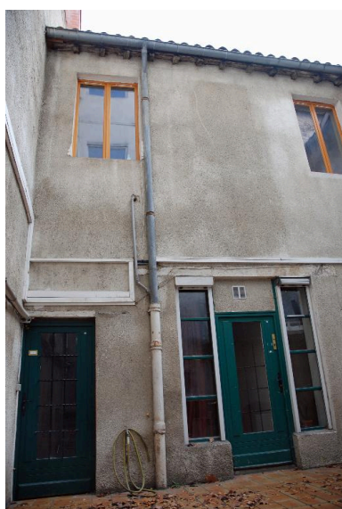
Bâtiment sur cour, vue partielle Phot. Magali Delavenne IVR82_20146902979NUCA
