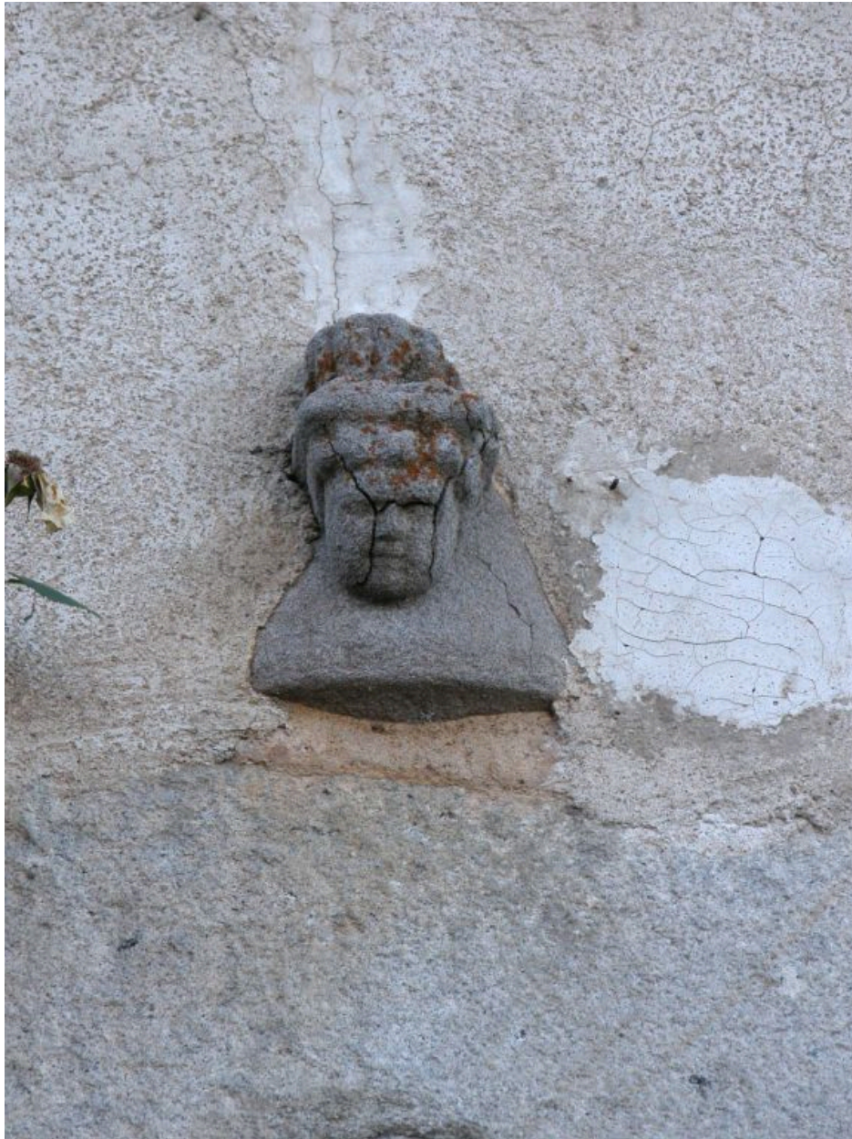
Détail d'une sculpture (culot d'arc, ?) rapportée au-dessus de la porte d'entrée principale du logis.
