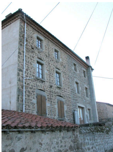
Élévation droite du logis de la ferme. Phot. Thierry Monnet IVR82_20124200656NUCA
