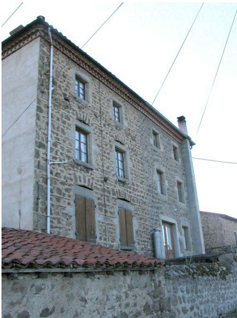
Elévation droite du logis de la ferme.
