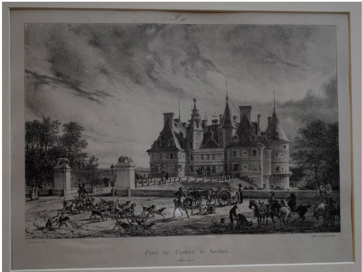
Vue générale - Entrée du Château de Randan
