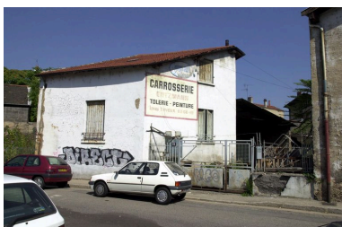
Vue de la maison depuis la rue Phot. François Blanchetière IVR82_20016902259NUCA
