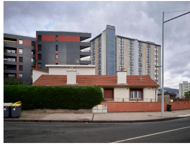
Élévation principale, en bordure du carrefour, de la dernière maison de la cité encore en place.
