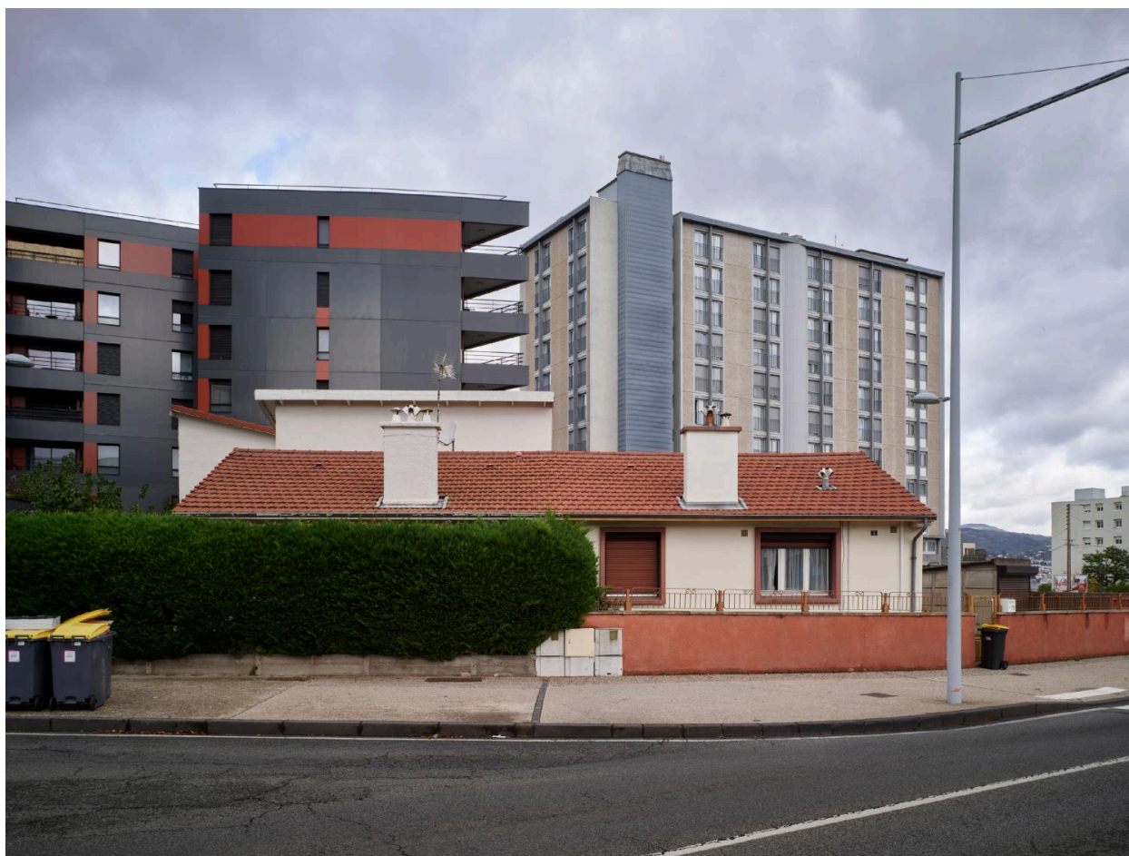
Élévation principale, en bordure du carrefour, de la dernière maison de la cité encore en place.
