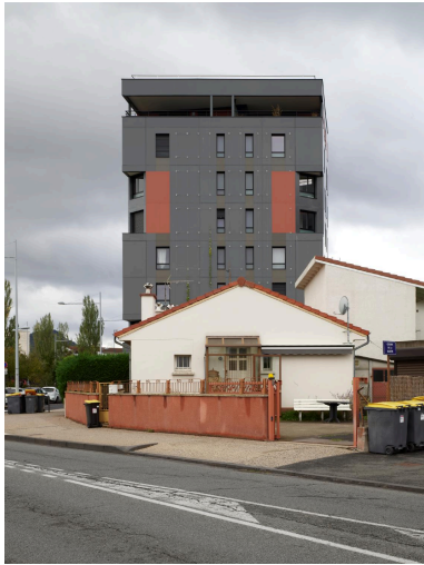
Vue depuis le nord-est de la dernière maison de la cité des Liondards, sur le plateau Saint-Jacques.
