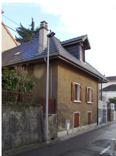
Elévation sur rue Phot. François Fouger IVR82_20087300193NUCA
