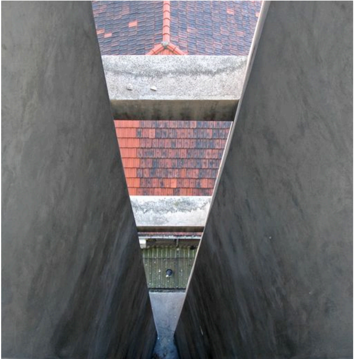
Vue de la courette éclairant la cage d'escalier
