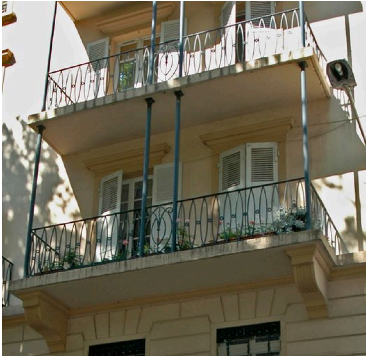
Détail des balcons sur rue
