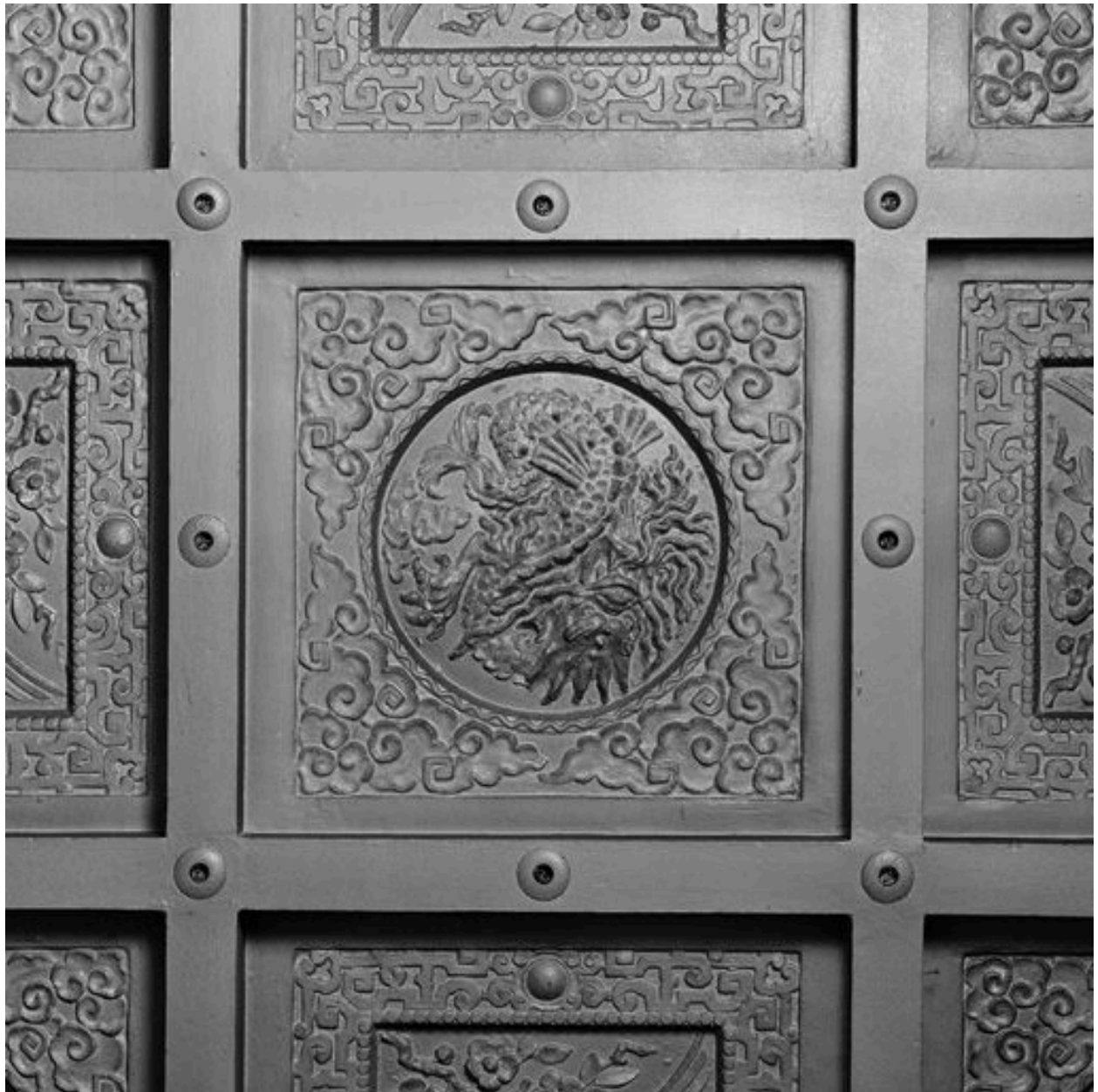
Détail d'un caisson
