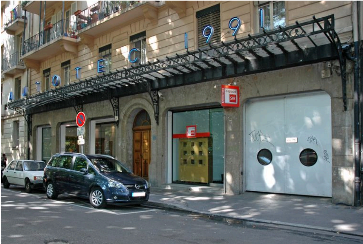
Vue de la marquise depuis le nord-est
