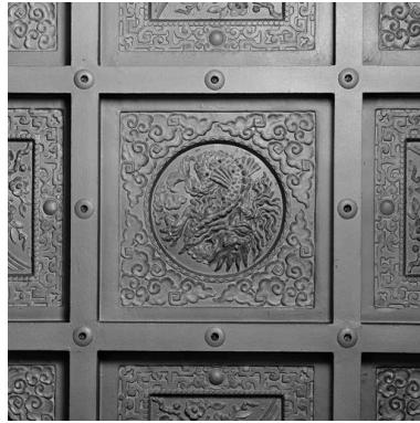
Détail d'un caisson Phot. Didier Gourbin IVR82_20066902191X
