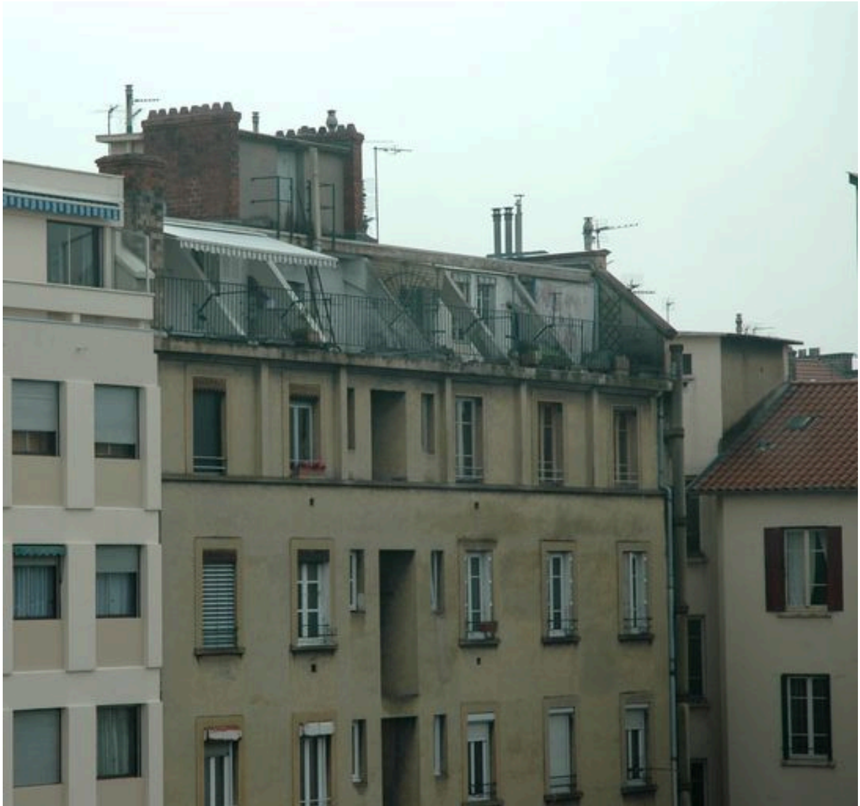
Elévation postérieure. Détail des derniers étages
