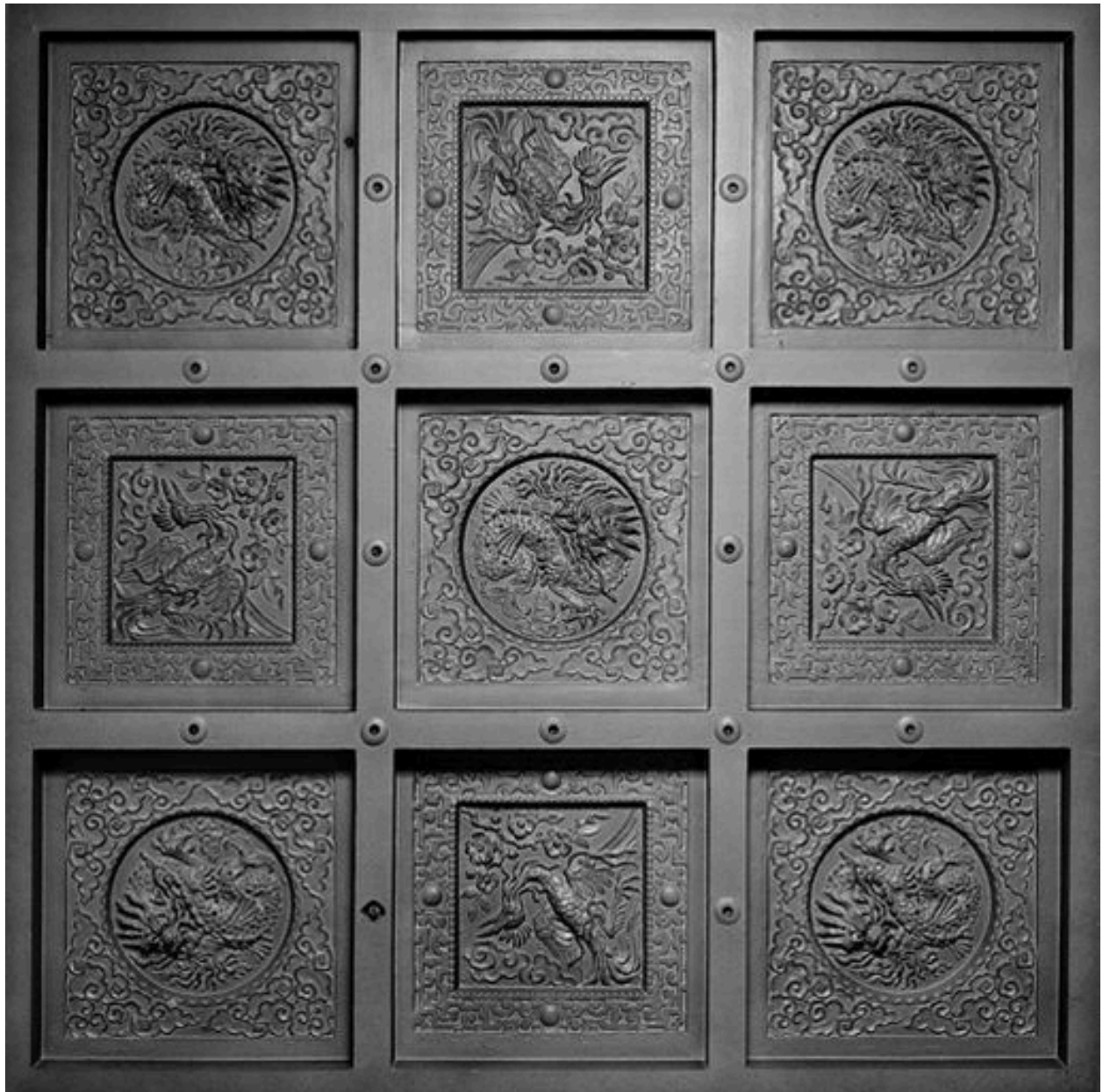
Plafond à caissons
