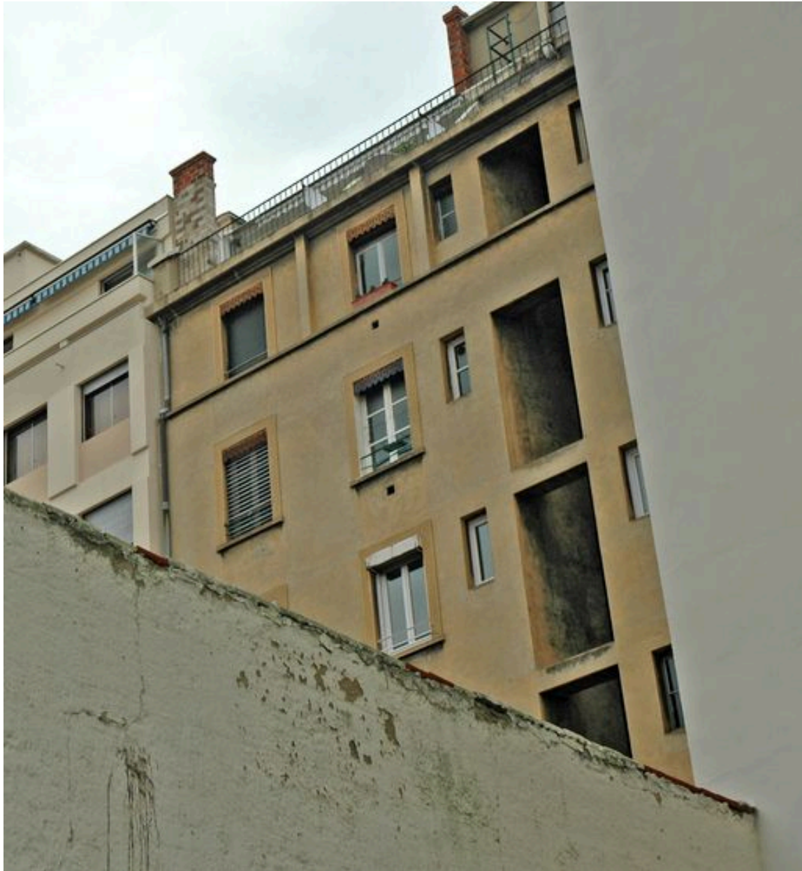
Elévation postérieure. Détail de la cage d'escalier
