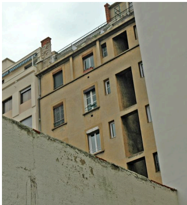
Elévation postérieure. Détail de la cage d'escalier Phot. Maryannick Chalabi IVR82_20066903119NUCA
