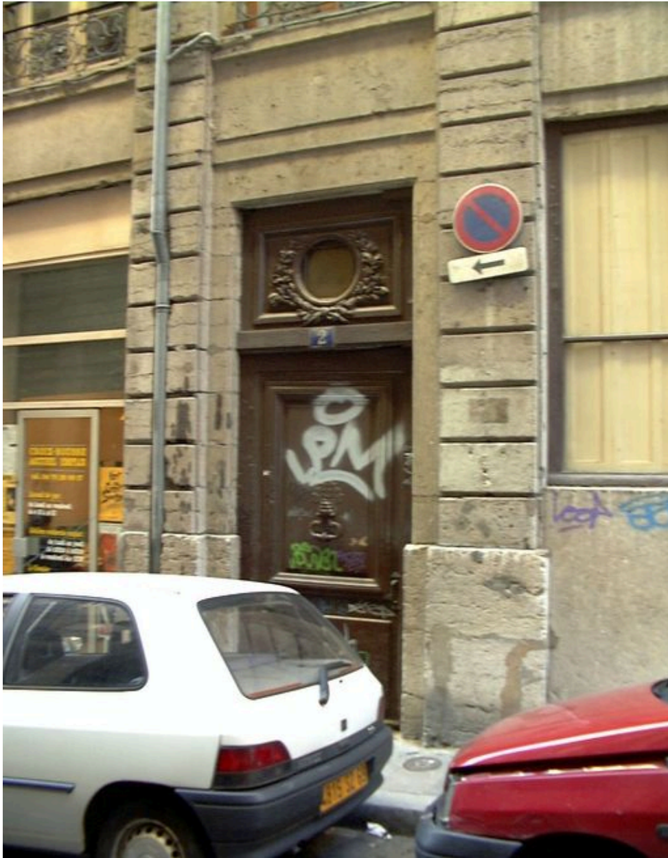
Vue générale de la porte d'entrée de l'immeuble
