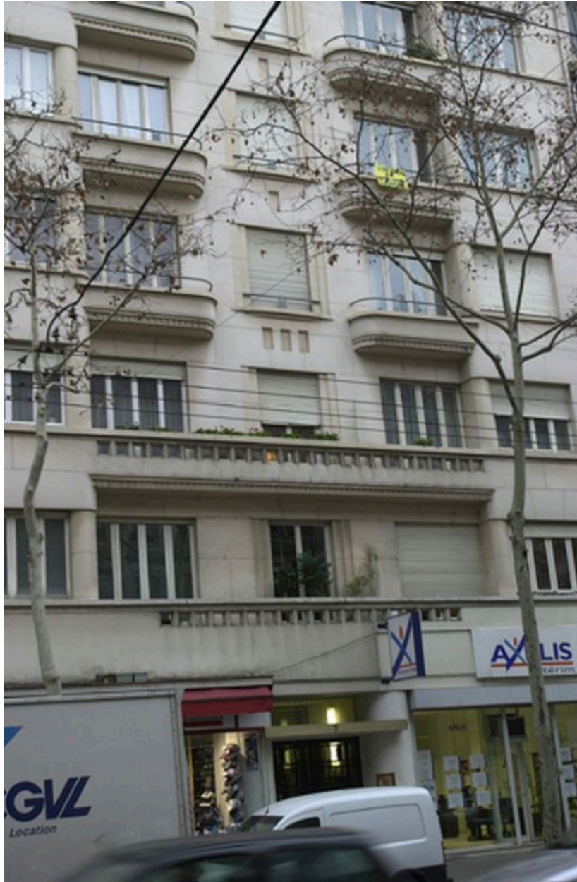
Vue de la travée centrale de la façade sur rue
