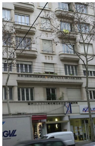
Vue de la travée centrale de la façade sur rue Phot. Maryannick Chalabi IVR82_20046904306NUCA
