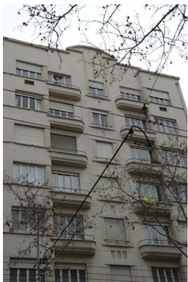
Détail de la travée centrale de la façade (vers le haut) Phot. Maryannick Chalabi IVR82_20046904307NUCA
