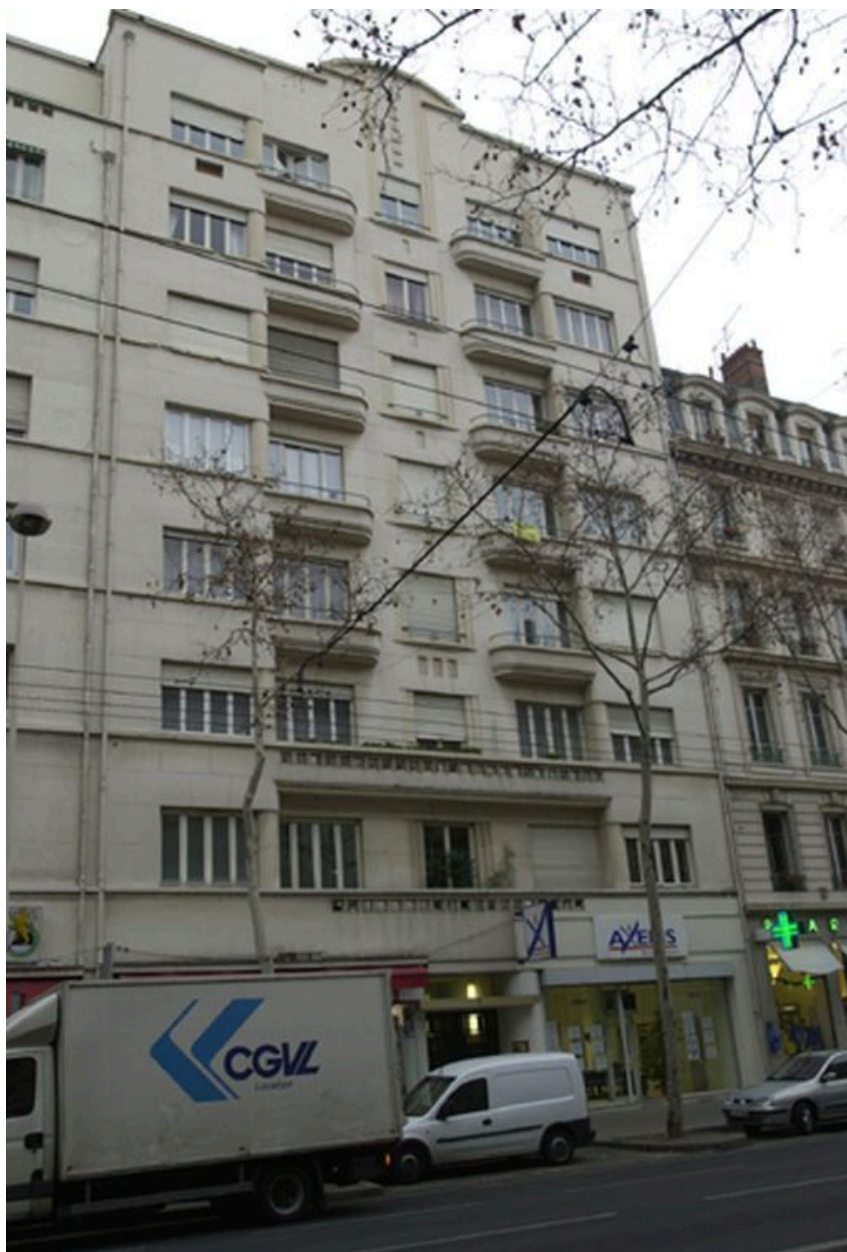
Vue générale de l'élévation sur rue
