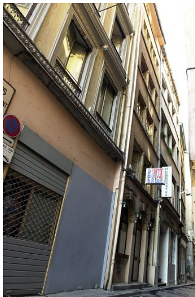
Façade sur rue, vue générale Phot. Lore Derail IVR82_20046900063NUCA
