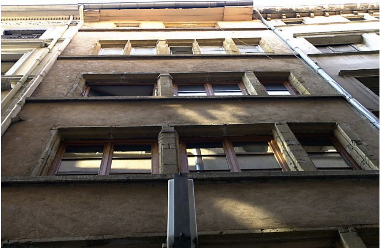
Façade sur rue, vue des 4 étages supérieurs
