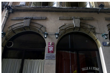
Façade sur rue, détail des arcs de l'ancienne boutique Phot. Lore Derail IVR82_20046900064NUCA
