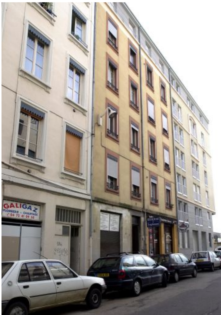
Elevation rue Denuzière depuis le nord
