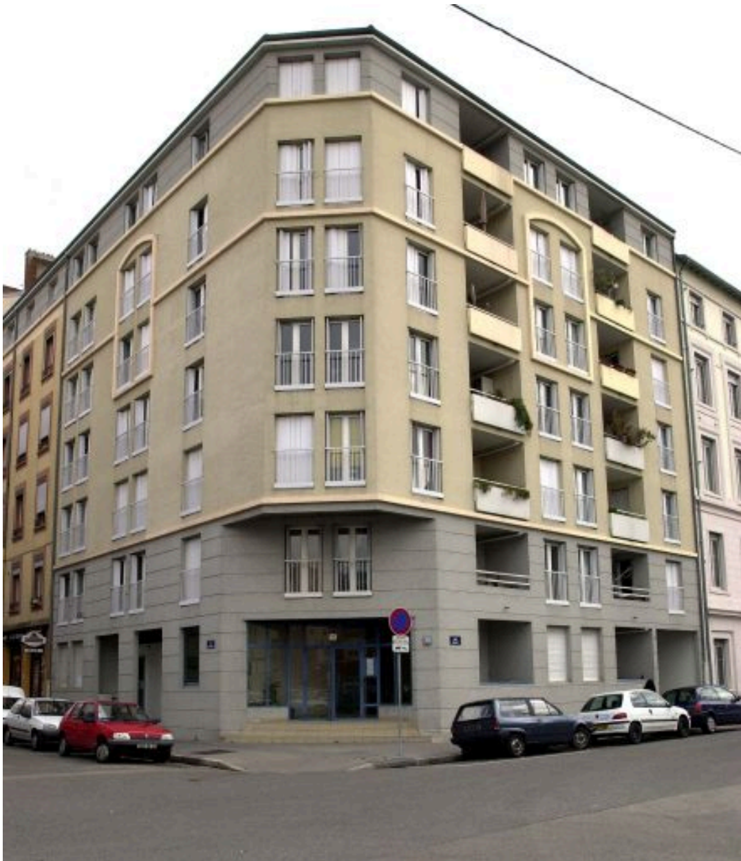
Vue générale à l'angle des rues Denuzière et Bichat
