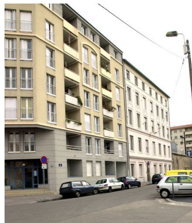
Elévation rue Bichat depuis l'ouest Phot. Maryannick Chalabi IVR82_20016902127NUCA
