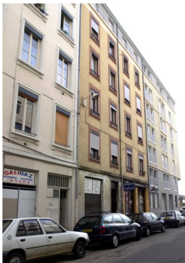
Elevation rue Denuzière depuis le nord Phot. Maryannick Chalabi IVR82_20016902122NUCA
