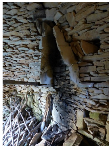
Cabane nord. Mur sud, cheminée. Phot. Alexeï Laurent IVR84_20162601199NUCA
