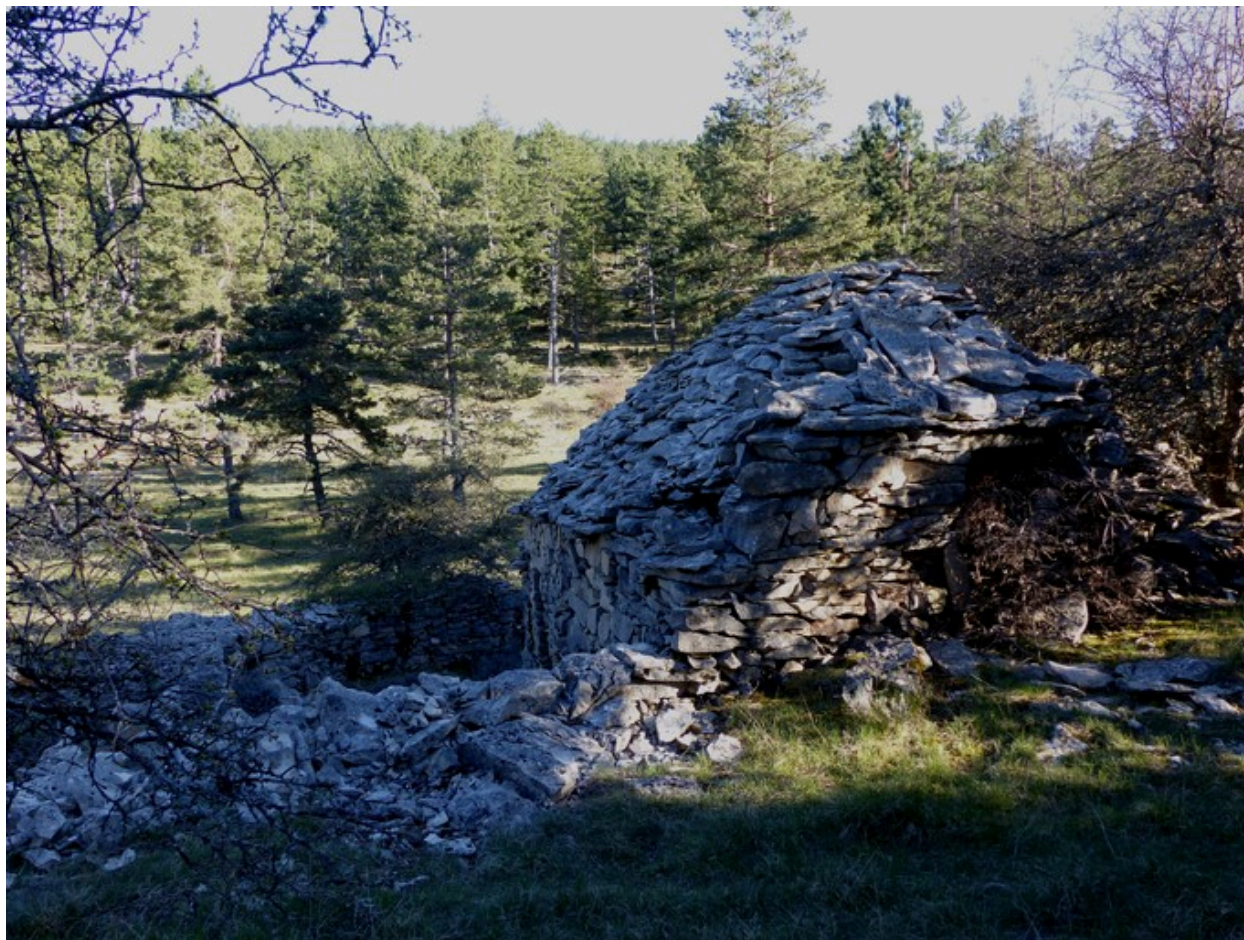
Cabane nord. Vue d'ensemble prise du nord-ouest.
