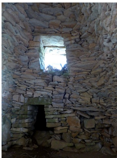
Cabane nord. Mur ouest. Phot. Alexeï Laurent IVR84_20162601201NUCA
