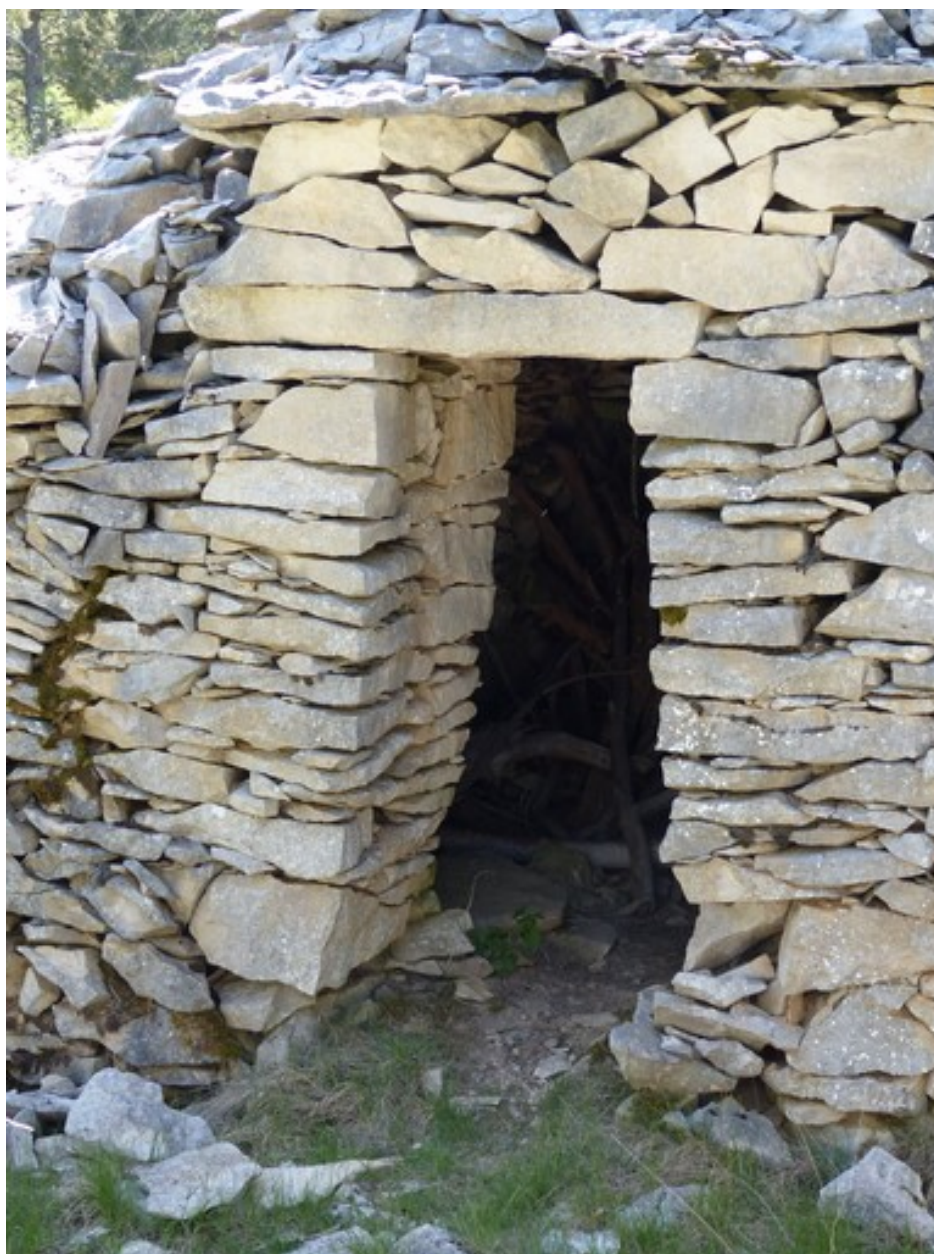
Cabane nord. Elévation nord, porte.
