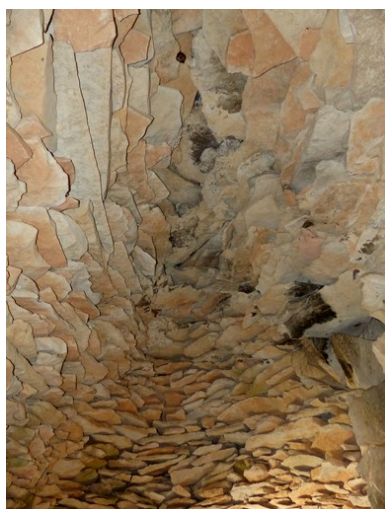
Cabane nord. Coupole en encorbellement. Phot. Alexeï Laurent
