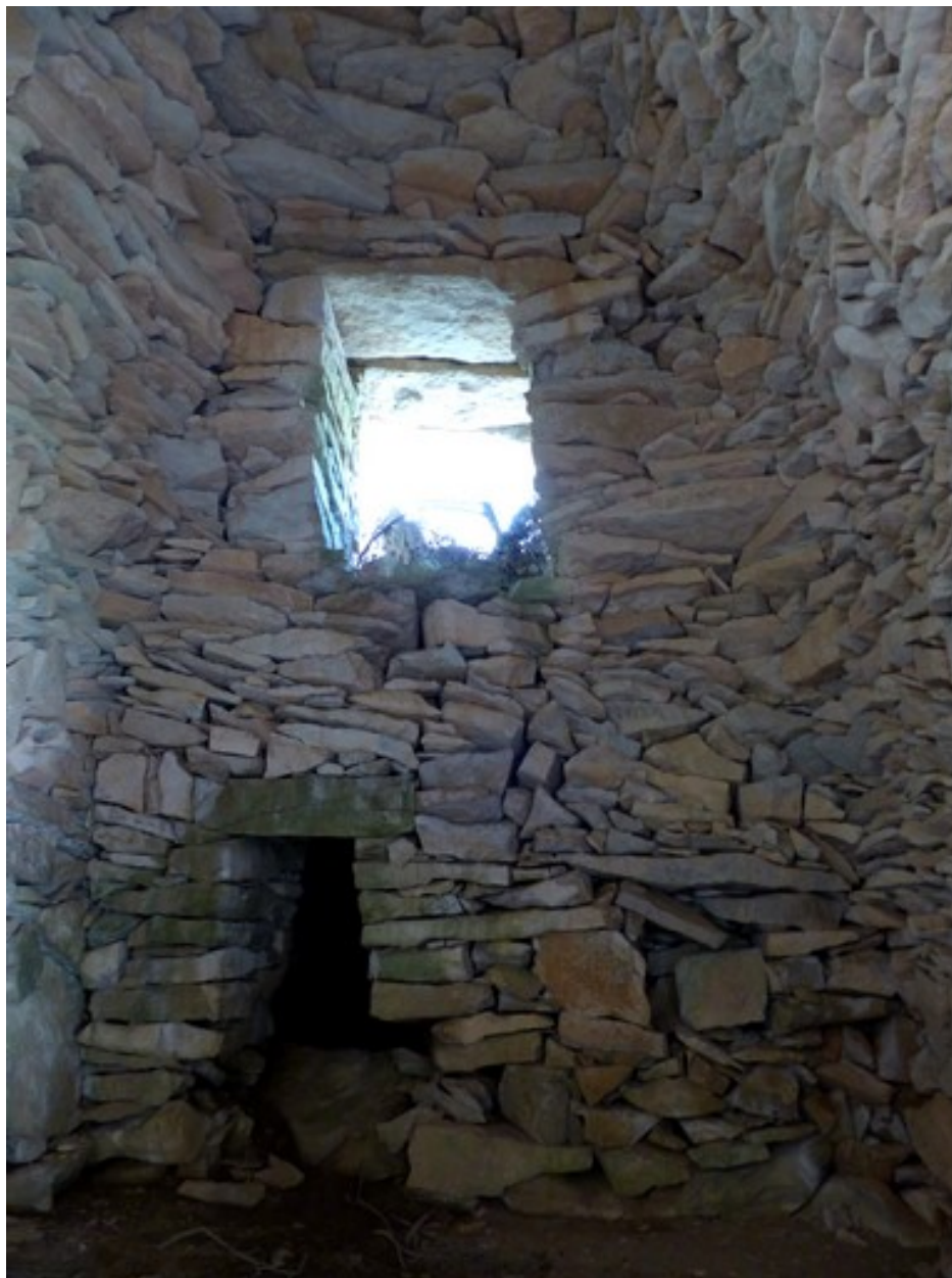
Cabane nord. Mur ouest.
