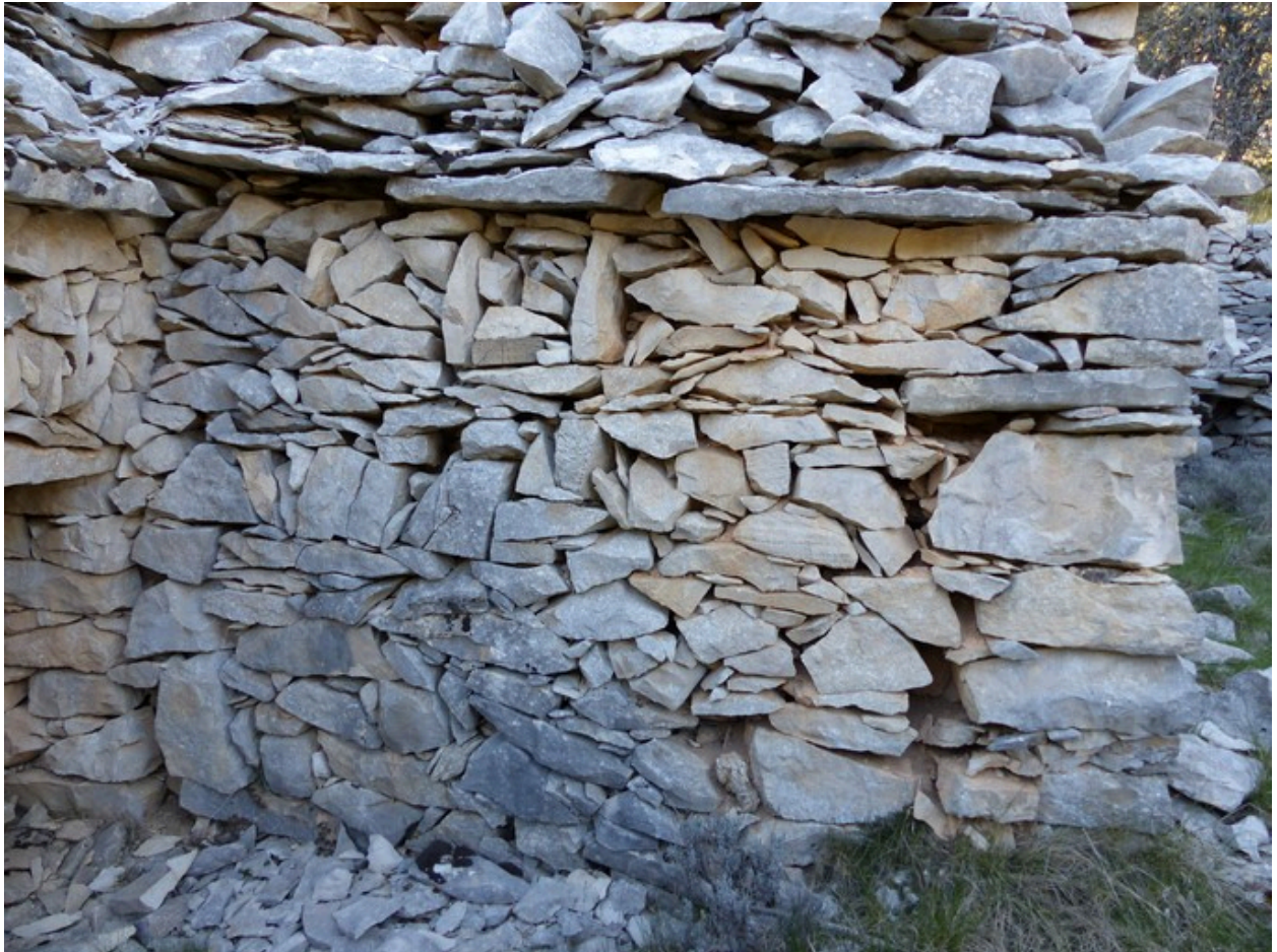
Cabane nord. Elévation est, collage de la maçonnerie.
