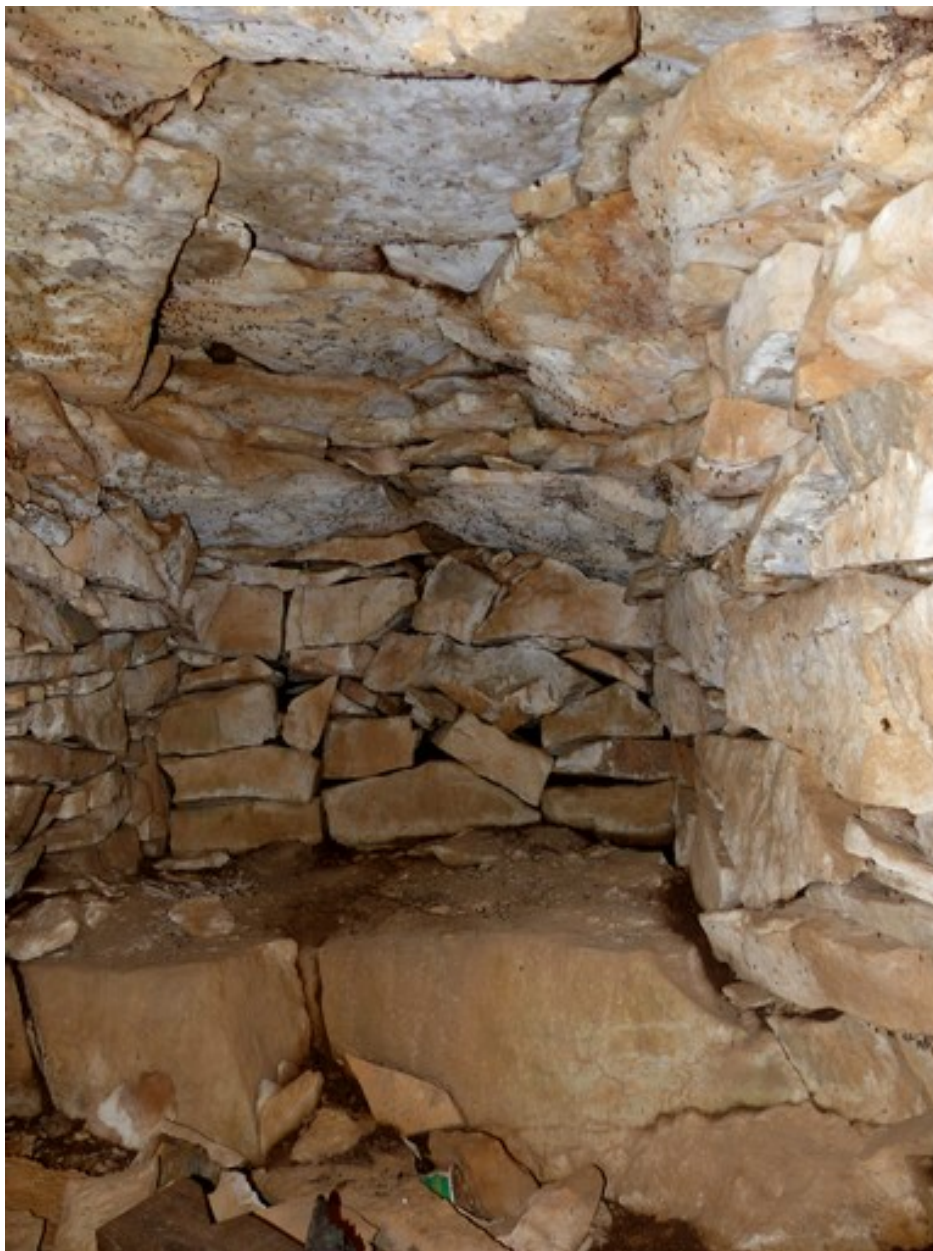
Cabane nord. Resserre, vue de volume.
