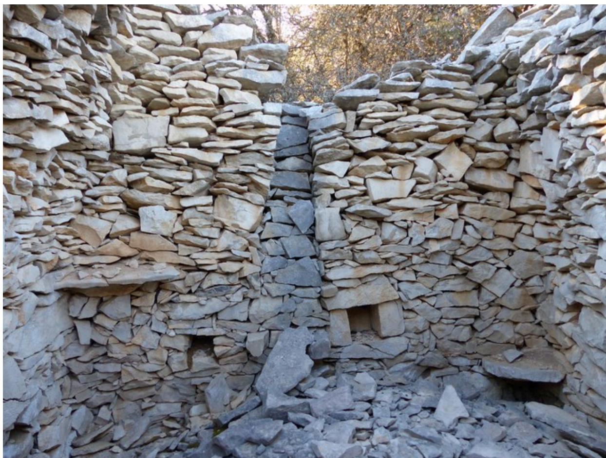
Cabane sud. Mur ouest, ancienne cheminée.
