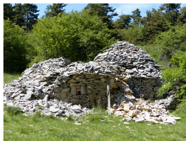
Vue d'ensemble prise de l'est. Phot. Alexeï Laurent IVR84_20162601186NUCA
