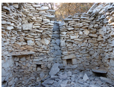
Cabane sud. Mur ouest, ancienne cheminée. Phot. Alexeï Laurent IVR84_20162601189NUCA
