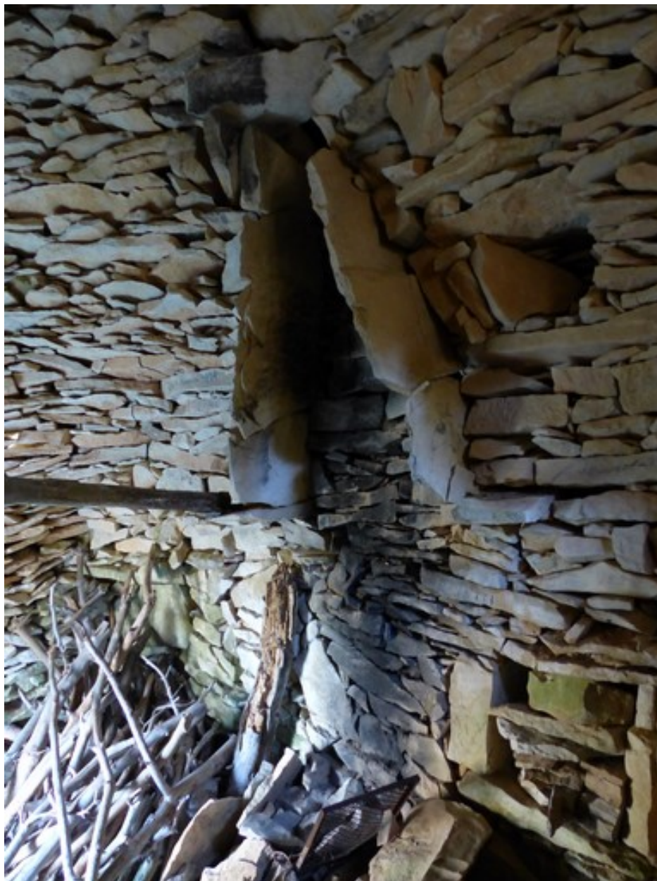
Cabane nord. Mur sud, cheminée.
