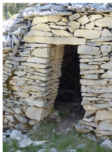
Cabane nord. Elévation nord, porte. Phot. Alexeï Laurent IVR84_20162601196NUCA
