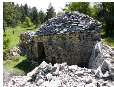
Cabane nord. Vue d'ensemble prise du nord. Phot. Alexeï Laurent IVR84_20162601193NUCA
