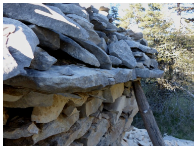
Cabane sud. Elévation est, avant- toit en lauze formant larmier. Phot. Alexeï Laurent IVR84_20162601191NUCA
