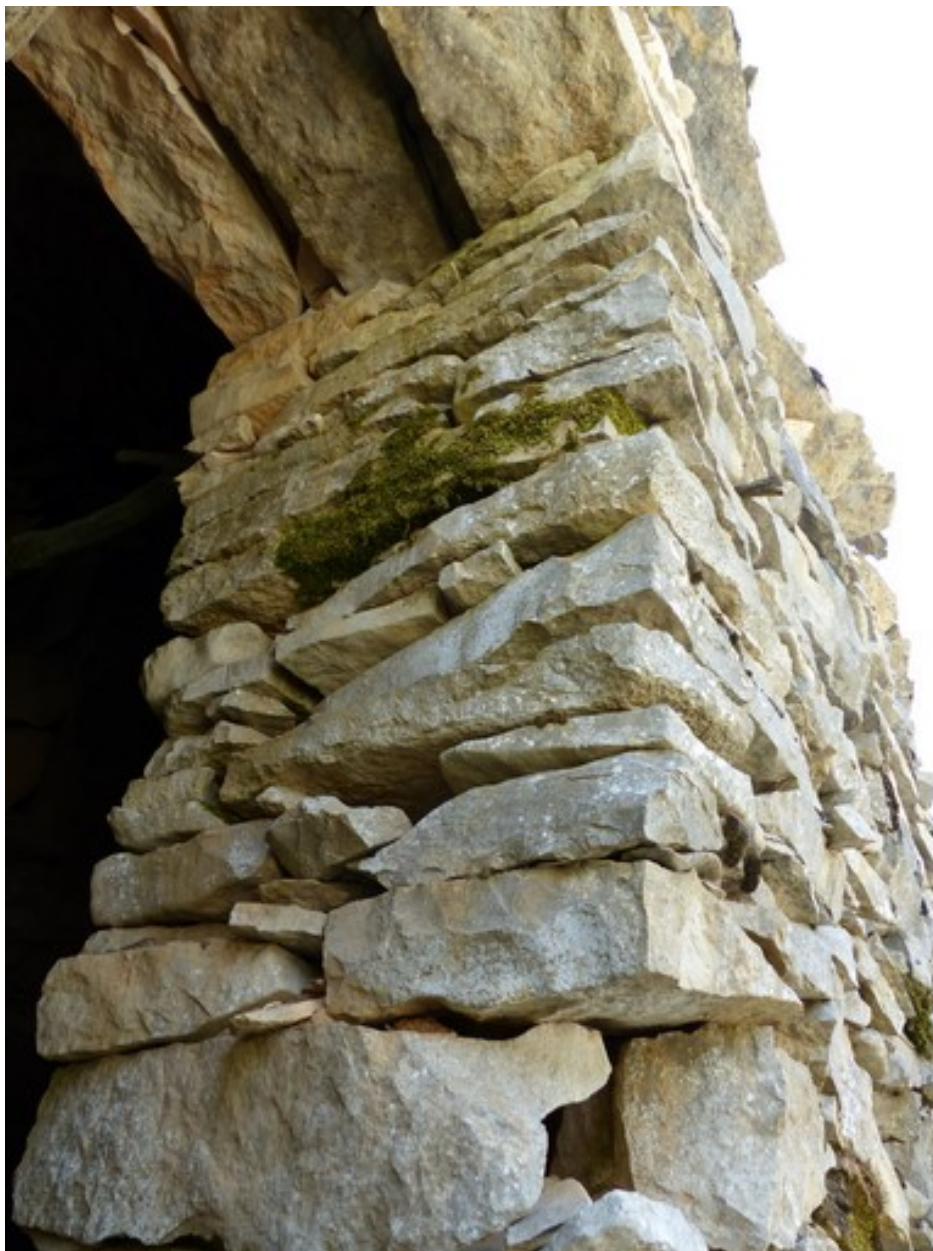
Cabane nord. Élévation nord, porte. Détail de l'embrasure.
