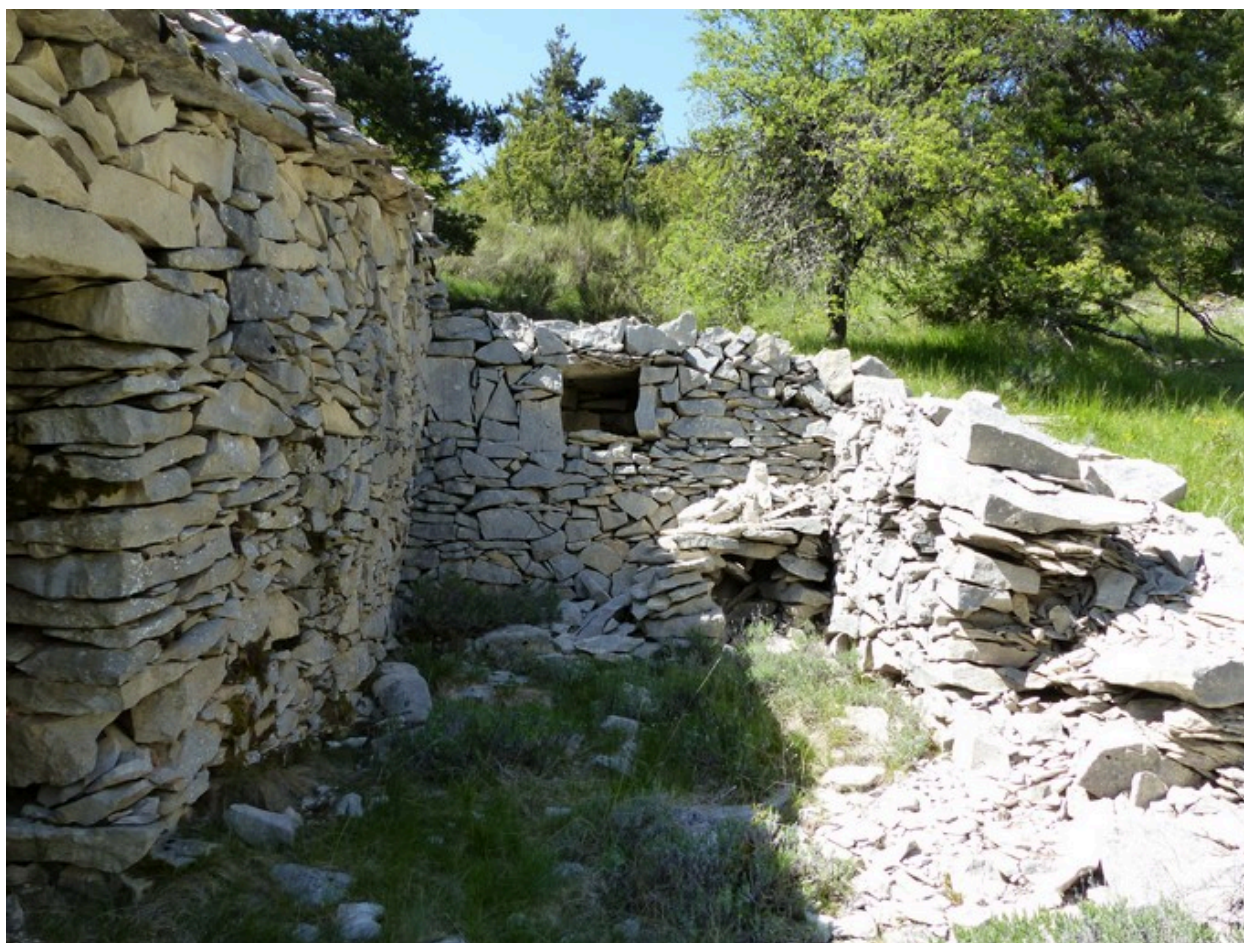
Enclos. Vue d'ensemble prise de l'est.
