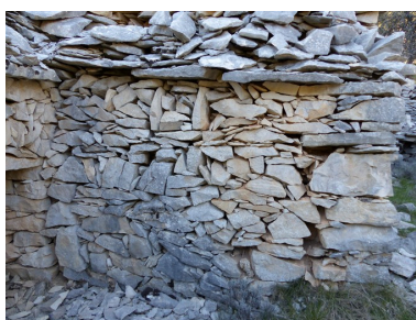
Cabane nord. Elévation est, collage de la maçonnerie. Phot. Alexeï Laurent IVR84_20162601195NUCA
