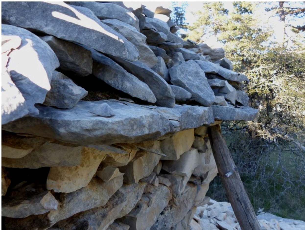
Cabane sud. Elévation est, avant-toit en lauze formant larmier.
