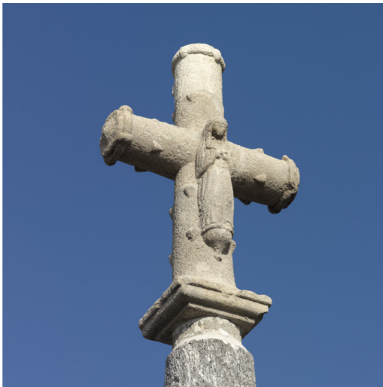
Vue d'ensemble du croisillon de trois-quarts, côté Vierge (état après restauration).
