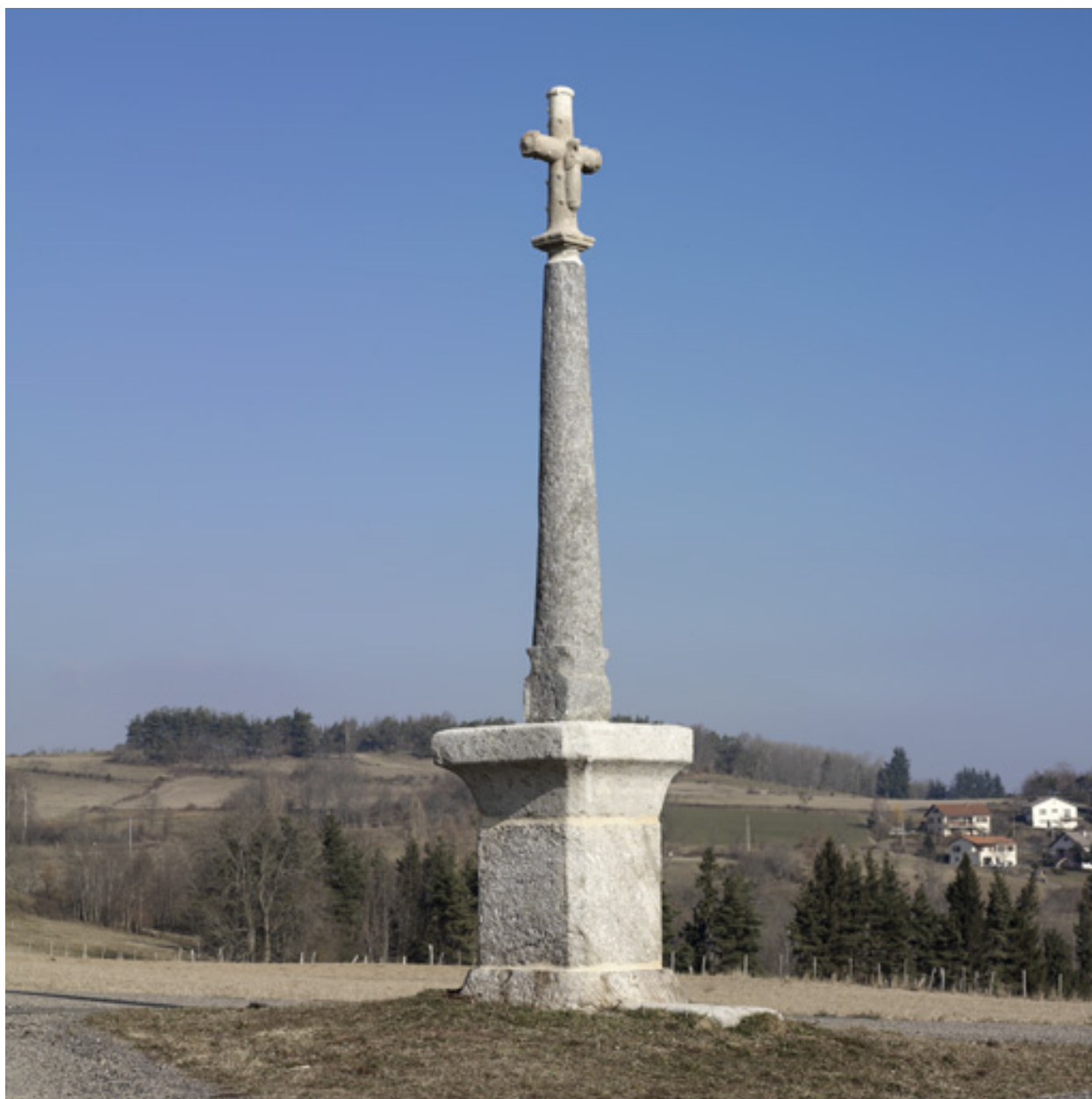
Vue générale (état après restauration).
