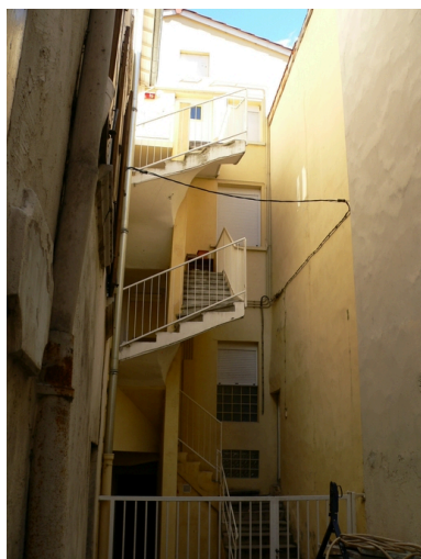
Escalier Phot. Isabelle Dupuis IVR82_20093800322NUCA
