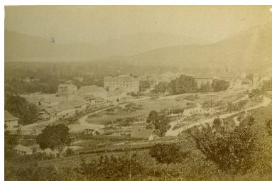
Le chalet au premier plan, à droite Repro. François Fouger IVR82_20067300136NUCB
