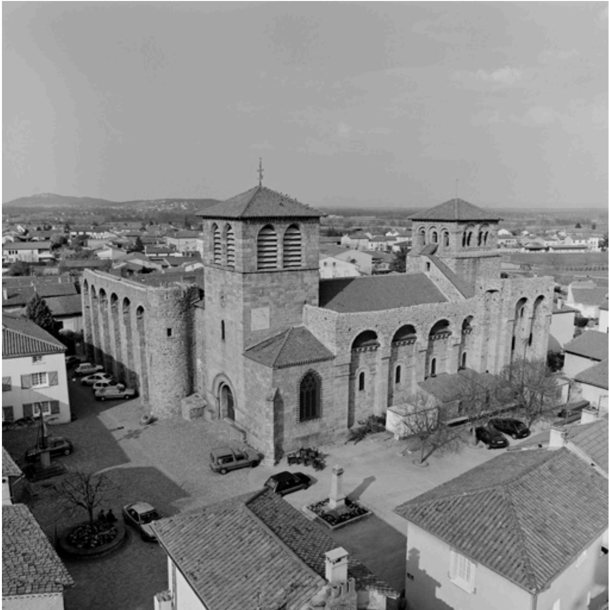
Vue générale depuis le sud-ouest.
