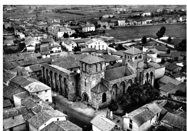
CIM. CHAMPDIEU (42. Loire). 183-54 A - Quartier de l'Eglise - Vue aérienne. COMBIER IMP. MACON. (71. S.-et-L.) 'CIM' 26. Photographie véritable - Reproduction interdite. Phot. Eric (reproduction) Dessert, Autr. CIM [Combiér imprimeur à Mâcon] IVR82_20054201470NUCB
