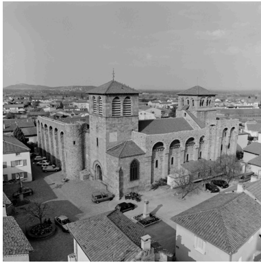
Vue générale depuis le sud-ouest. Phot. Eric Dessert IVR82_20064200044X
