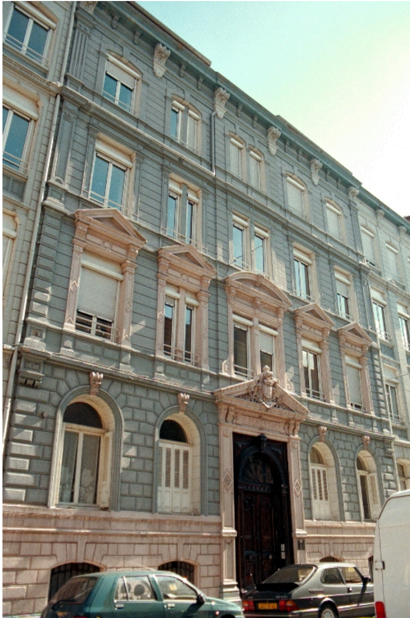
Façade principale. Etat en 1996
