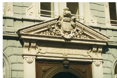
Détail du fronton Phot. Ville de Saint-Étienne Alain Fayard IVR82_20084200567NUCA
