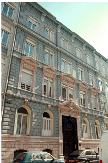
Façade principale. Etat en 1996 Phot. Cendrine Sanquer IVR82_19974201858ZE
