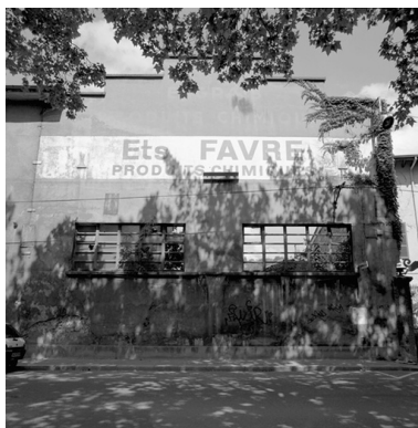
Détail façade avec enseigne Phot. Martial Couderette IVR82_20016903178X
